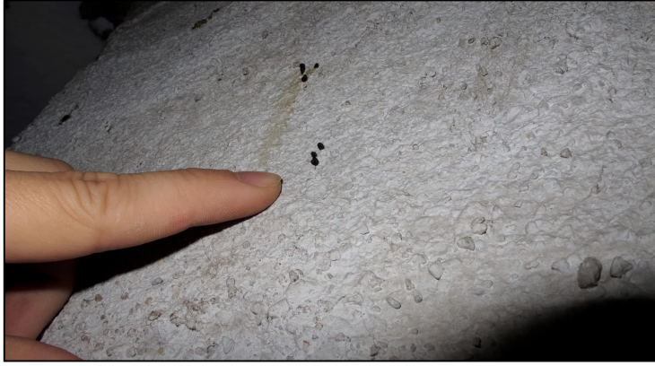
Kuva 2. Rakennuksessa nro 10 löydettiin lepakoiden papanoita hormin kyljestä.
