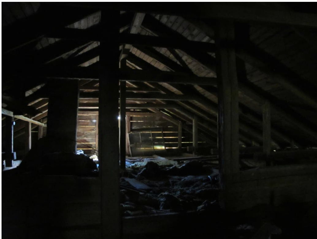
Kuva 5. Prijuutin purettavan rakennuksen ullakko.
