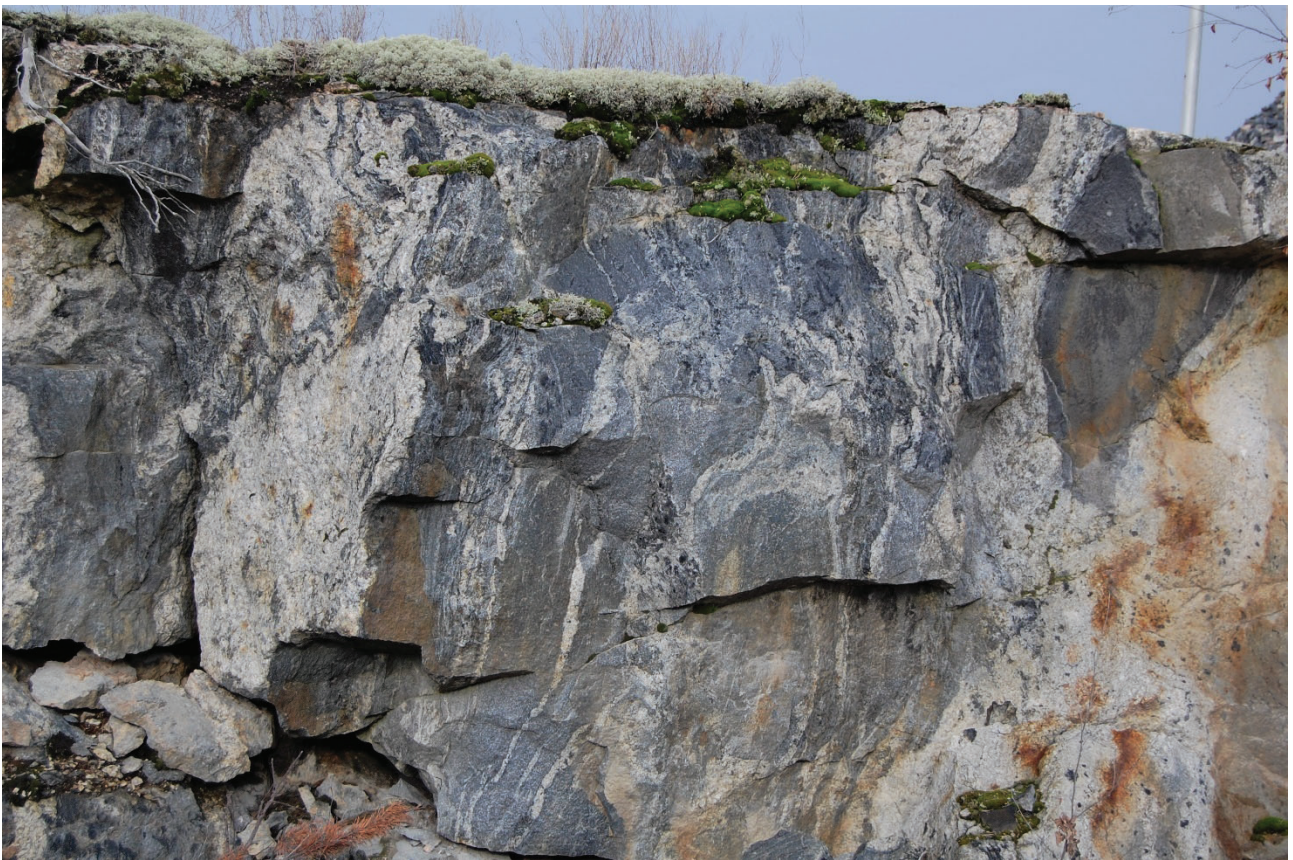
Graniitin ja kiillegneissin muodostamaa migmatiittia tuoreessa kallioleikkauksessa.
