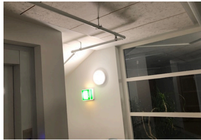
Sprinkleriputkisto
