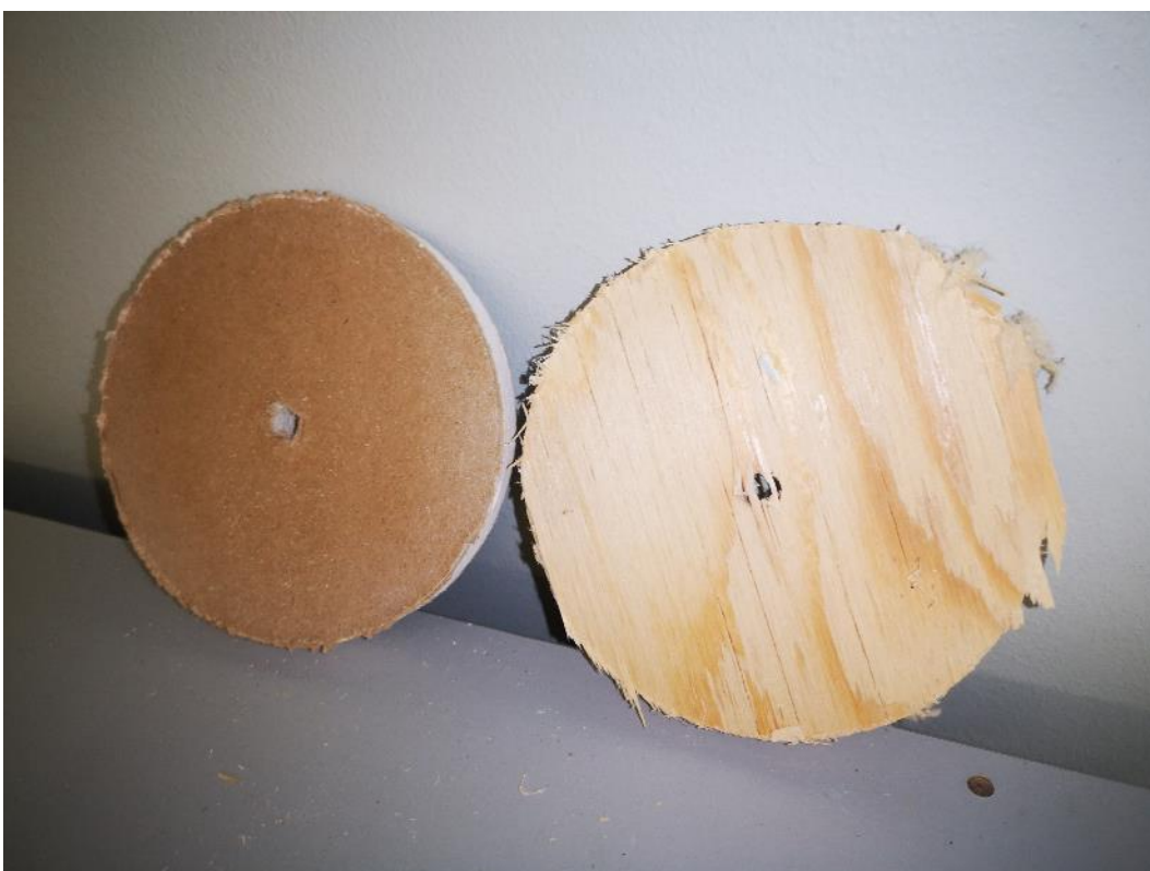
Kuva 5. Rakenneavaus luokkahuoneen 55 ulkovaipparakenteen yläosaan (JS1Y). Höyrynsulkumuovin sisäpuoleisessa vanerilevyssä ja kipsilevyssä ei havaittu vaurioita.
