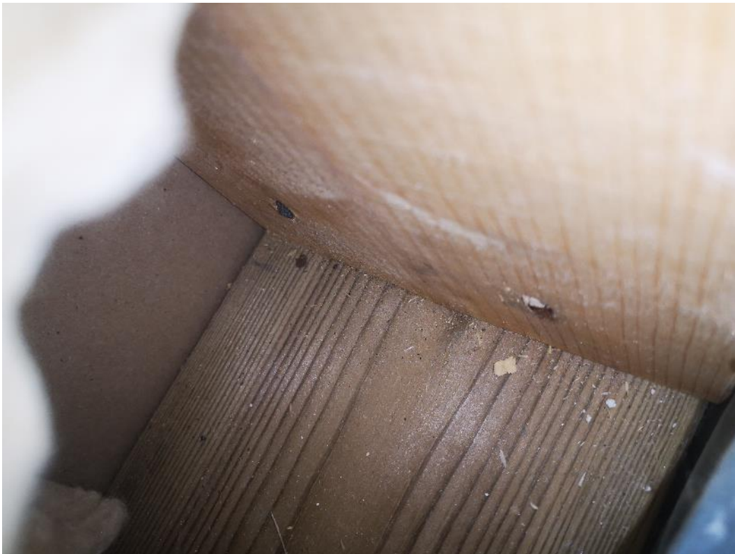
Kuva 9. Rakenneavaus luokkahuoneen 56 ulkovaipparakenteen alaosaan (JS2A). Höyrynsulkumuovin ulkopuolella ei havaittu vaurioita rakennusmateriaaleissa.
