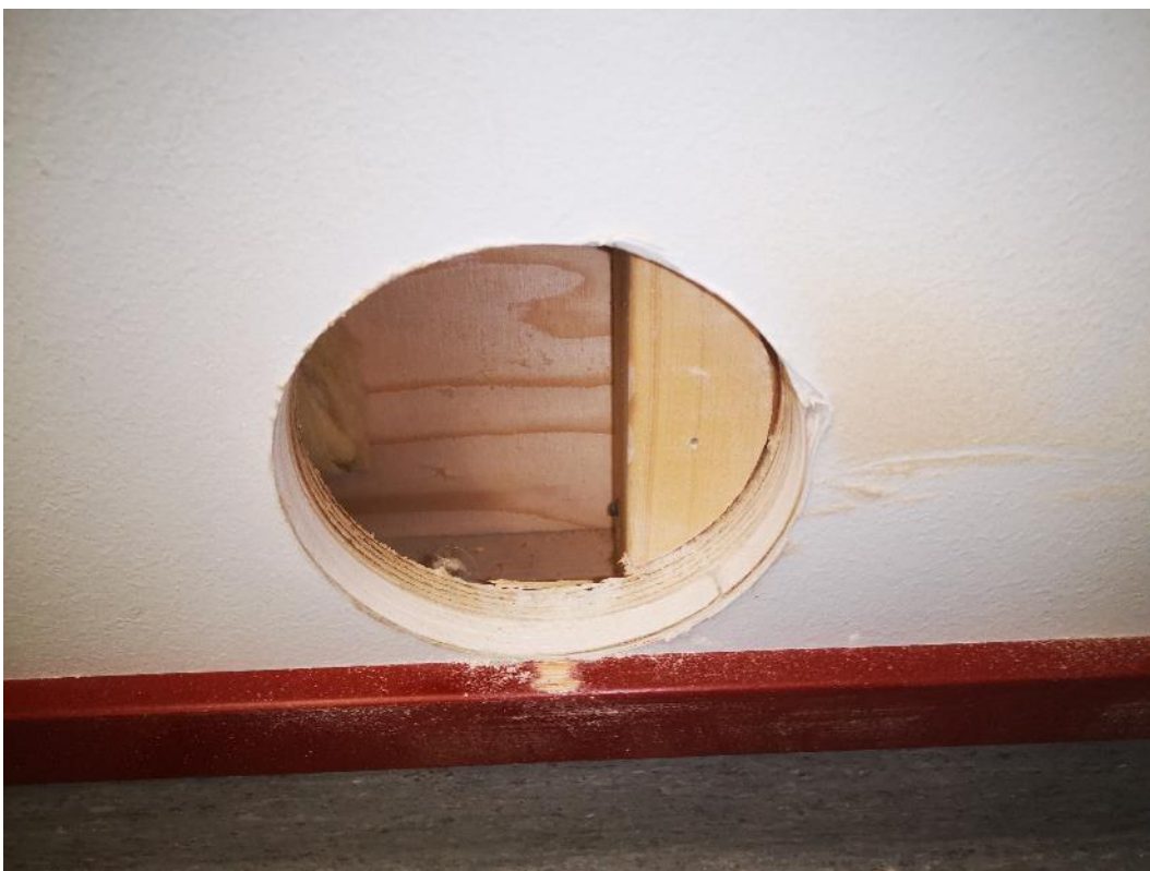
Kuva 18. Rakenneavaus luokkahuoneen 56 väliseinärakenteeseen (VS1). Väliseinän rakenteissa ei havaittu vaurioita.
