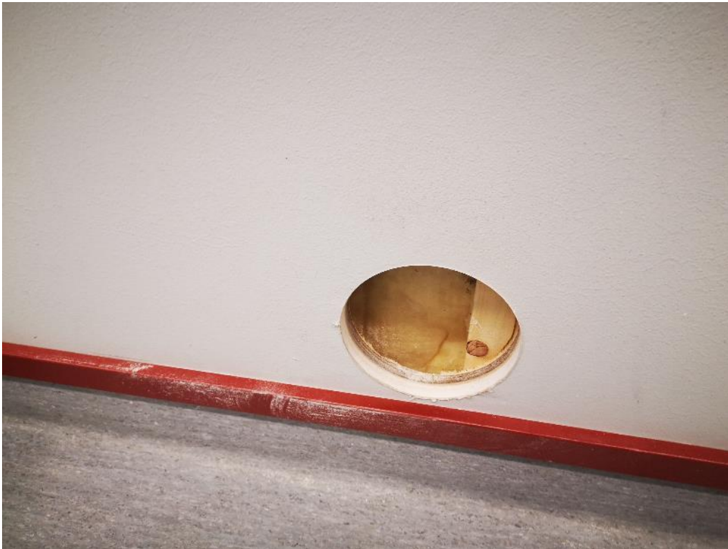
Kuva 17. Rakenneavaus luokkahuoneen 55 väliseinärakenteeseen (VS1).
