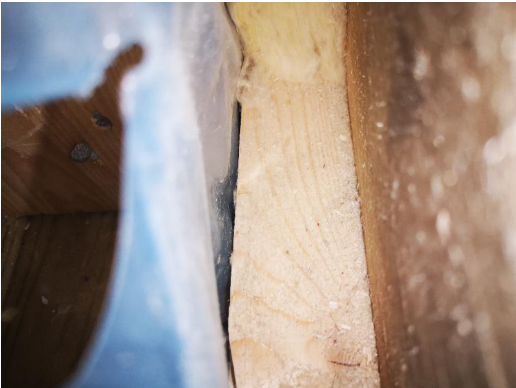
Kuva 3. Rakenneavaus luokkahuoneen 55 ulkovaipparakenteen alaosaan (JS1A) höyrynsulku muovin sisäpuolelta.
