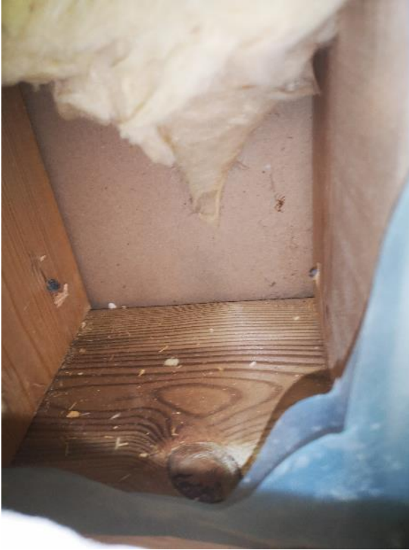
Kuva 16. Rakenneavaus luokkahuoneen 58 ulkovaipparakenteen alaosaan (JS3A). Höyrynsulkumuovin ulkopuolella ei havaittu vaurioita rakennusmateriaaleissa.
