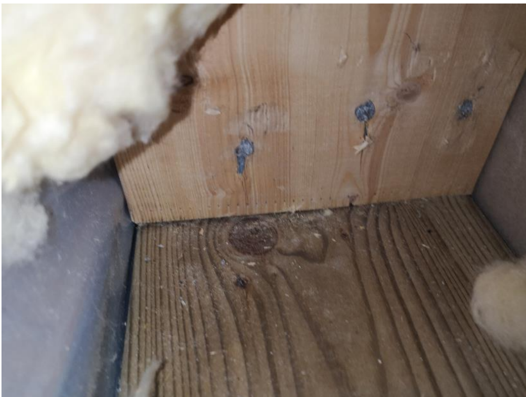
Kuva 4. Rakenneavaus luokkahuoneen 55 ulkovaipparakenteen alaosaan (JS2).
