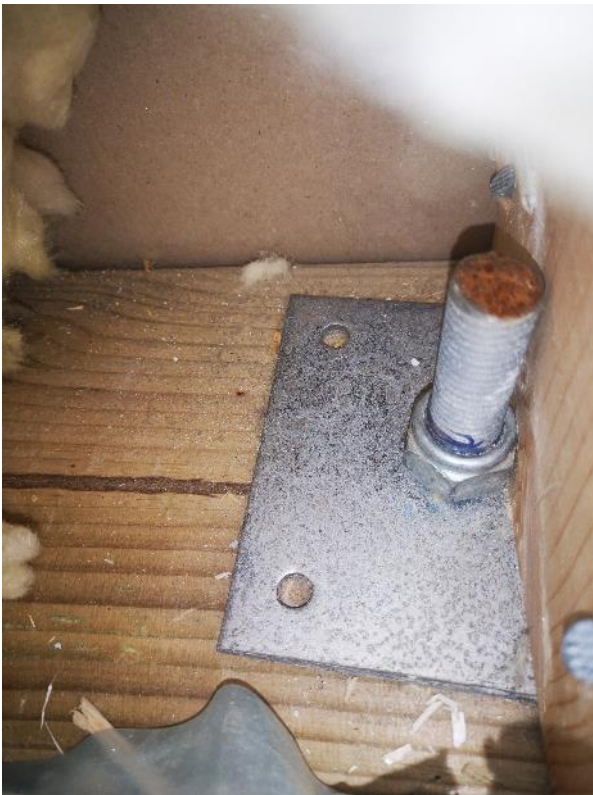
Kuva 7. Rakenneavaus luokkahuoneen 56 ulkovaipparakenteen alaosaan (JS1A). Höyrynsulkumuovin ulkopuolella ei havaittu vaurioita rakennusmateriaaleissa.
