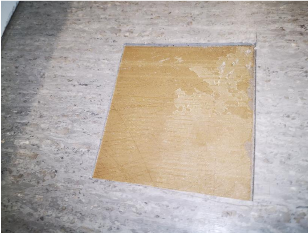
Kuva 21. Luokkahuoneen 56 lattian muovimaton kiinnitys alustaan oli hyvä ja liima oli heikosti kumimainen. Liima tuoksui heikosti kemikaalimaiselle.
