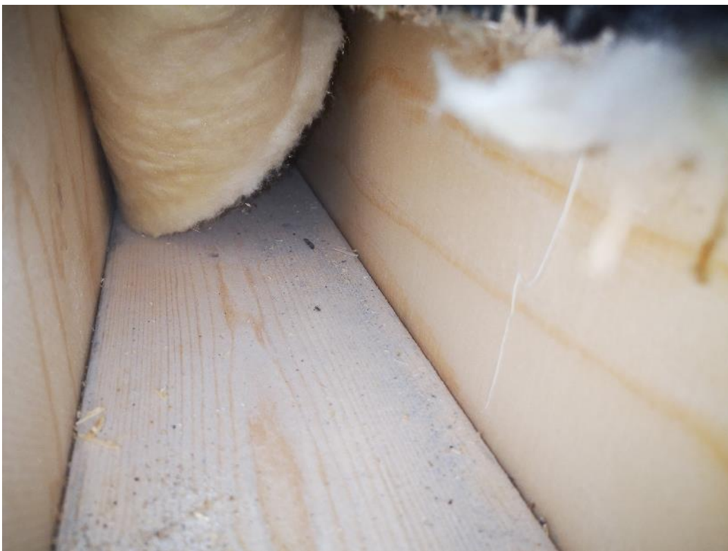
Kuva 17. Rakenneavaus luokkahuoneen 55 väliseinärakenteeseen (VS1). Väliseinän rakenteissa ei havaittu vaurioita.
