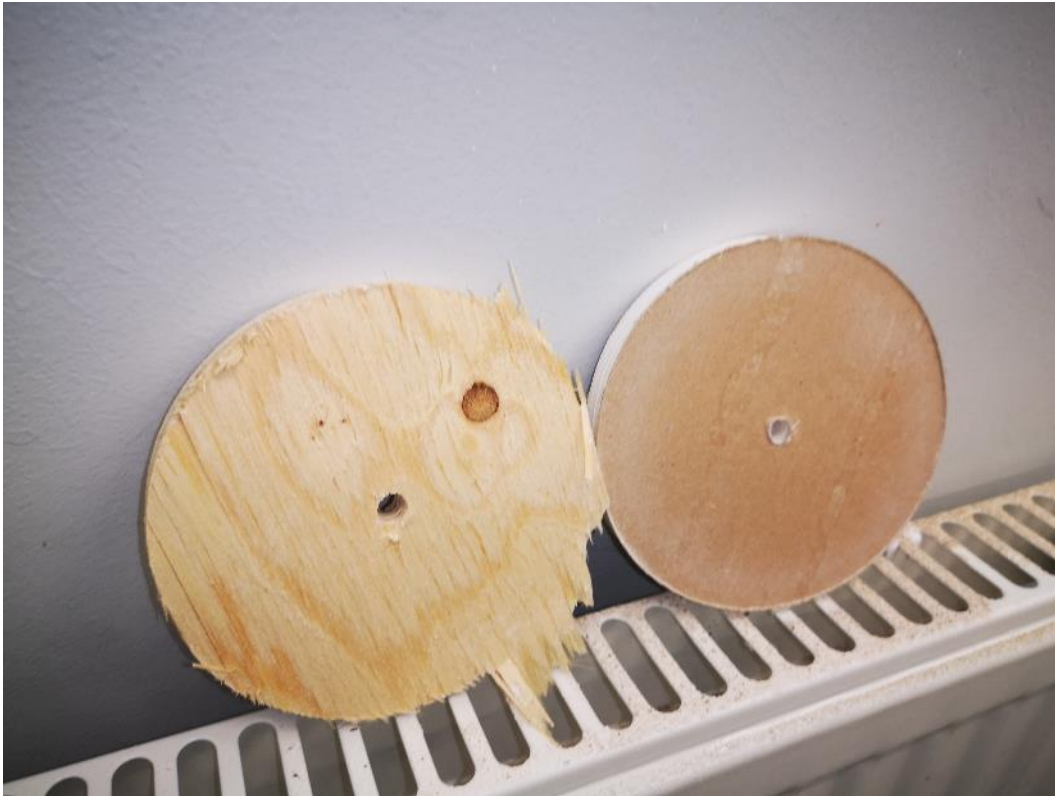
Kuva 14. Rakenneavaus luokkahuoneen 58 ulkovaipparakenteeseen (JS2) ikkunan alapuolelta. Höyrynsulkumuovin sisäpuoleisessa vanerilevyssä ja kipsilevyssä ei havaittu vaurioita.
