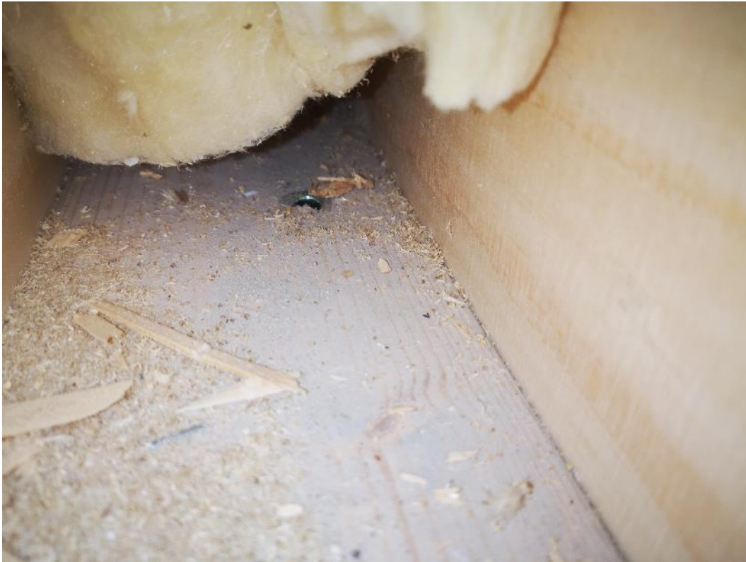
Kuva 19. Rakenneavaus luokkahuoneen 56 väliseinärakenteeseen (VS1). Väliseinän rakenteissa ei havaittu vaurioita.
