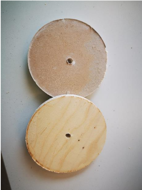
Kuva 8. Rakenneavaus luokkahuoneen 56 ulkovaipparakenteen yläosaan (JS1Y). Höyrynsulkumuovin sisäpuoleisessa vanerilevyssä ja kipsilevyssä ei havaittu vaurioita.
