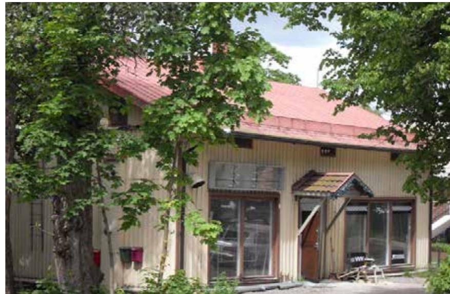
213 Isä Arsenin pappilan pääjulkisivussa näkyy hyvin 1950-luvun osuuskauppa-arkkitehtuuri suurine näyteikkunoineen. Tästä arkkitehtuuripiirteestä voidaan tarvittaessa luopua. 213_arsenin_pappila_SDC11459.jpg
