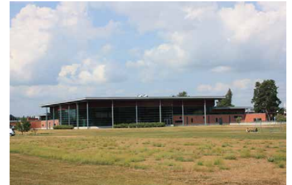
33 Tuusulan uimahalli varuskunnan pelikentältä kuvattuna. 33_uimahalli_IMG_0641.jpg
