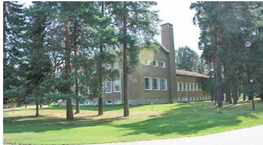
36M Rapattu tiilirakenteinen ruokalarakennus vuodelta 1952. 36_M_ruokala_IMG_0582.jpg
