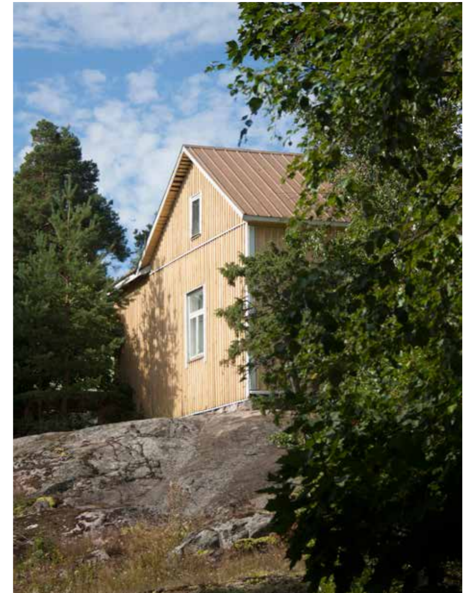
222 Kotikallio, vinkkeli lisäosa piiloutuu hyvin talon ja kasvillisuuden taakse. 222_kotikallio_IMG_4554_1.jpg
