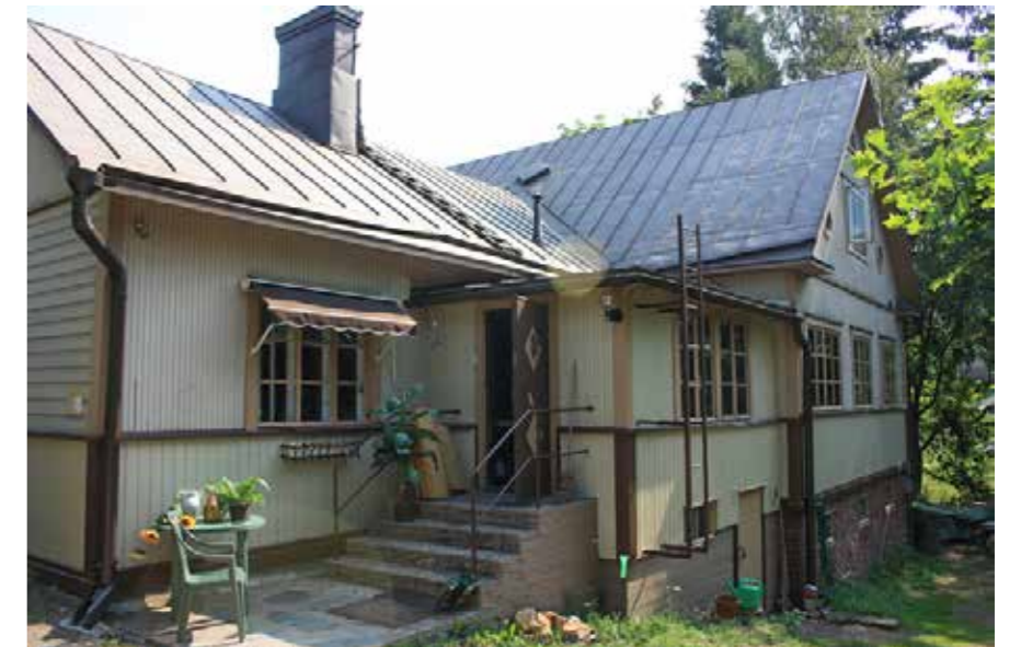
43B Koskelan huvila pihan puolelta. 43_B_koskela_IMG_0395.jpg
