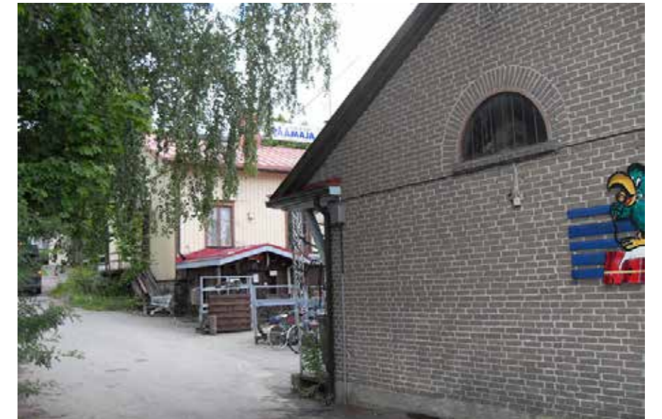
213 Isä Arsenin pappila takapihan puolelta: vanhat kuusiruutuiset ikkunat ovat jäljellä. Etualalla ulkovarasto 213A. 213_arsenin_pappila_SDC11461.jpg
