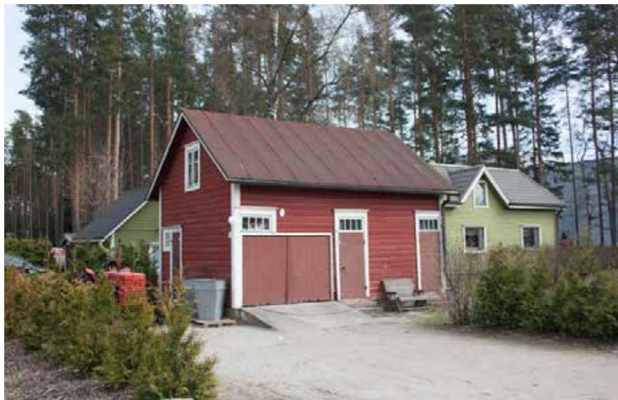
Santamaankuja 12 ja 14. Punainen rakennus on 14:n ulkorakennus. 28_santamaentie_IMG_7081.jpg
