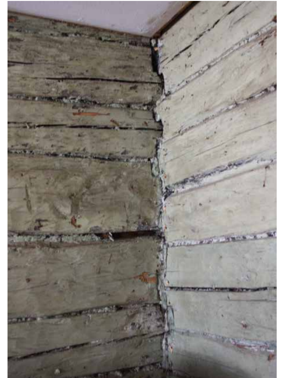
40 Puustellin esiinotettua savirappauspintaa. 40_puustelli_saksa_savipinta_IMG_0662.jpg
