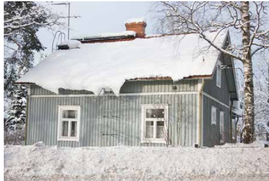
43P Paijalantien Tienhaaran päärakennus edustaa alkuperäisessä asussa säilynyttä rakennuskantaa. 43_P_tienhaara_IMG_3980.jpg
