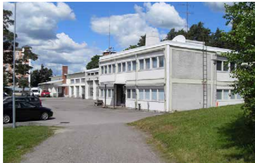
32 B Hyrylän vanhan paloaseman uudisosa 32_C_paloasema_SDC11424.jpg
