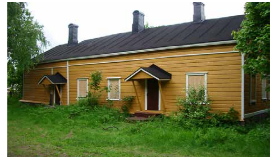
28. Prijuutin sisääkäynnit. Vasemmanpuoleisessa sisäänkäynnissä ei ole ollut alkuaan katosta ja oikeanpuoleinen on ollut suurehko umpikuisti. Kuva Panu Savolainen. 28_prijuutti_savolainen_IMG0379.jpg
