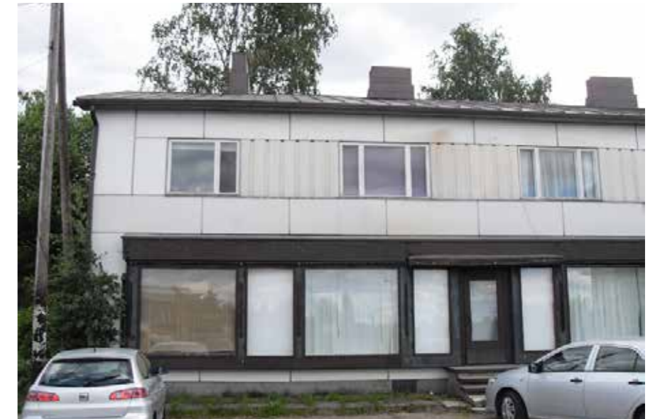
216 Haikosen kirjakauppa on muodistettu 1960-luvulla. Pohjalla on 1910-20-luvun tyyppillinen hirsirakenteinen kauppiastalo. 216_B_haikosen_talo_SDC11444.jpg
