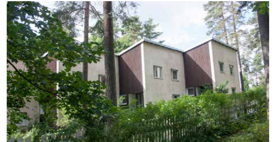
29C Amerin itäinen rivitalo ja kahdesta eri materiaalista jäsennellyt julkisivut. Samoja materiaaleja: tummaksi petsattua puurimaa ja vaaleaksi rapattua pintaa käytti jo Alvar Aalto 1930-luvulla omassa talossaan Munkkiniemen Riihitiellä. 29_C_amerin_itainen_rivitalo_IMG_4536_1.jpg
