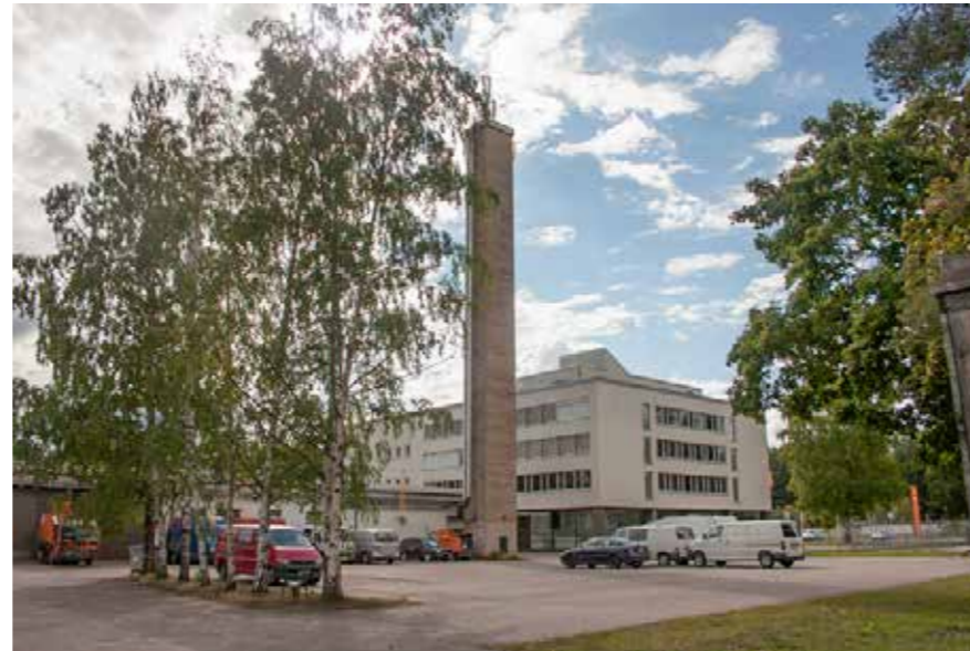
29A Amerin tupakkatehtaan konttorirakennus ja maamerkinä toimiva savupiippu. 29_A_amerin_tupakkatehdas_IMG_4541_1.jpg
