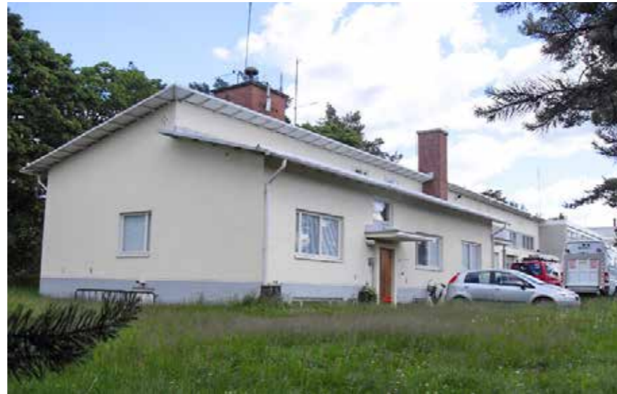
32 B Hyrylän paloaseman vanhan puolen palopäällikön asunto edustaa 1950-luvulle tyypillistä rapattua tiilirakentamista. 32_C_paloasema_SDC11427.jpg
