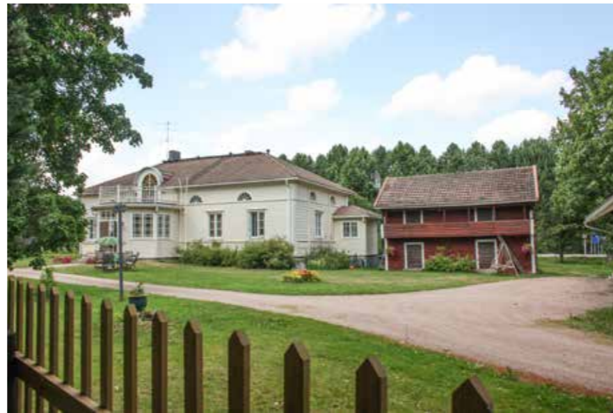
38 Klaavon päärakennus ja 38A Klaavon pariluhti. 38_klaavo_pihapiiri_IMG_0687.jpg
