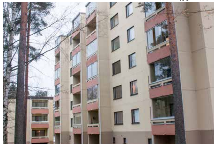
211A Elementtirakentamista puhtaimmillaan, eroavaisuudet toteutettu kerrostosten määrällä ja värityksellä. Parvekelasitus on 2000-luvun lisäys asumismukavuuteen. 211_A_mahlamaki_IMG_8106.jpg
