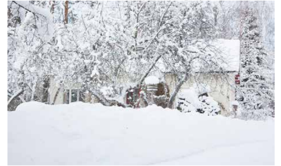
43S Etelärinteen matala ja pitkänomainen talo piiloutuu rehevän puutarhan taakse. 43_S_etelarinne_IMG_3906.jpg
