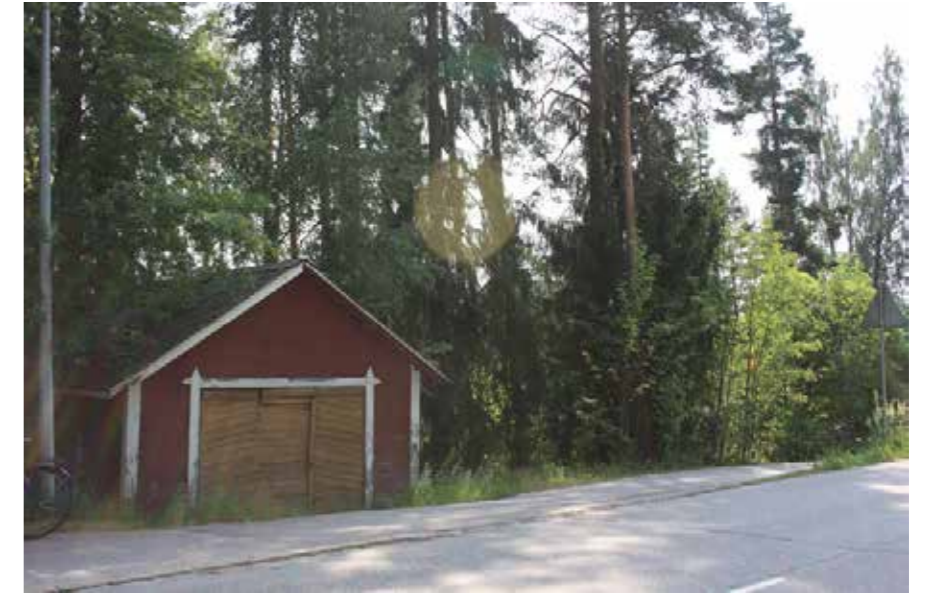
44B Saunapirtin autovaja. 44_B_saunapirtin_autovaja_IMG_0417.jpg
