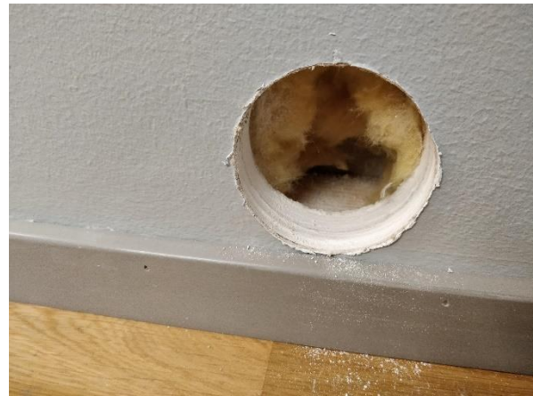
Kuva 7: Kissankulman lepohuoneen ja keittiön välinen väliseinä.
