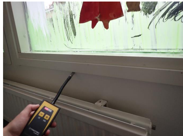
Kuva 3: Rakenneliittymissä havaittiin ilmavuotoja.
