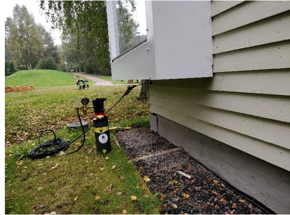
Kuva 18: Merkkiainetta laskettiin ulkoseinän eristekerrokseen ulkopuolelta.
