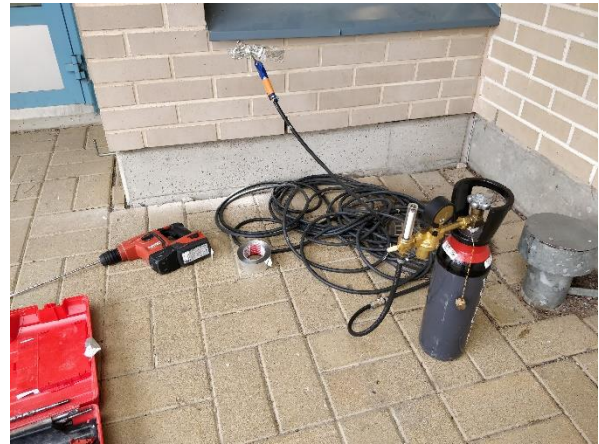
Kuva 10: Merkkiainetta laskettiin ulkoseinän eristetilaan.
