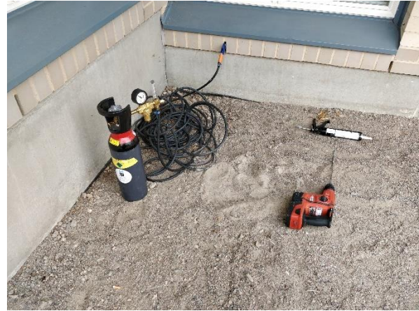
Kuva 12: Merkkiainetta laskettiin ulkoseinän eristetilaan tuuletusraon kautta.
