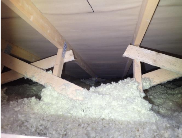
Kuva 17: Yläpohjan ja ulkoseinän rakenneliittymän tiiveyttä tarkasteltiin yläpohjan eristetilaan lasketulla merkkiaineella.
