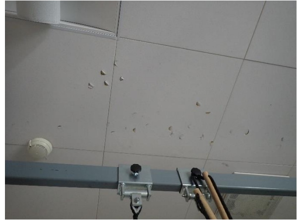
Kuva 5: Nirhautuneet akustolevyt on suositeltavaa vaihtaa.
