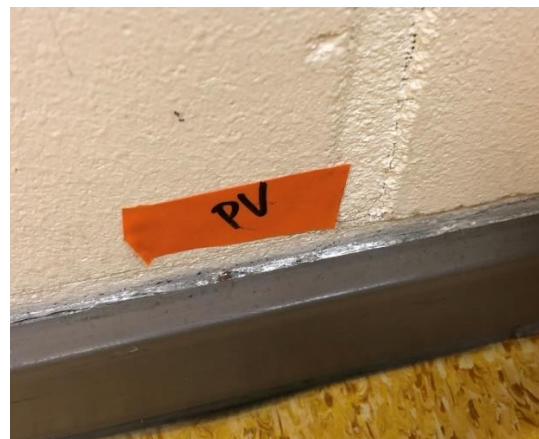
Kuva 24 Pistemäinen ilmavuoto lattialistassa olevasta reiästä
