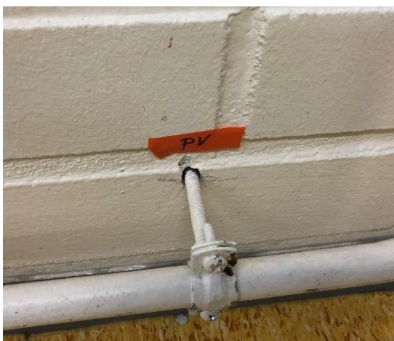
Kuva 32 Pistemäinen ilmavuoto patteriputken kannakkeesta
