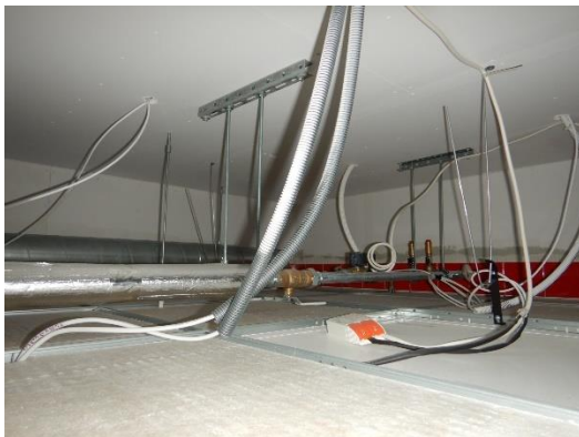
Kuva 9. Alakattolevytyksen ylätila eteistilassa B161
