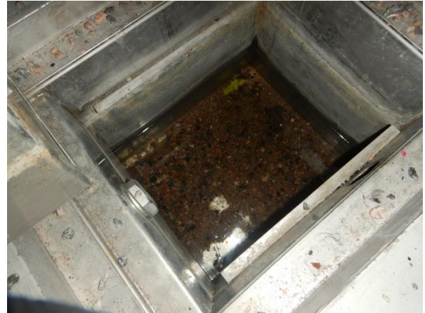
Kuva 3. Lattiakaivon pohjalla hiekkaa. Kuvassa kaukalo on nostettu pois kaivosta. Märkäeteinen B161.
