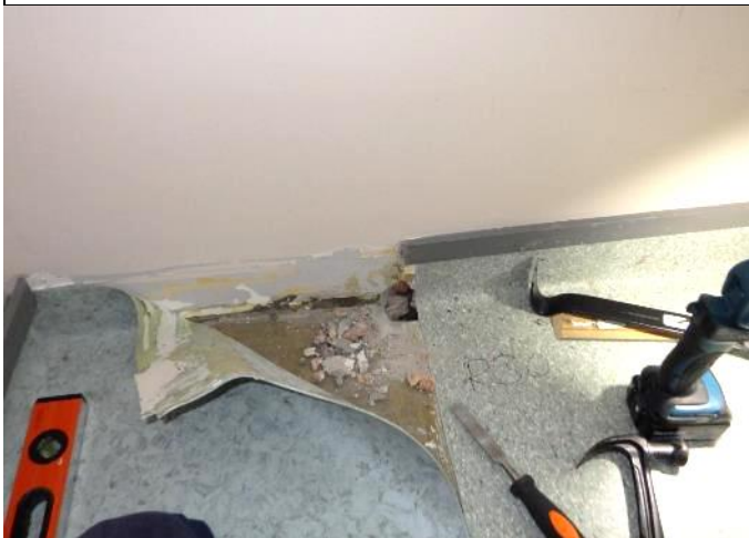
R30 tehtiin paikkaan, johon homekoira on tehnyt ilmaisen. Kuvassa näkyy vanhan ja uuden (vasemmalla) muovimaton raja.
