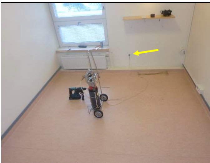
Merkkiainekoe MA5 suoritettiin A-osan 1. kerroksen huoneen ulkoseinään. Sijainti on esitetty paikannuspiirustuksessa 4.
