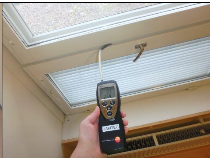
Merkkiainekokeiden aikana tiloissa mitattiin paine-erot ulkovaipan yli. Alipaine oli noin 2,5...3,5 pascalia ulkoilmaan nähden.
