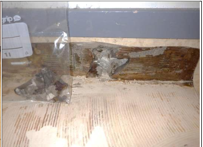
Aistinvaraisesti lattian ja seinän muovimatto on pahasti mikrobivaurioitunut. Sekä ulkoseinän että lattian maton liimasta ja tasoitteesta otettiin mikrobinäytteet.
