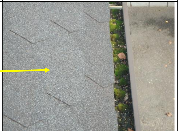
Kourun on kertynyt sammalkasvustoa ym. likaa.
