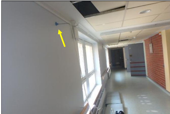
Merkkiainekoe MA8 tehtiin B-osan 1. kerroksen käytävän ulkoseinään.
