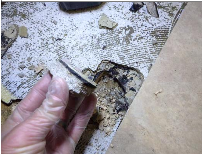
Lattian tasoitteesta ja massasta otettiin mikrobi-näyte MIR11.
