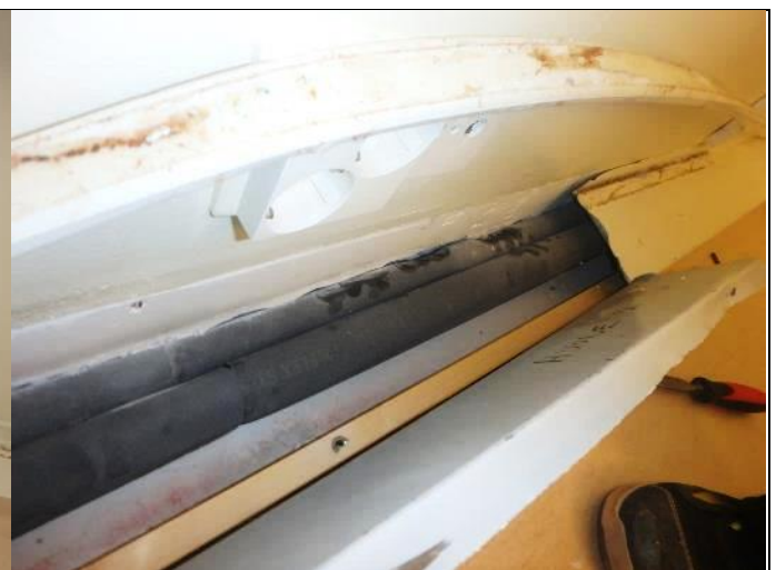
Lämmitysputkikotelo avattuna.
