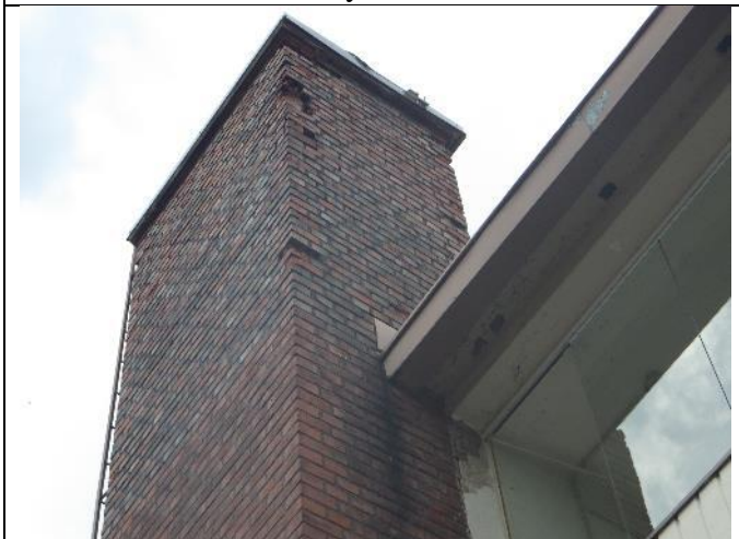
Piipusta putoilee jo tiilenosia alas tästä nurkasta.
