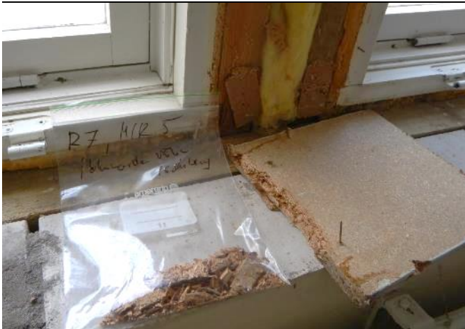
Ikkunavälin levy poistettiin ja havaittiin sen ulkopinnalla olevia kosteusjälkiä. Materiaalista otettiin mikrobinäyte MIR5.
