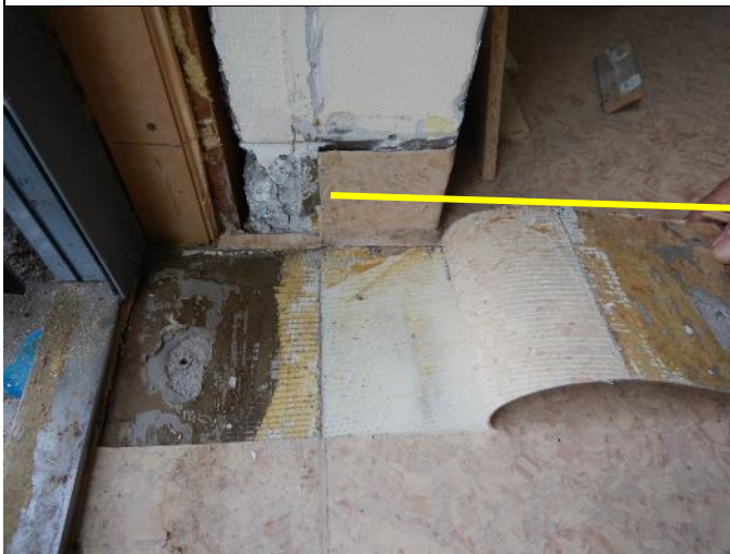
R8 tehtiin aulan ulko-oven kynnykseen ja laajennettiin rakenneavaus avaamalla ulkoseinän alaosan ja oven välinen liittymäkohta. Muovimatossa ei havaittu poikkeavaa.
