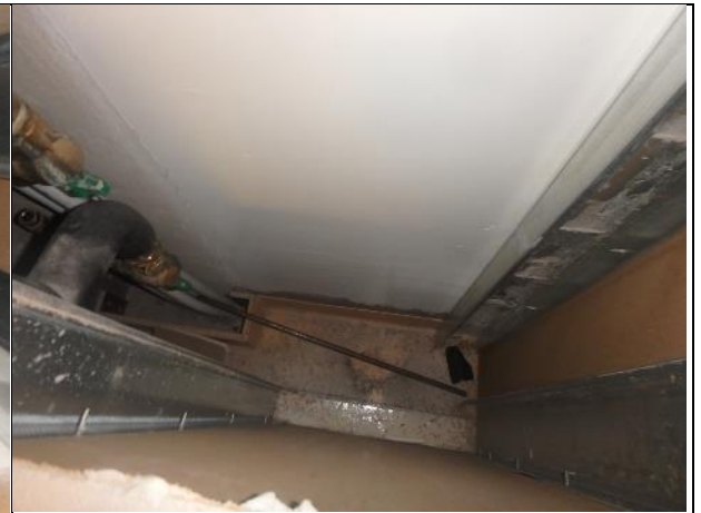
Kuvattuna alaspäin. Kuilujen pohjat ovat pääosin puhtaita.
