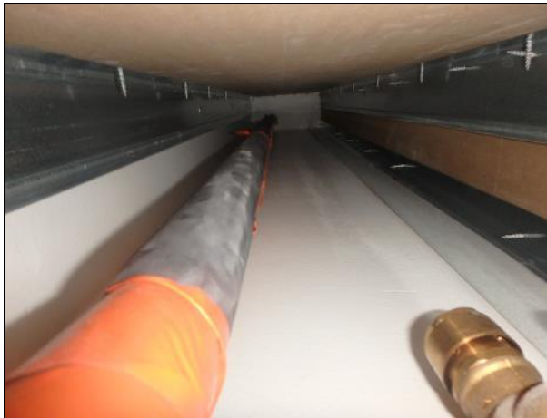
Talotekniikkakuilut tarkasteltiin koko tutkittavalta alueelta. Kuvassa on A-osan pohjakerroksessa sijaitsevan huoneen putkikuilu, kuvattuna ylöspäin.
