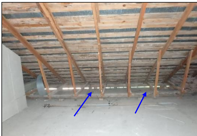
Räystäsalveilla näkyy kauttaaltaan tuuletusrakojia, silmämääräisesti katsottuna ullakotila tuulettuu hyvin.
