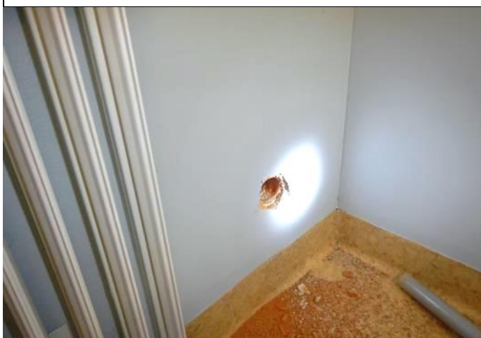
Rakennearaus R47 tehtiin poraamalla \varnothing 50 mm reikä ulkoseinään luiskan kohdalta (huone Puhtaat vaatteet). Rakennearauksessa aistinvaraisesti ei havaittu poikkeavaa.
