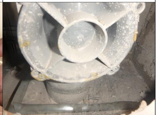
Viemäriputkien läpiviennit alapohjassa ovat valettu betonilla.
