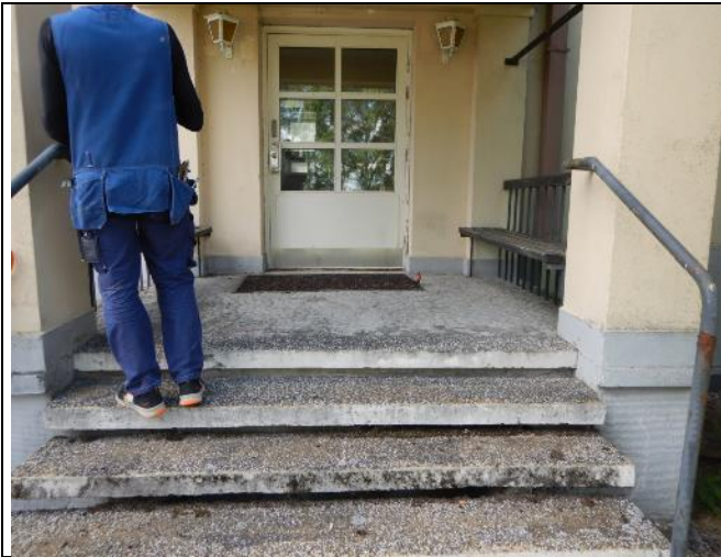
Sisäänkäynnin katoksen lattian on hyvässä kunnossa.
