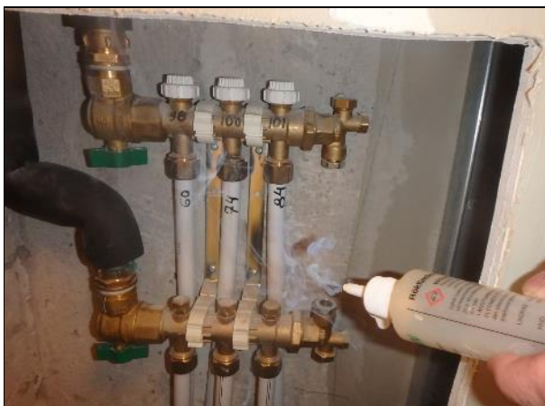
Kuvassa on saunaosaston lattialämmityspotkien kuilu, A-osan pohjakerros.
