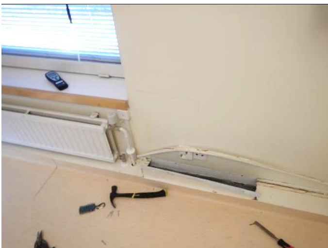
Rakenneavauspaikka R3. Sijainti on esitetty paikannuspiirustuksessa 2.
