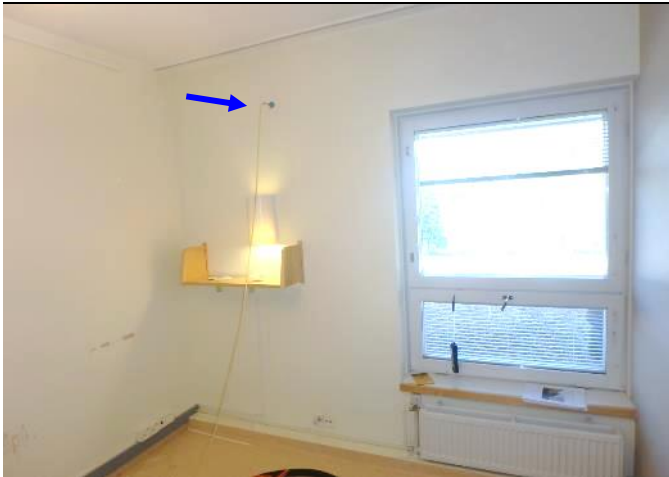
Merkkiainekoe MA7 tehtiin ulkoseinän yläosaan. Sijainti on esitetty paikannuspiirustuksessa 4.
