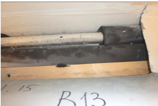
Rakenneavauspaikka R13. Sijainti on esitetty paikannuspiirustuksessa 4.
