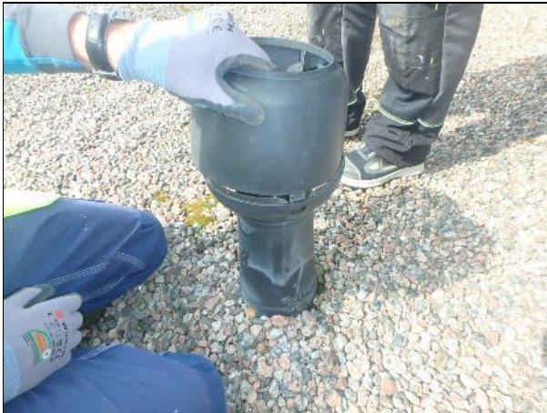
Yläpohja tuulettuu tuuletusputkien kautta.
