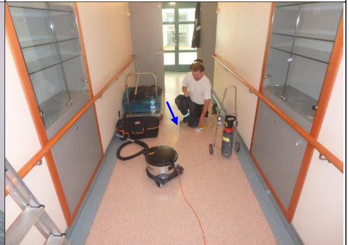
Merkkiainekoe MA17* suoritettiin 2. kerroksen käytävän lattiaan. Sijainti on esitetty paikannuspiirustuksissa 9 ja 10.
