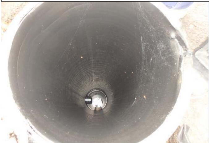
Kuvassa on D-osan ja asuntolan vieressä oleva salaojakaivo. Salaojaputket ovat 2,05 m syvyydellä maapinnalta.
