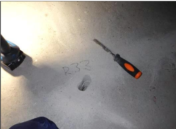
R33 tehtiin ullakkokerroksen lattiaan poraamalla reikä yläpohjan lämmöneristetilaan, josta tarkasteltiin yläpohjarakenne.
