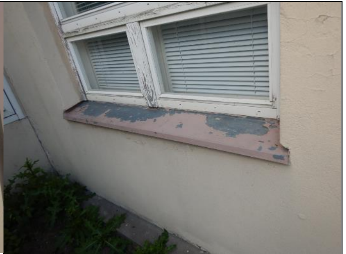
Samana päivänä ikkunapuitteista maali hilseilee, samoin vesipellistä.
