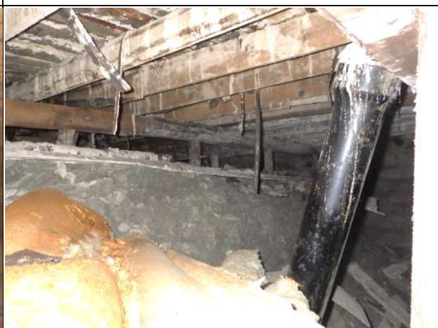
Tämä kuva on otettu putkikanaalin sisältä luiskan alle. Luiska näkyy esim. kappaleessa 6.1.1. Putkikanaali ja luiskan alustila ovat täydessä ilmayhteydessä keskenään.
