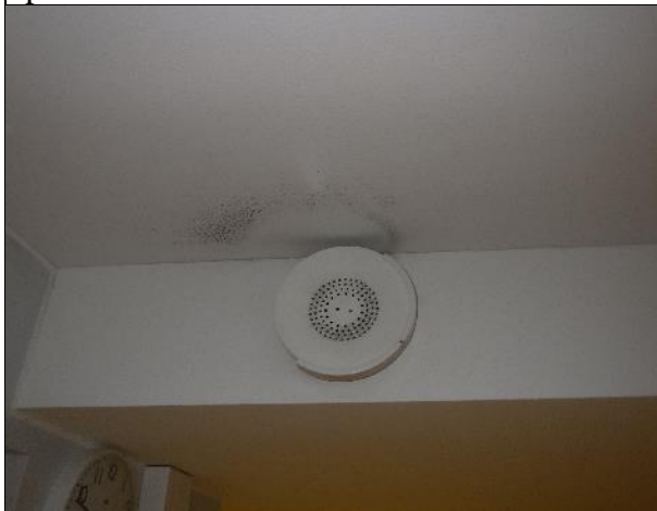
Näissä tämän tyyppin päätelaitteissa ei ole myöskään mineraalikulitulahdettä.
