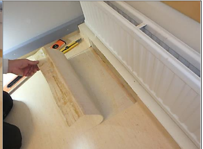
Aistinvaraisesti lattian muovimatto on kunnossa.
