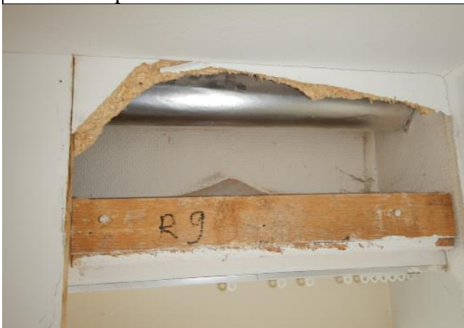
R9 tehtiin avaamalla kattorajassa olevan kotelon peitelevy, josta yritettiin tarkastaa yläpohja-ulkoseinäliittymä.
