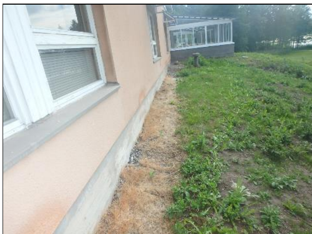
A-osan ulkosivun maan kaadot ovat rakennuksesta poispäin järvelle.
