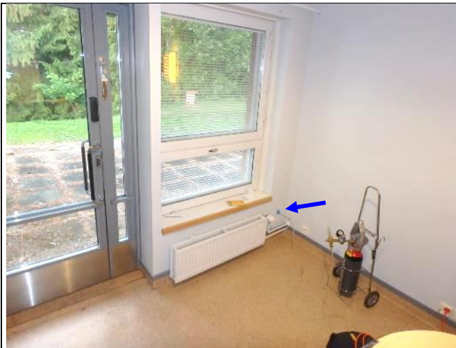
Merkkiainekoe MA4 suoritettiin A-osan pohjakerroksen olohuoneen ulkoseinään. Sijainti on esitetty paikannuspiirustuksessa 3.
