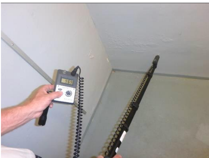
Rakenneavaus R36 tehtiin ulkoseinään siihen paikkaan, josta havaittiin pintakosteuskartoituksessa korkeat lukemat. Tässä kohdassa sisäpinnoite on irti alustastaan.
