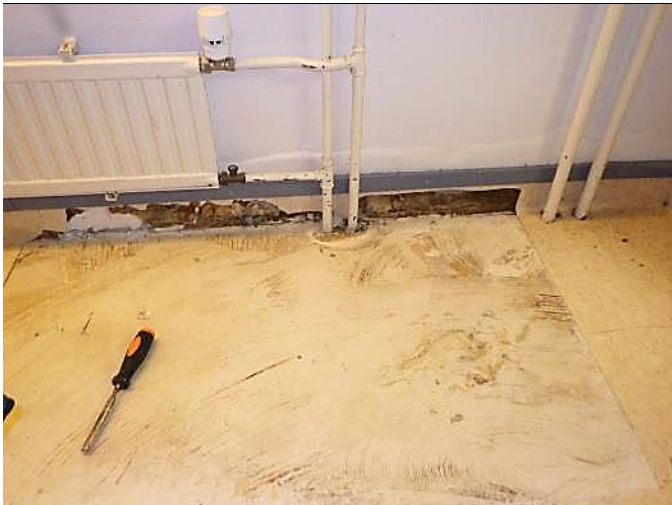
Rakenneavaus R17. Pintakosteuskartoituksen perusteella lattia oli erittäin kostea tässä paikassa. Sijainti on esitetty paikannuspiirustuksessa 7.
