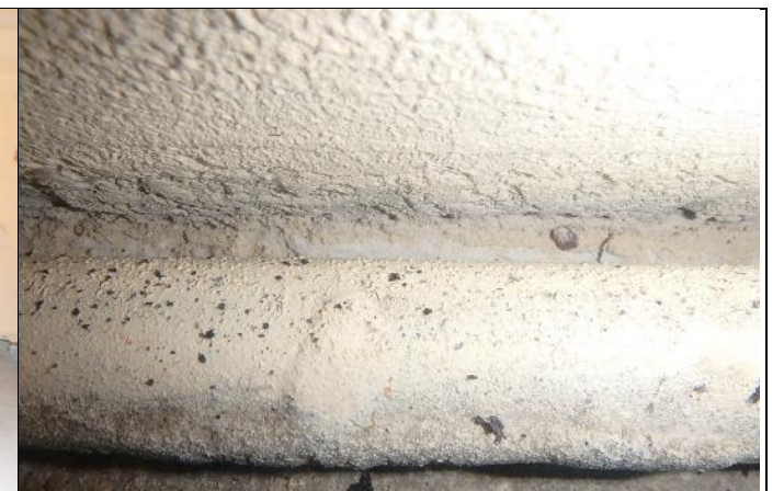
Lämmitysputkikotelo avattuna.
