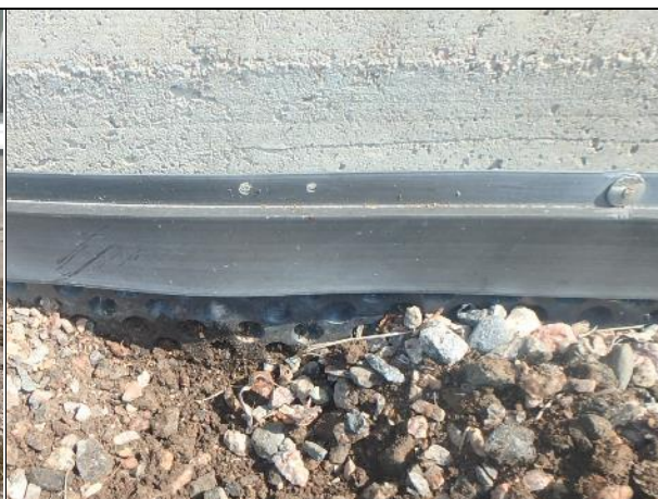
Kuva lähempää, jossa näkyy terassin perusmuurissa oleva patolevy.
