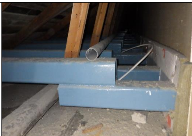
IV-konehuoneiden kohdalla on teräspalkit.
