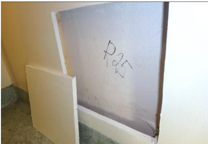
Rakenneavaus R25 tehtiin Tyyne -huoneeseen avaamalla ulkoseinän sisäverhouslevy. Sen takana havaittiin lisäkoolaus.
