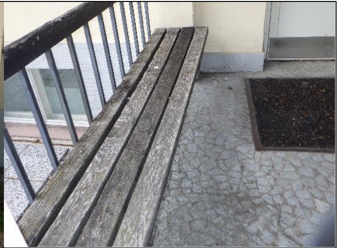
Penkkien puosat ovat uusimisen tarpeessa.
