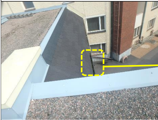
Kuvassa on keskiosan sadevesikouru.
