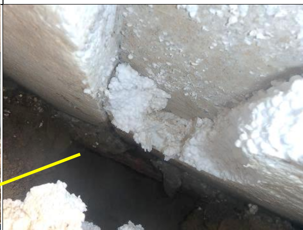
Kuvattuna sokkelipalkin alle. Kuvassa näkyy alapohjan lämmöneristeenä oleva 50 mm paksu styrox-levy.
