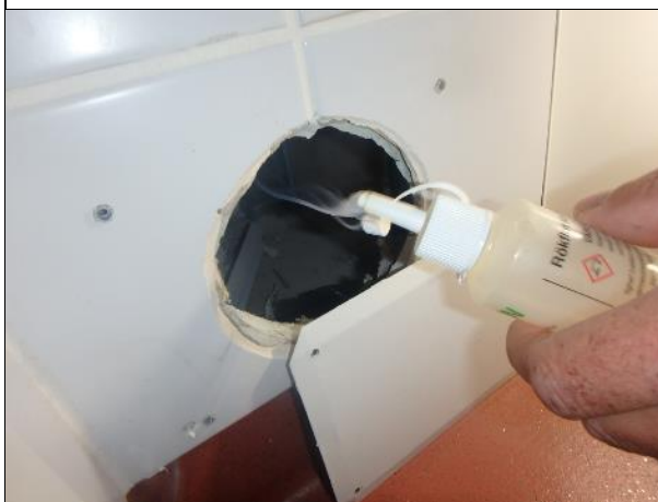
Talotekniikkakuilut ovat pääosin alipaineisia sisätiloihin nähden. Kuvassa A-osan ruokailutilassa oleva viemäriputken tarkastusluukku, jota tarkastetaan merkkisavulla.
