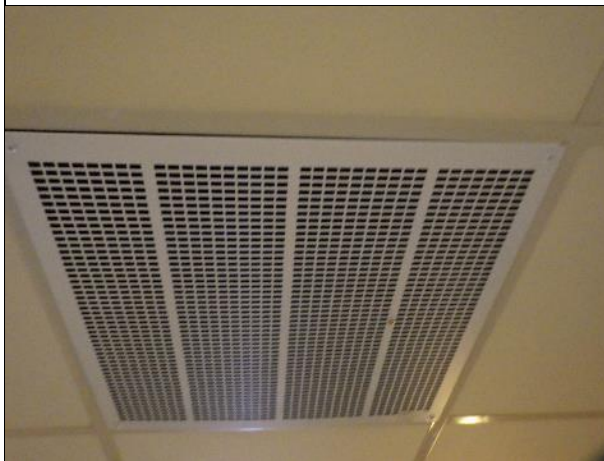
Nämä pohjakerroksen käytävillä olevat tuloilman päätelaitteet ovat myös kuituvapaita.
