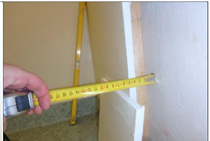
R25. Rakenneavauksessa todettiin, että tässä tilassa ulkoseinää kasvatettu sisäänpäin 50 mm lisäkoolauksella.
