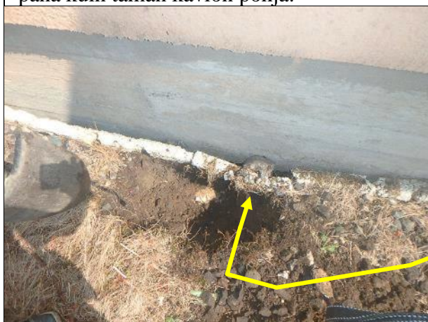
Kuvassa on A-osan ulkosivun perusmuuri. Samat havainnot kuin B-osassa. Täällä kairanto tehtiin sokkelipalkin jännevälillä, josta pystyttiin tarkastelemaan alapohjan lämmöneristettä.
