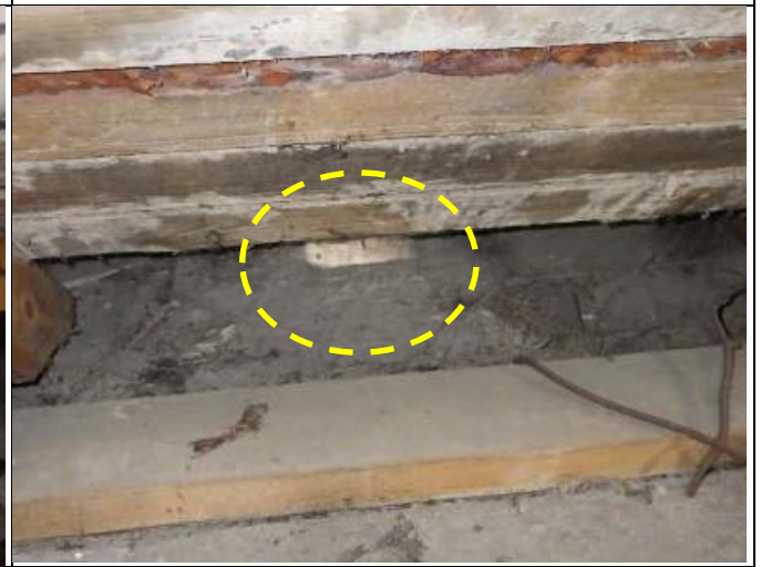
Havaintojen mukaan ullakkotila tuulettuu näiden aukkojen kautta, ok.
