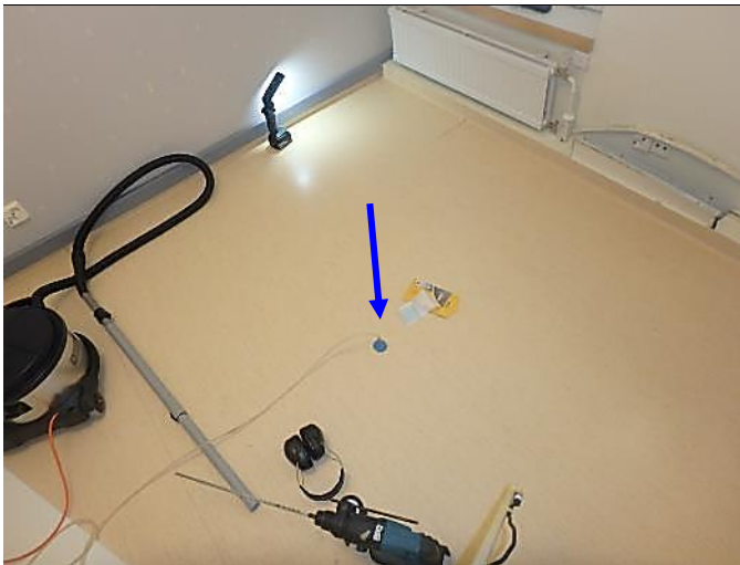
Merkkiainekoe MA1 suoritettiin B-osan pohjakerroksen huoneen lattiaan. Sijainti on esitetty paikannuspiirustuksessa 2.
