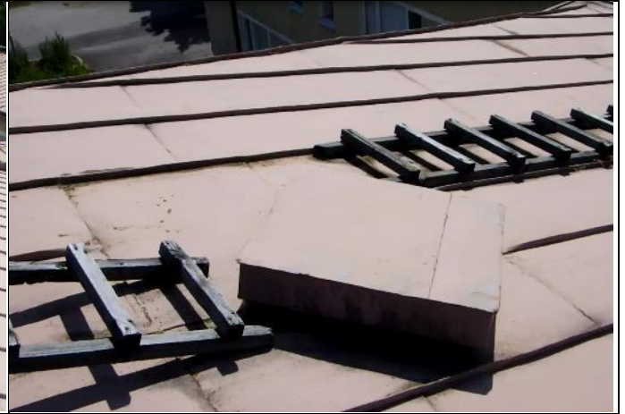
Samoin luukuille menevät lapetikkaat alkavat olla huonossa kunnossa.
