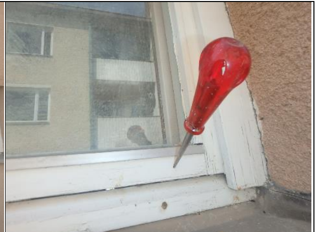
Ikkunapuitteet ovat pääosin hyväkuntoisia.
