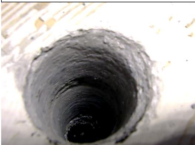
R16 laajennettiin poraamalla alapohjan läpi \varnothing 50 mm reikä, josta tarkasteltiin alapohjarakennetta.
