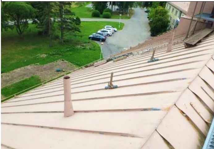
Etupihan lappeen vesikate on hyvässä kunnossa.
