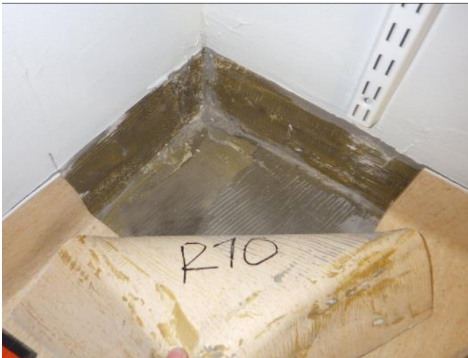
Rakennevaus R10. Sijainti on esitetty paikannuspiirustuksessa 2.
