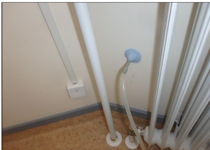
Merkkiainekoe MA25 suoritettiin D-osan 2. kerroksen oleskeluhuoneen ulkoseinään. Kuvassa merkkiainekaasun syöttökohta.
