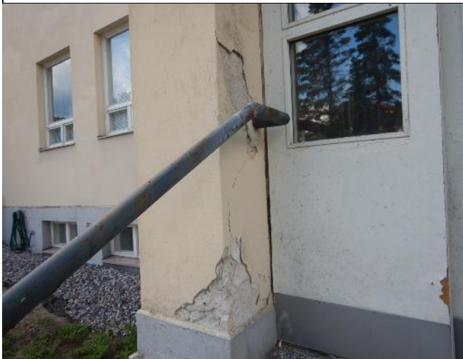
Pinnoitteet irtoilevat.
