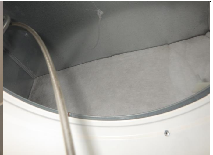
Niissä on äänieristeenä kokoojalaatikossa antiallerginen materiaali (Acutec).
