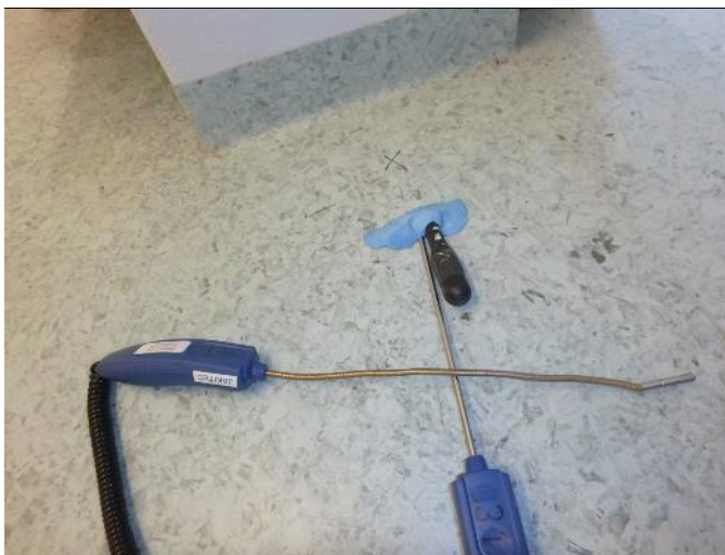
Rakenneseävaus R22 tehtiin Varastoon P209 avaamalla lattian pinnoitteena oleva muovimatto. Ennen avausta muovimaton alta mitattiin rakennesevasteen viiltomenetelmällä. Tulokset katso taulukossa 10.
