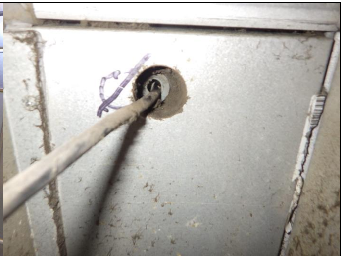
TK1/TF1 Raitisilmäpellin sähköjohdon läpiviennistä näkyy mineraalivillainen eriste.
