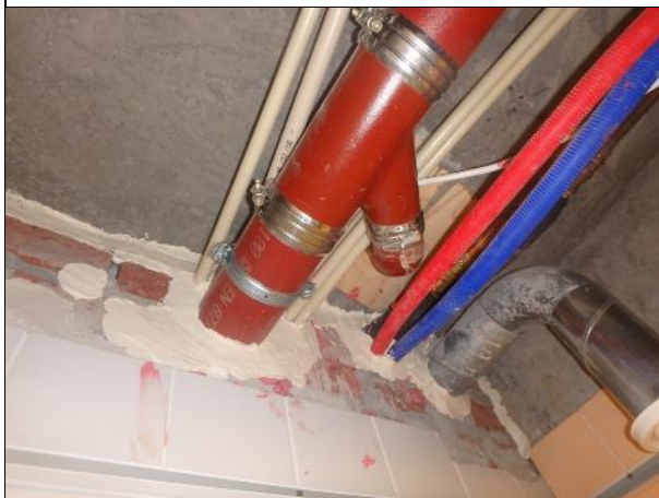
Kuvassa on märkätilan alas lasketun katon välitilassa olevat putket, joiden läpiviennit seinässä on tiivistetty massalla (B-osa).
