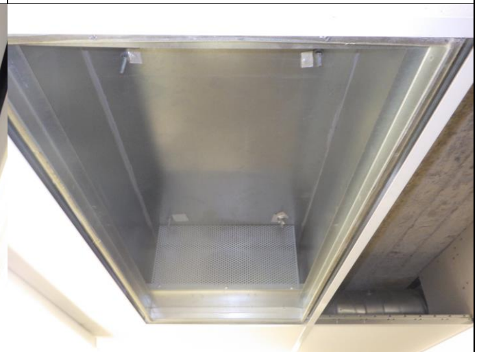
Niissä ei ole sisällä äänieristettä ollenkaan.
