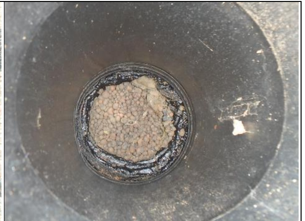
Lämmöneristeenä on Leca-sora.
