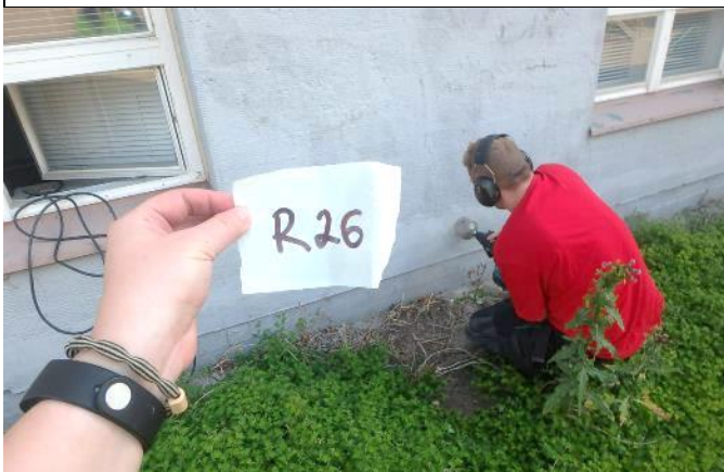
Rakenneavaus R26 tehtiin Helmi -huoneen ulkoseinään poraamalla \varnothing 50 mm reikä ulkoapäin.
