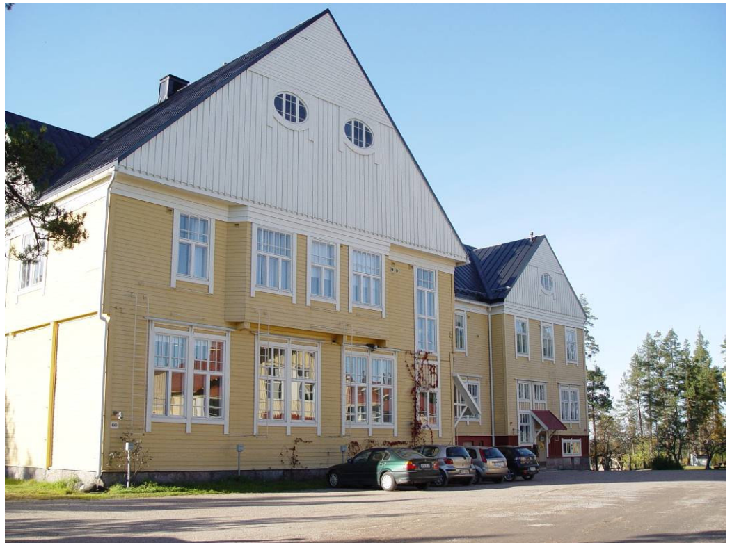
Kuva: Kansanopisto on yksi Tuusulan arvokkaimmista rakennushistoriallisista kohteista.
