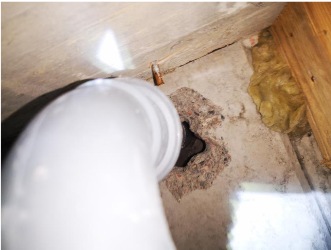
Kuva 4. Luokkahuonesiiven alapohjan läpivienti.
