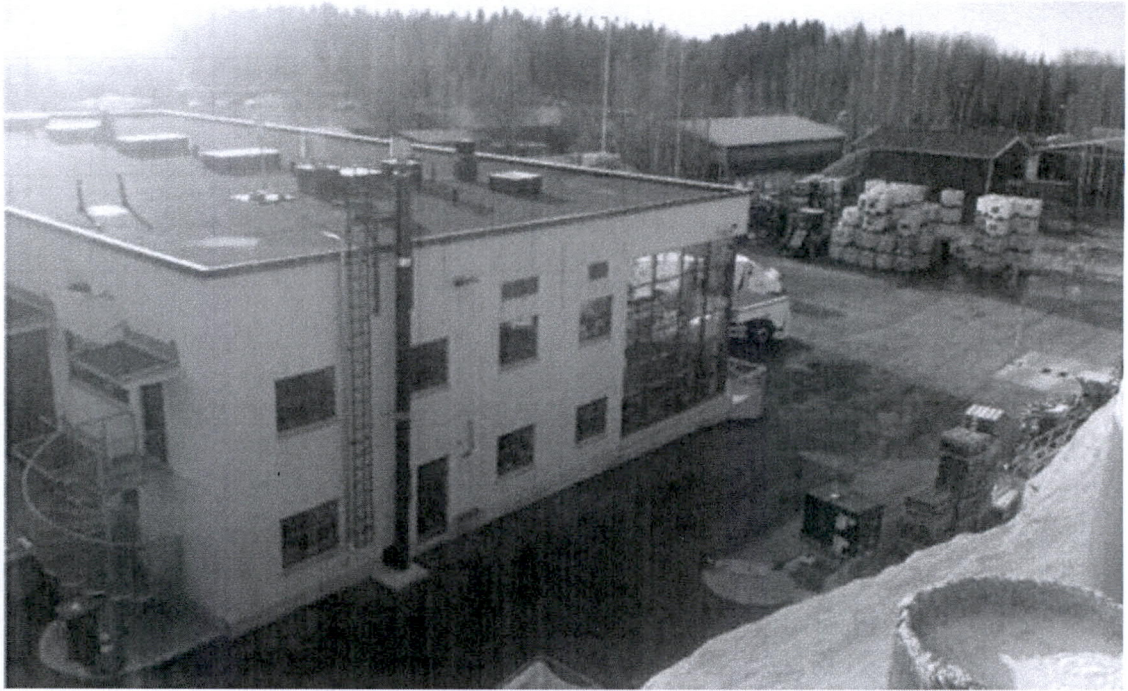
Kuva 1.2. Jätteiden käsittelyhalli on valmistunut vuonna 2015.
