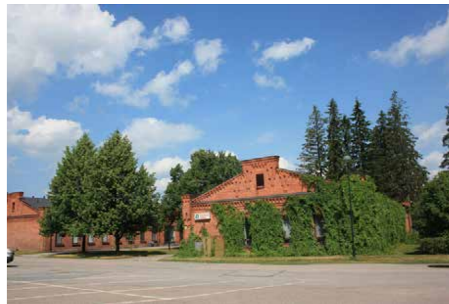
36I Kasarmirakennus vuosien 1914-15 rakennusvaiheesta. 36_I_kasarmi_IMG_0588.jpg
