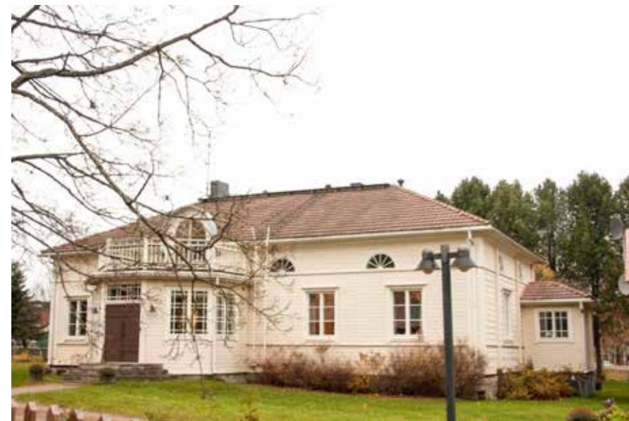
Pääjulkisivun rikkonainen sommittelu ei ole tyypillistä empire-rakennuksille. 38 Klaavon päärakennus. 38_klaavo_IMG_8080.jpg
