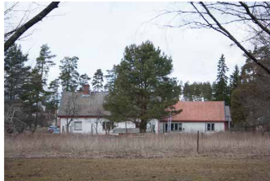
Korkin päärakennus. 30_korkki_IMG_6923.jpg
