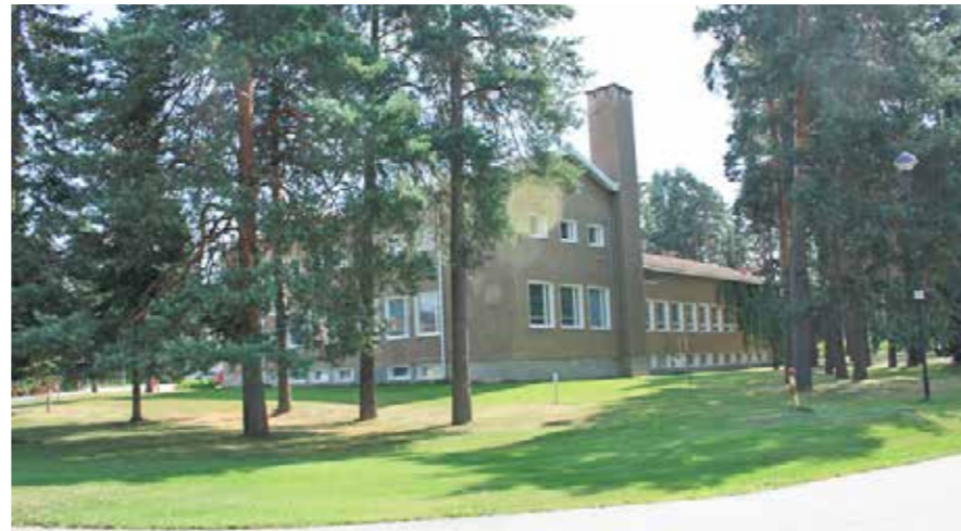
36M Rapattu tiilirakenteinen ruokalarakennus vuodelta 1952. 36_M_ruokala_IMG_0582.jpg
