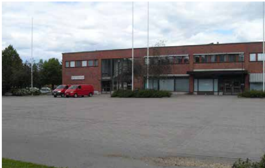
34B Ostoskeskuksesta on tullut virastotilaa ja tori on autioitunut. 34_B_ostoskeskus_SDC11487.jpg
