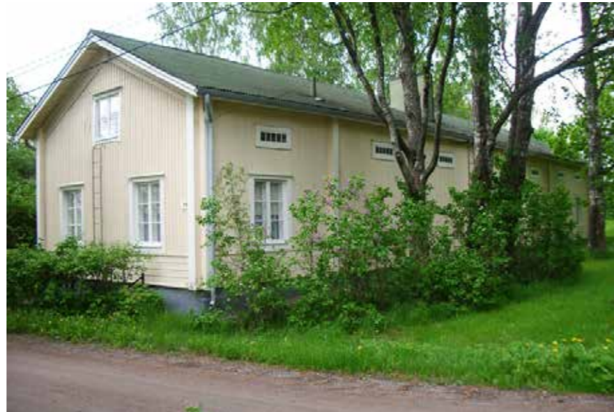
27. Viksbergin eteläpäätty. PS. Kuva Panu Savolainen. 27_viksberg_savolainen_IMG0383.jpg
