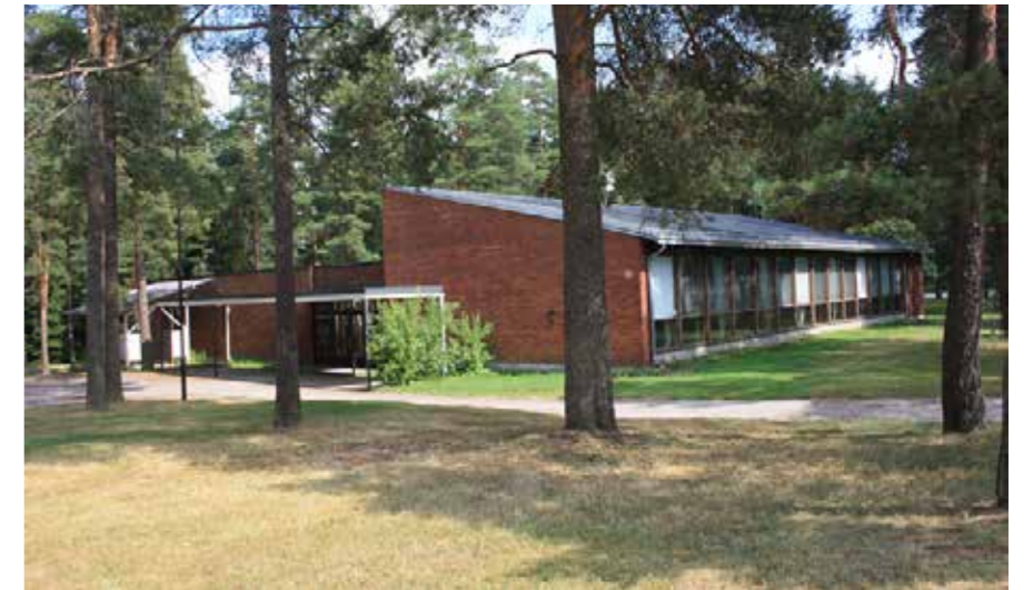
36S Sotilaskodin arkkitehtuurissa on paljon yhtymäkohtien Heikki ja Kaija Sirénien Otaniemen teekkarikylään suunnittelemaan Servin mökki -ravintolaan. 36_S_sotilaskoti_IMG_0627.jpg
