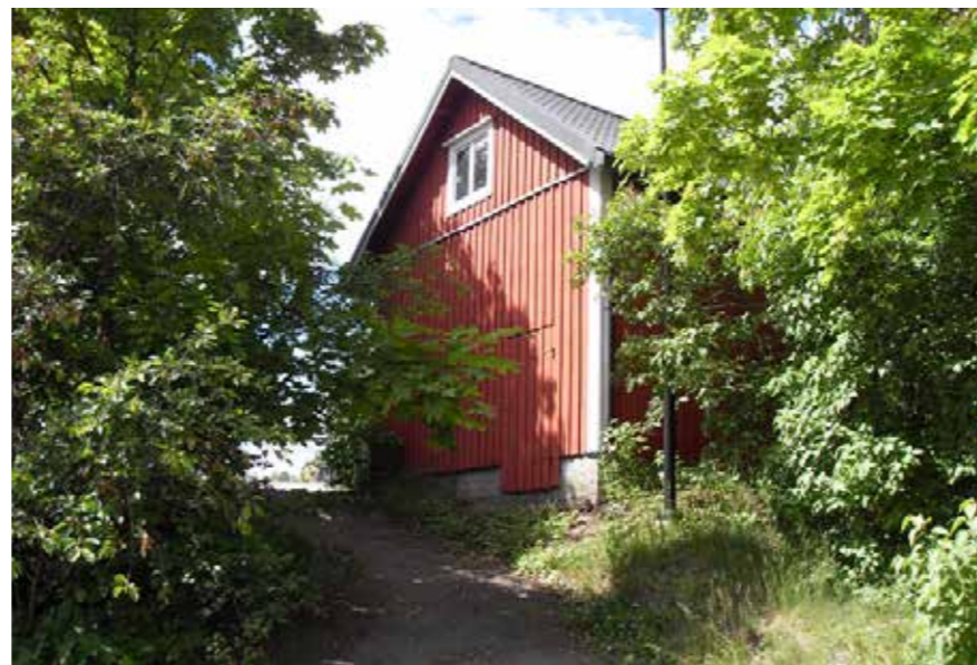
32A Rapsikanmäen ulkorakennus (kuvassa on vanha tunnus). 32 Rapsikanmäen ulkorakennus. 32_B_ulkorakennus_SDC11417.jpg
