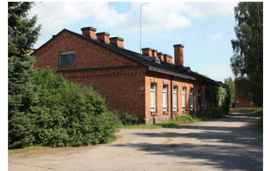
36C Leipomorakennus valmistui vuonna 1914. 36_C_leipomo_IMG_0646.jpg
