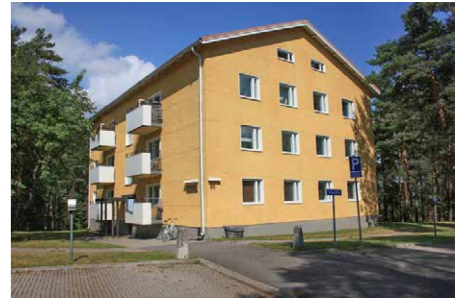
Keltaiset, rapatut henkilökunnan asuntotornit on suunnitellut Heidi Vähäkallio-Hirvelä. Kuvassa 36 O, Juhaniksi nimetty torni. 36_O_juhani_IMG_0659.jpg
