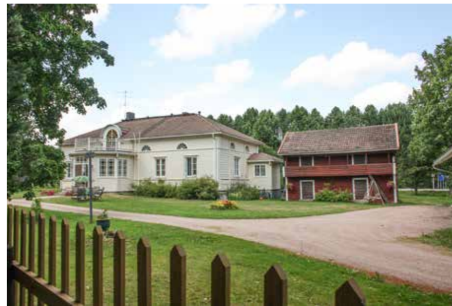
38 Klaavon päärakennus ja 38A Klaavon pariluhti. 38_klaavo_pihapiiri_IMG_0687.jpg
