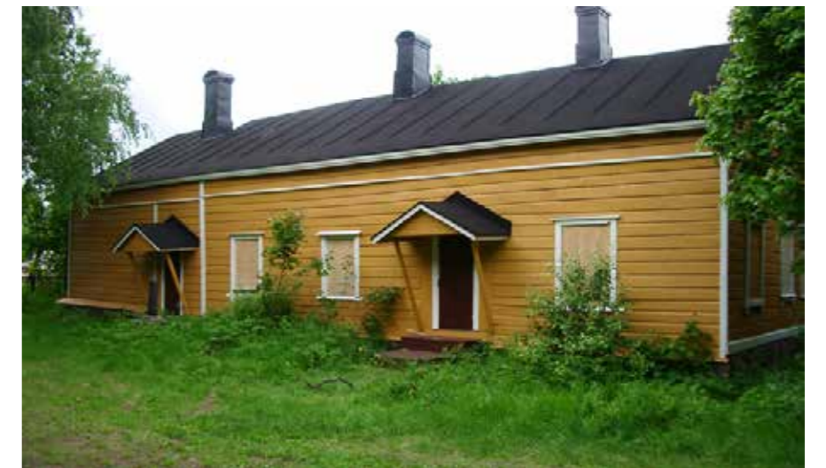
28. Prijuutin sisääkäynnit. Vasemmanpuoleisessa sisäänkäynnissä ei ole ollut alkuaan katosta ja oikeanpuoleinen on ollut suurehko umpikuisti. Kuva Panu Savolainen. 28_prijuutti_savolainen_IMG0379.jpg
