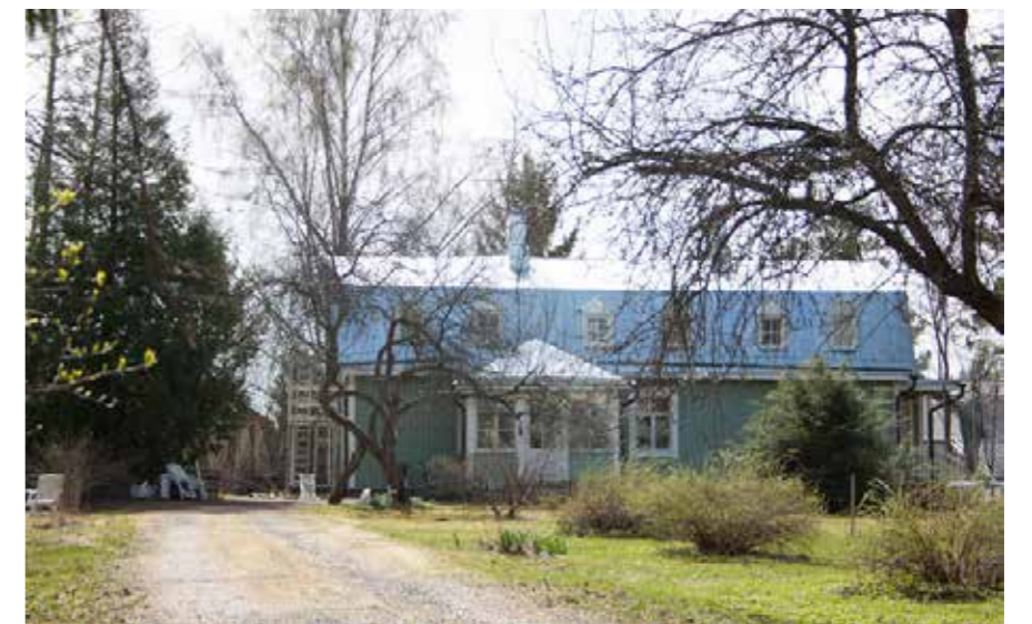
227B Mikkolan pihamaata on siivottu ja avattu; vanhat omenapuut ja marjapensaat on saaneet lisää valoa. 227_B_mikkola_IMG_7051.jpg
