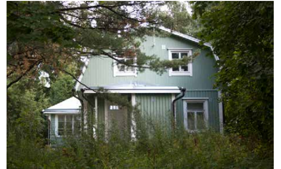
227B Mikkolan taitekatteisen talon uusi umpinainen päätykuisti. 227_B_mikkola_IMG_4561.jpg
