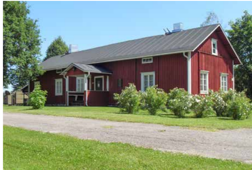
40 Hyökkälän Saksa eli Puustelli sisäänkäynnin puolelta. 40_puustelli_saksa_SDC11701.jpg
