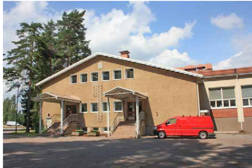
36M Ruokalarakennuksen sisäänkäynnit ja laajennusosa. 36_M_ruokala_IMG_0640.jpg
