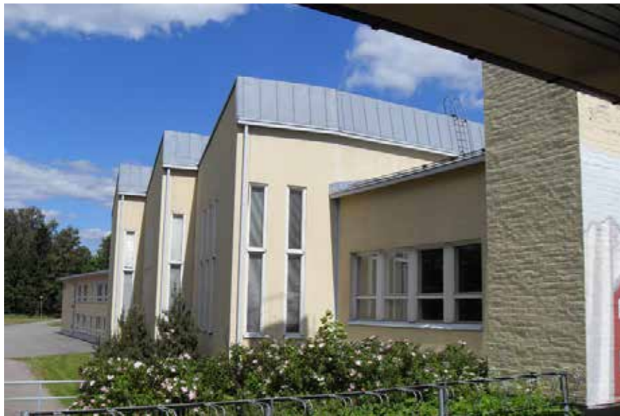
35 Hyrylän koulukeskus lukiosiiven 1950-luvun henkinen porrastava massoittelu keventää massiivista laajennusta. 35_hyrylan_koulukeskus_SDC11643.jpg
