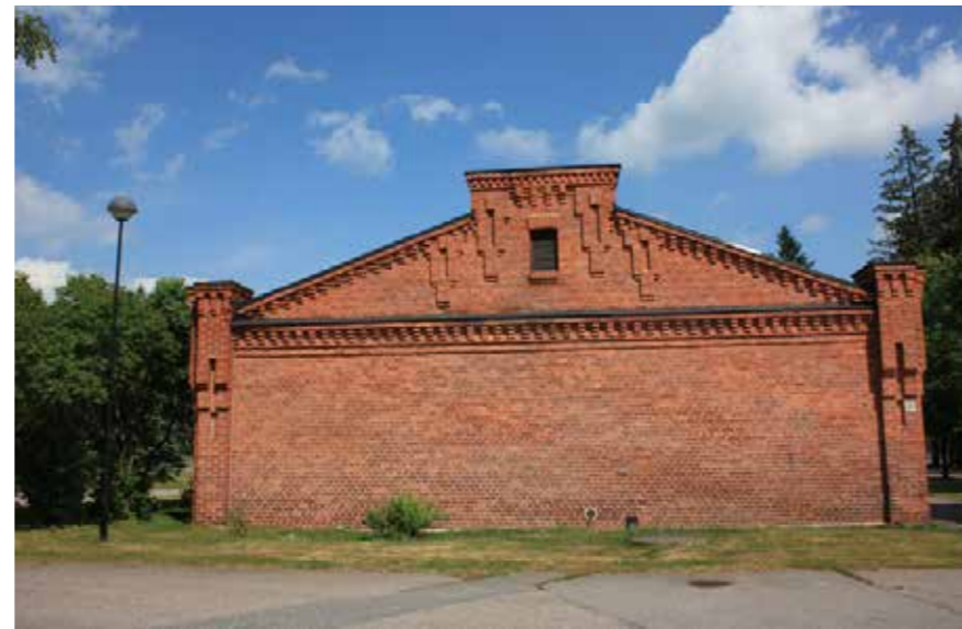
36H Kasarmirakennus vuosien 1914-15 rakennusvaiheesta. 36_H_kasarmi_IMG_0591.jpg
