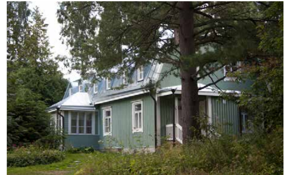
227B Mikkolan vanha päärakennus on kunnostettu ja saanut täysin uuden peltikatteen sekä uuden päätykuistin. 227_B_mikkola_IMG_4560.jpg
