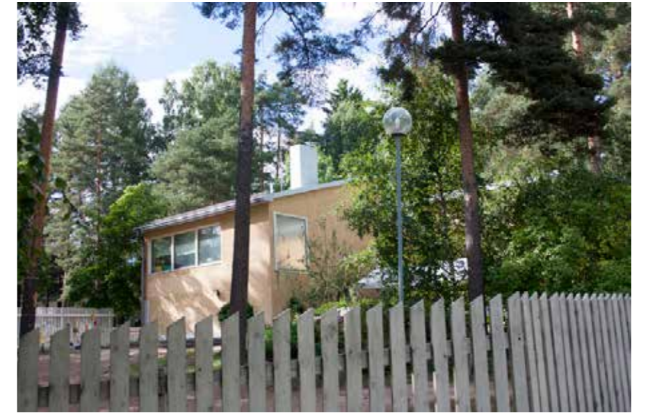
29D Amerin tehtaanjohtajan huvila pihan puolelta; piha on kalustettu päiväkotia varten. 29_D_amerin_tehtaanjohtajan_huvila_IMG_4539_1.jpg
