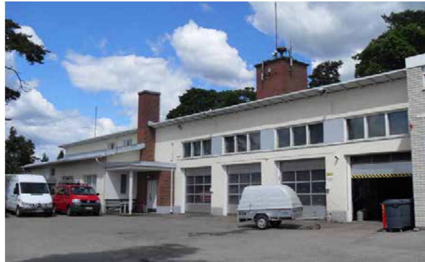
32B Hyrylän vanha paloasema, vasemmalla miehistöosa, etualalla autohallit. 32_C_paloasema_SDC11425.jpg
