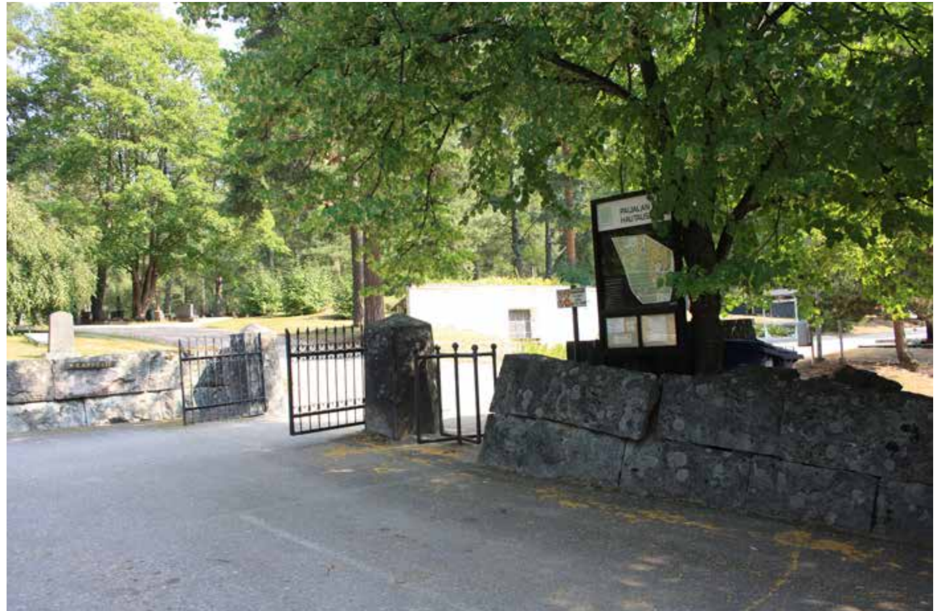
Vanhan osan kiviäitä hevoskytkyineen (kiviin kiilatut renkaat) on tärkeä osa hautausmaan rakennettua historiaa siinä missä hautamuistomerkit hautaja reunakivineen sekä rautaristeineen ja rauta-aitoineen. 45_portti_IMG_0400.jpg
