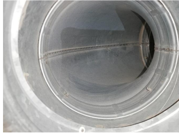
Kuva 34: Poistoilmakanava on likainen.
