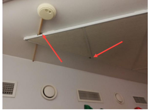
Kuva 7: Kissa-eskareiden tilassa akustiikkalevyn mineraalivillaeristettä näkyvillä.
