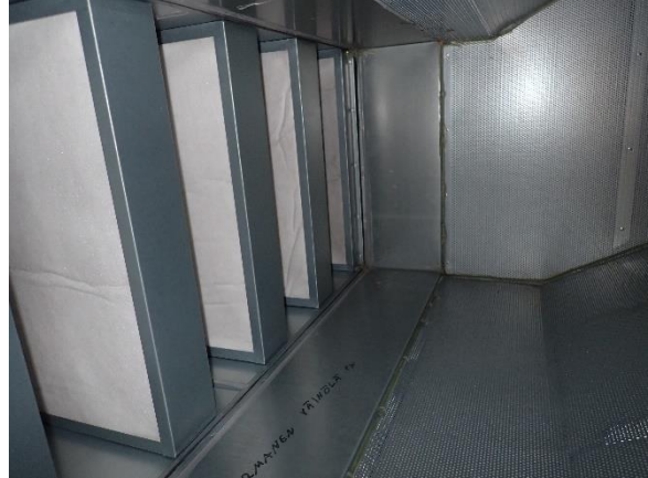
Kuva 20: Äänenvaimentimet on uusittu.
