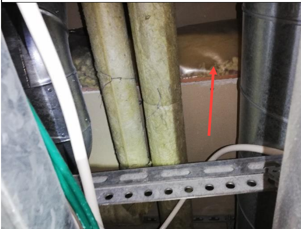
Kuva 4: Alaslasketun kattotilan kautta näkyy yläpohjan höyrynsulkumuovi ja puhallusvillat.
