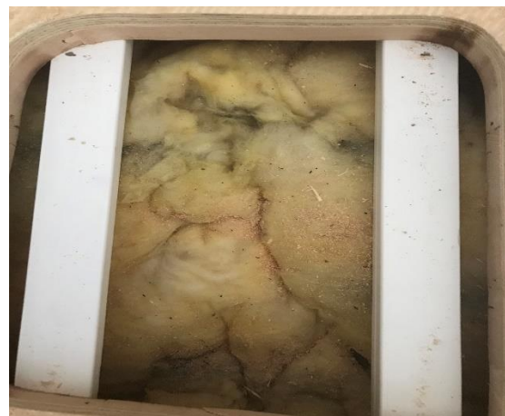
Kuva 4 Villat ovat tummuneet ja haisivat hometalle
