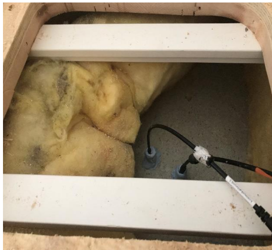
Kuva 1 Rakennusavaus 1 liikuntasalin lattiarakenteeseen pukuhuoneen vieressä
