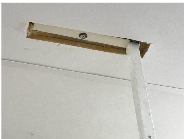
Kuva 3 Alakatossa on suojaamaton mineraalivilla.
