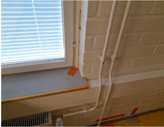
Kuva 24. Alipaineistettuna ikkunalaudalla piste- mäistä ilmavuotoa.
