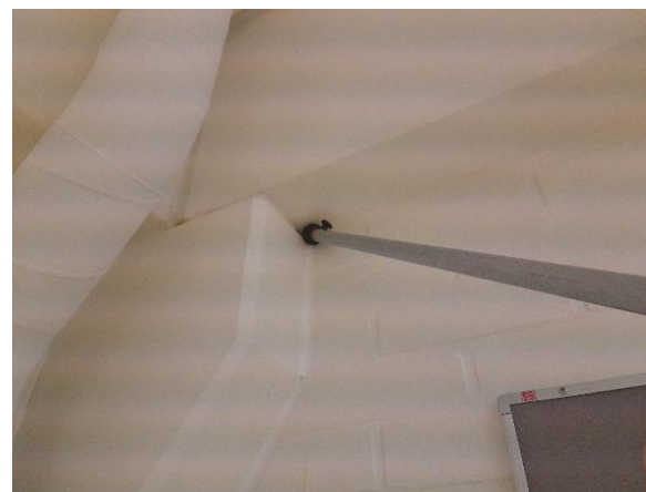
Kuva 16. Pistemäinen ilmavuoto pilarin yläosasta.
