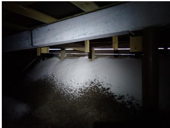
Kuva 3. Harvalaudoitusten välistä pääsee satamaan lunta ryömintätilaan.
