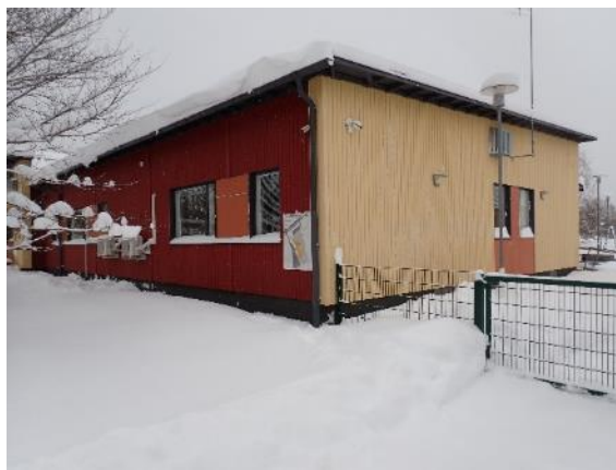
Kuva 18. Ulkoseinärakenteen ulkopinnassa julkisivulaudoitusta ja paikoittain julkisivuvaneria.
