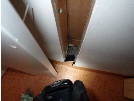
Kuva 11. Väliseinäelementti avattu tilan 117 lepo- huoneen ja 118 ryhmähuoneen väliltä.
