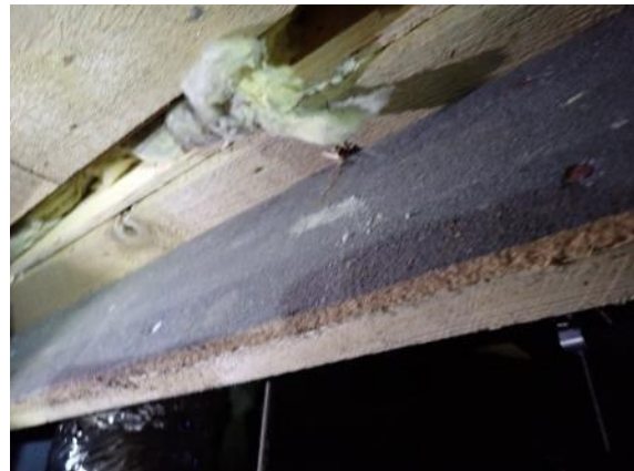
Kuva 14. Elementtien liitoskohtia avattiin myös ryömintätilasta 3 kpl. Kohdissa ei havaittu höyryn- / il- mansulkua.
