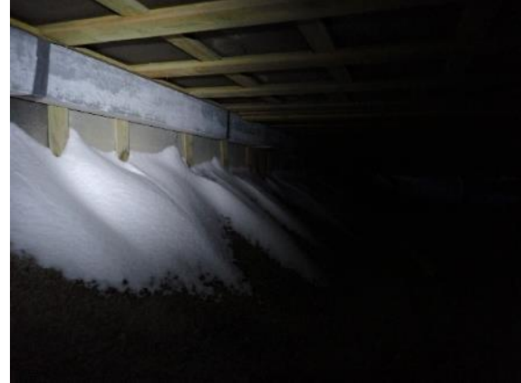
Kuva 2. Sokkelilevytyksen ja ulkoseinärakenteen välissä on rako, josta tuiskuava lumi pääsee kulkeutumaan ryömintätilaan
