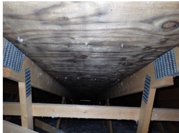
Kuva 28. Kattolevyissä mikrobikasvustoa.
