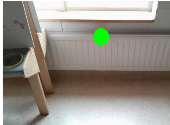
Kuva 13. Patterikannakkeissa pistemäistä ilmavuotoa normaalissa ja alipaineistetussa tilassa.
