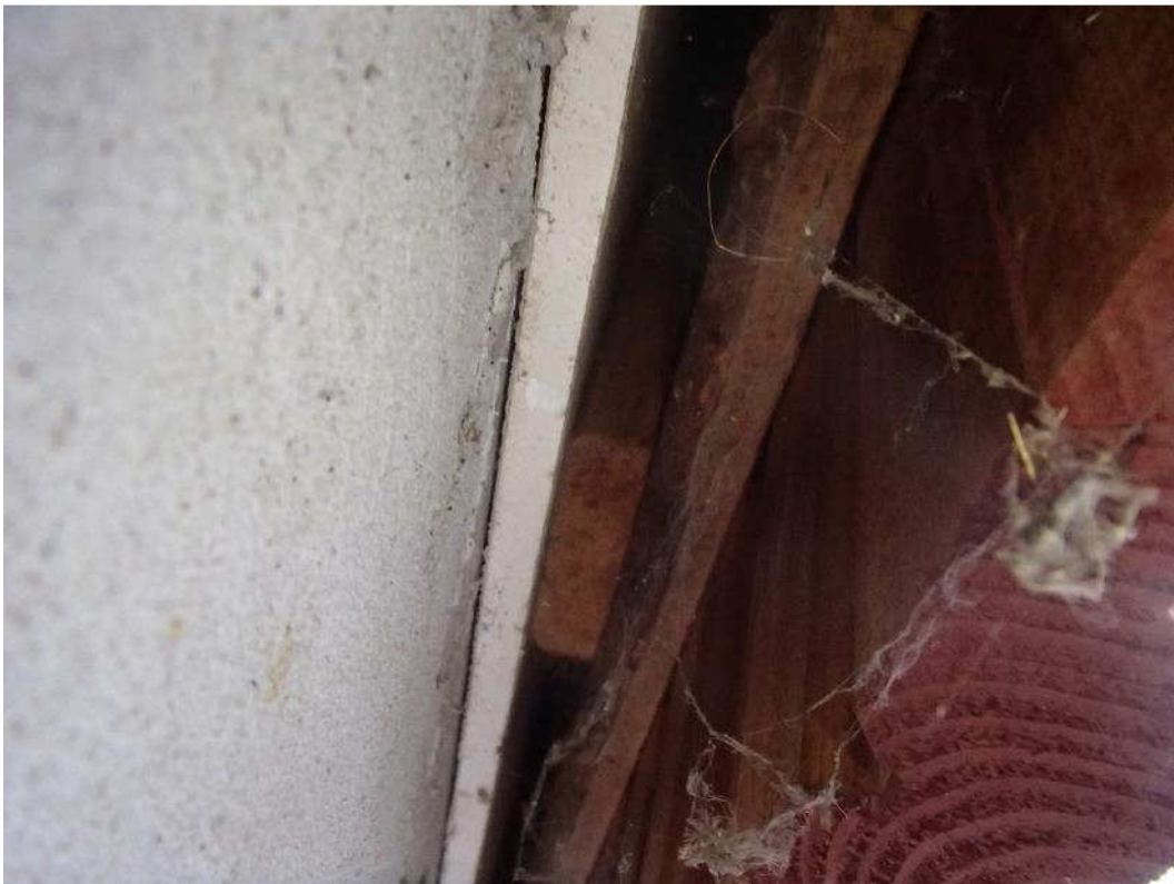
Kuva 6. Kuvassa julkisivupaneloinnin taustan ristiinkoolaus ja tuulensuojalevy.
