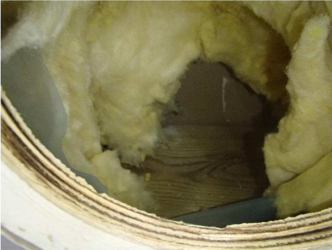
Kuva 3. Rakenneavaus RAK2 luokkahuoneen 62 ulkoseinärakenteeseen.
