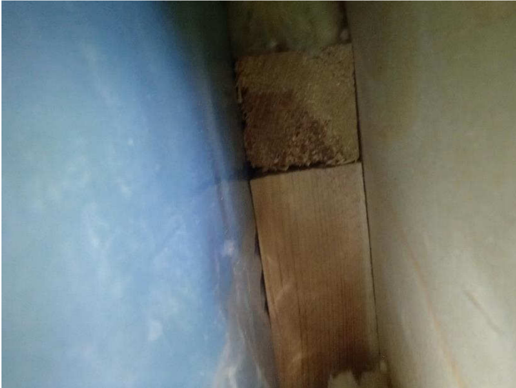
Kuva 5. Rakenneavaus RAK3 luokkahuoneen 62 ulkoseinärakenteeseen. Kuvassa ikkunoiden ympärillä olevat 50 x 50 puumateriaalit höyrynsulkumuovin sisäpuolella.
