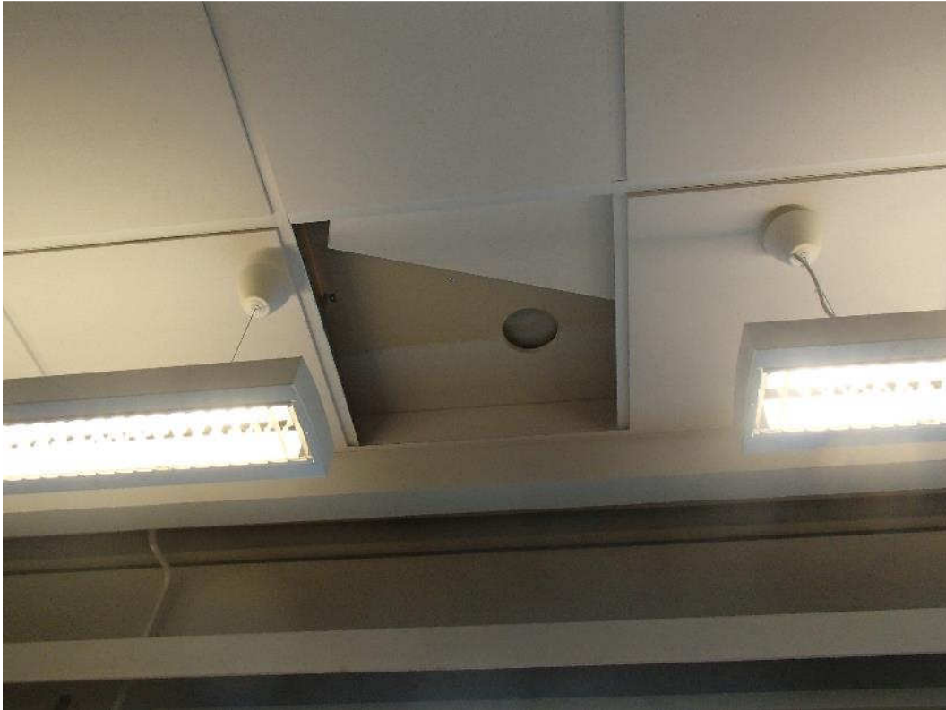
Kuva 8. Rakenneavaus RAK4 luokkahuoneen 62 yläpohjarakenteeseen.
