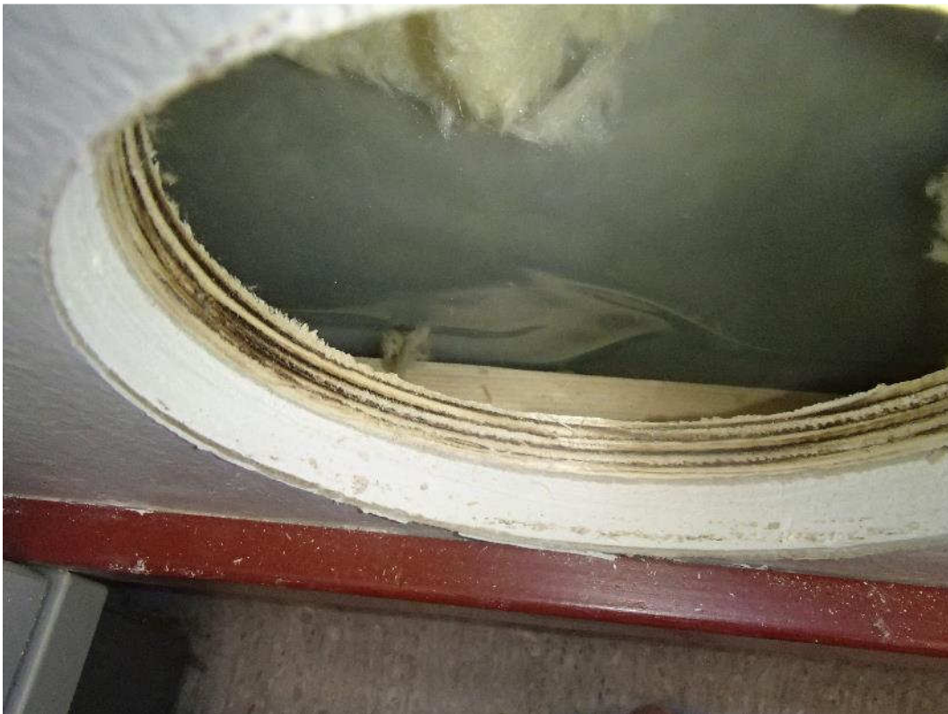
Kuva 2. Rakenneavaus RAK2 luokkahuoneen 62 ulkoseinärakenteeseen.
