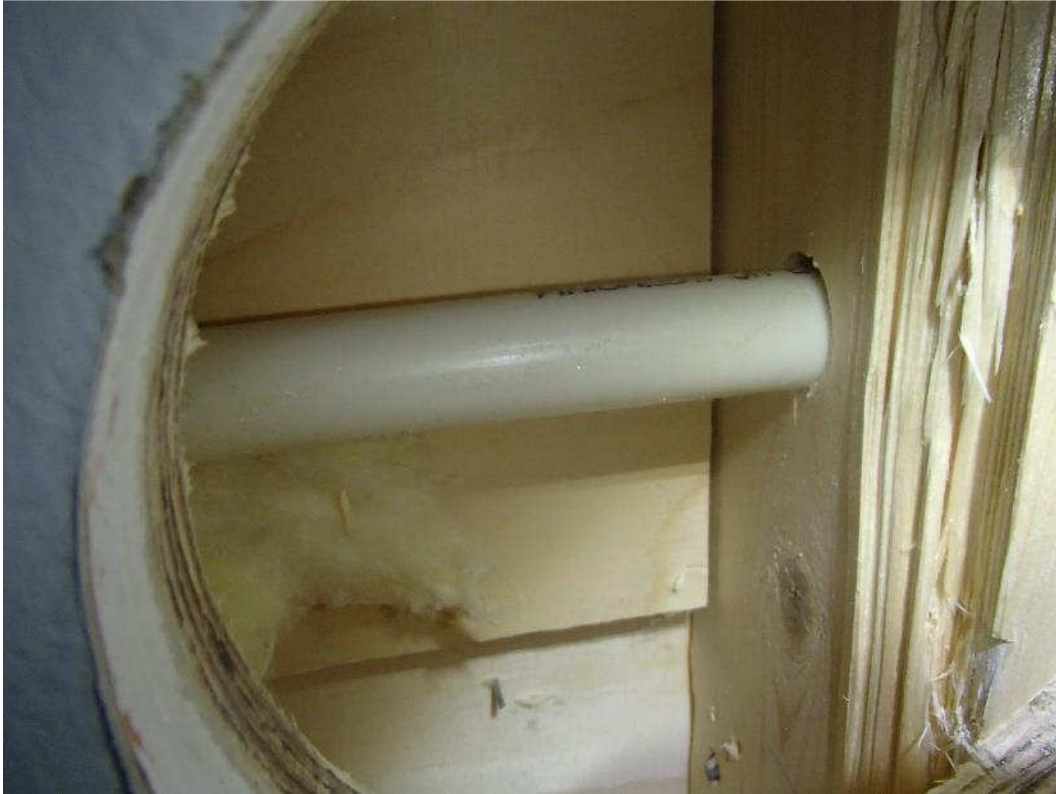
Kuva 7. Rakenneavaus RAK4 luokkahuoneen 62 väliseinärakenteeseen.
