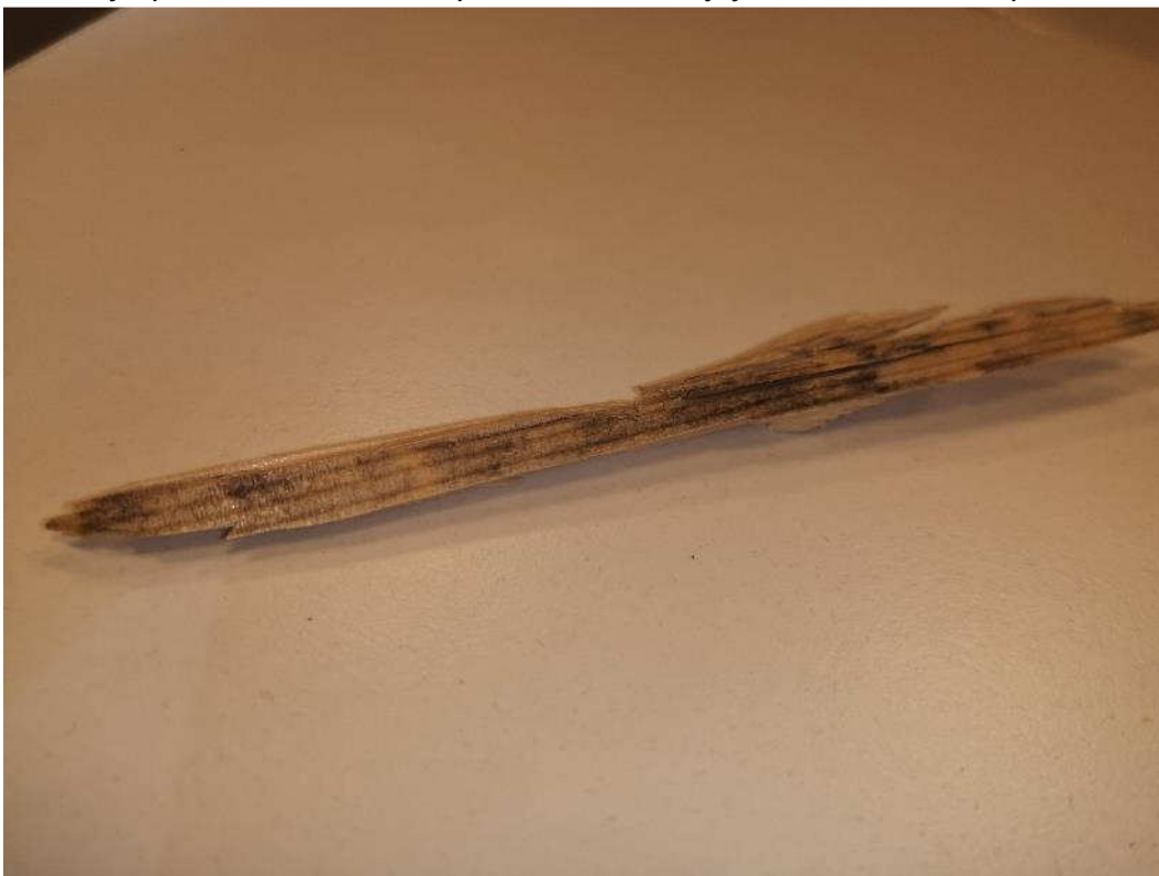
Kuva 15. Näytepala rakenneavaus RAK11 luokkahuoneen 38 ulkoseinärakenteesta. Kuvassa on näytepala ikkunan alapuoleisesta 50 x 50 puumateriaalista höyrynsulkumuovinin sisäpuolelta.
