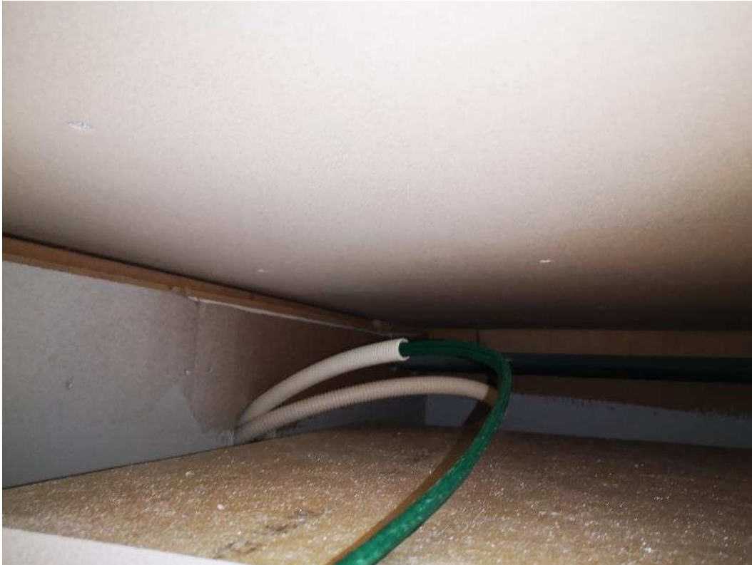
Kuva 17. Rakenneavaus RAK10 luokkahuoneen 68 yläpohjarakenteeseen.
