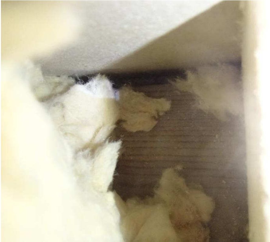
Kuva 10. Rakenneavaus RAK6 vanhan ja uuden puolen väliseinään.
