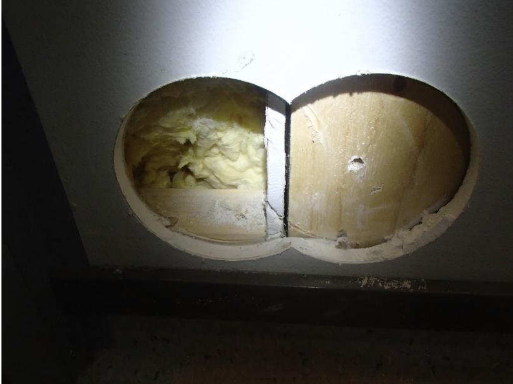
Kuva 9. Rakenneavaus RAK6 vanhan ja uuden puolen väliseinään.
