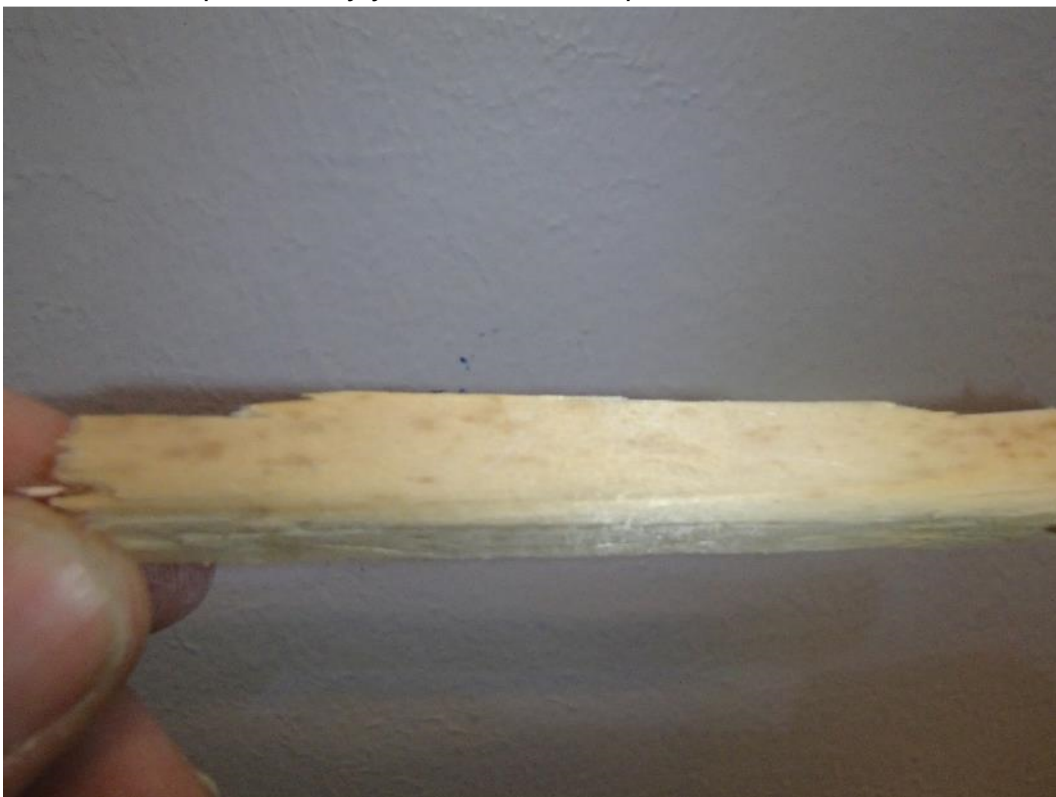
Kuva 13. Näytepala rakenneavaus RAK8 luokkahuoneen 68 ulkoseinärakenteesta. Kuvassa on näytepala ikkunan alapuoleisesta 50 x 50 puumateriaalista.
