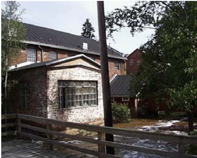
Teollisuusrakennuksia kosken partaalla
