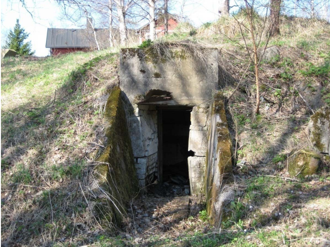
126353:7. Ruukkialueella sijaitseva varastorakenne. E-W. Kuva Katja Vuoristo.
