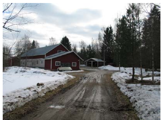
Stenbackan tilakeskuksen rakennuksia
