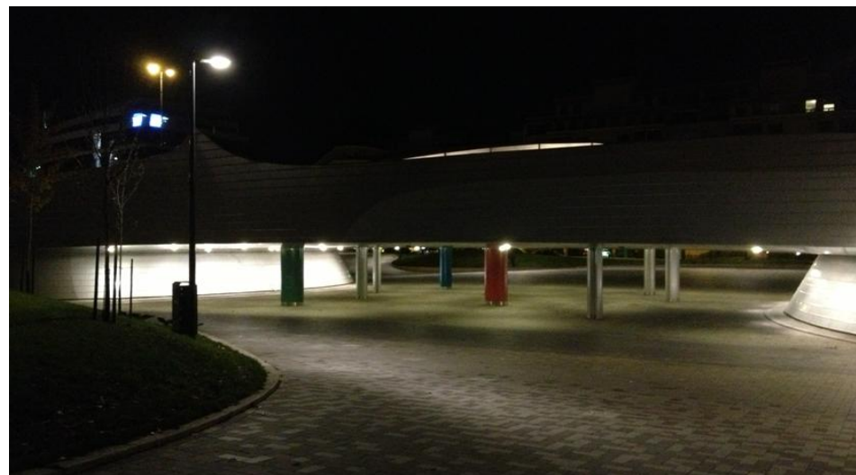
Kuva 27. Helsingin Ruoholahteen johtava alikulkutunneli on leveä ja hyvin valaistu. Tunnelissa on käytetty myös kaarevia muotoja sekä iloisia värejä, jolloin sillan alittaminen ei tunnu pelottavalta edes öiseen aikaan
