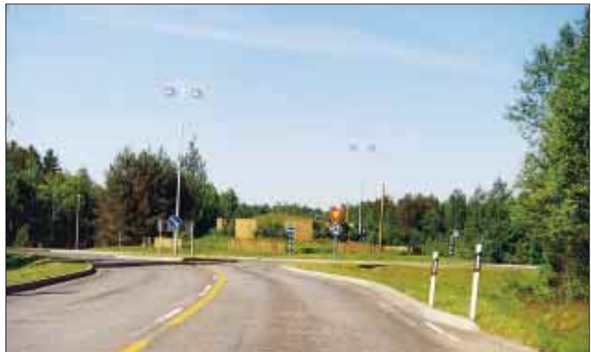
Liikenneympyrän keskiosan korotus tulee tehdä siten, että liittymän havaittavuus on hyvä (Pietarsaari).
