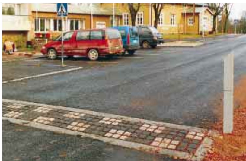
Lapinjärventien korotus Lapinjärven kunnanviraston kohdalla.
