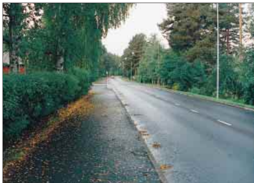
Kevytiliikenteen väylän rakentaminen lisäsi ajonopeuksia Rantasalmen taajamien sisääntulojaksoilla, vaikka nopeusrajoitus säilyi ennallaan.
