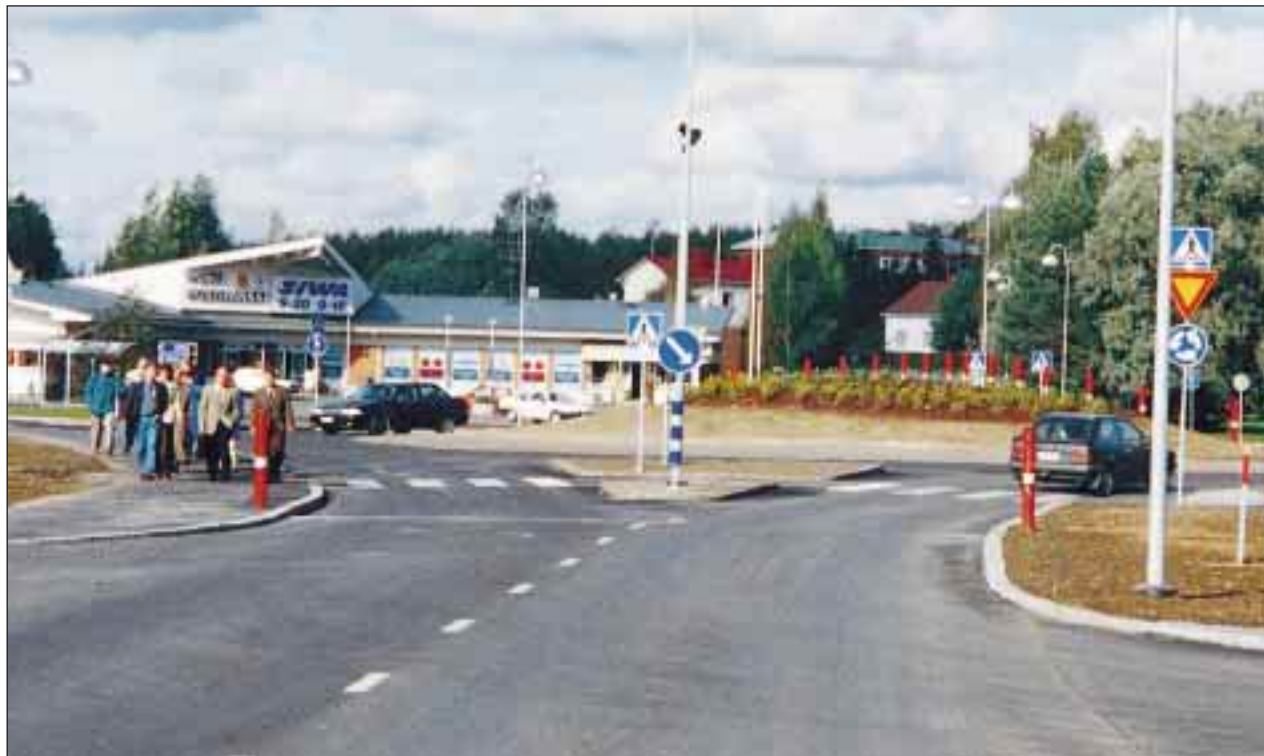
littalan keskustan keskeinen liittymä rakennettiin liikenneympyräksi kesällä 1998.
