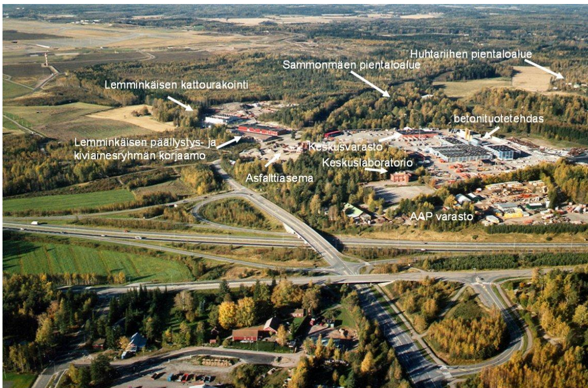
Kuva 1. Näkymä länteen Focus-suunnittelualueelle. Kulomäentie alittaa Vanhan Tuusulantien ja ylittää Tuusulanväylän. Kehä IV:sta Focus-alueella on suunniteltu Kulomäentien jatkeeksi.
