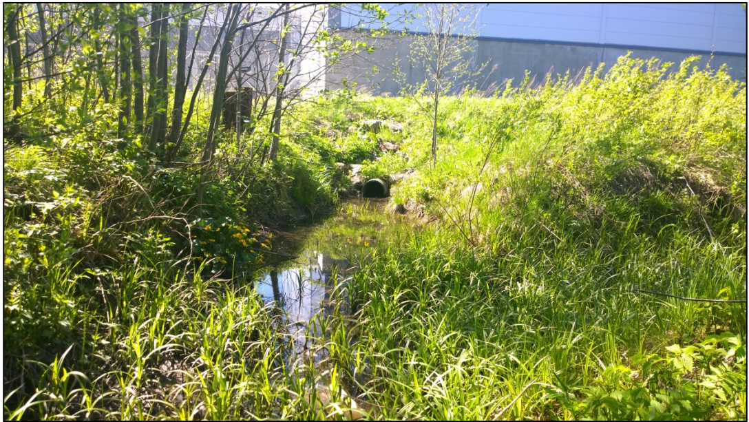
Kuva 7 Kohdan C hulevesiputken pää.
