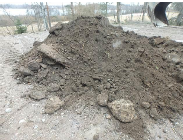
Valokuva 5. Koekuopan VAH6 maa-aineksia. Maassa yksittäisiä paloja jätejakeita, kuten puuta, muovia, betonia ja asfalttia.
