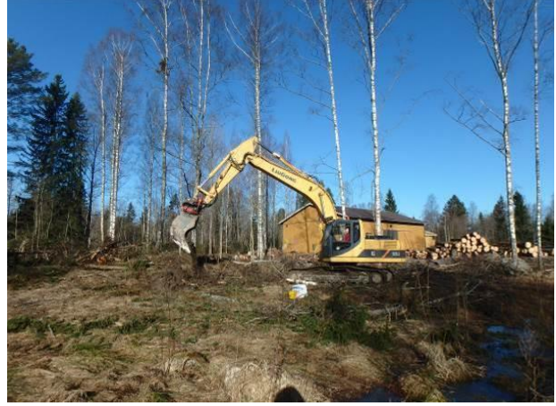
Valokuva 2. Yleiskuva kohteesta valokuvattuna pohjoiseen. Kaivinkone tutkimuspisteet VAH3 kohdalla.
