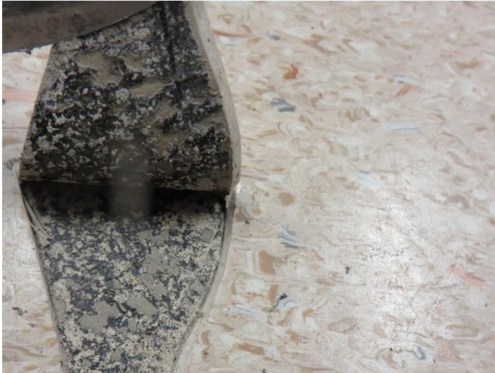
Kuva 3. Maton alla liima oli murenevaa ja haisi pistävälle luokassa 54.
