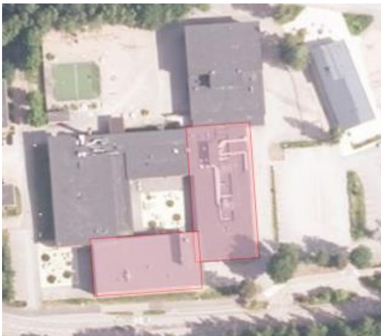
Kuva 1. Tutkimukset on tehty punaisella korostetuissa koulun osissa.
