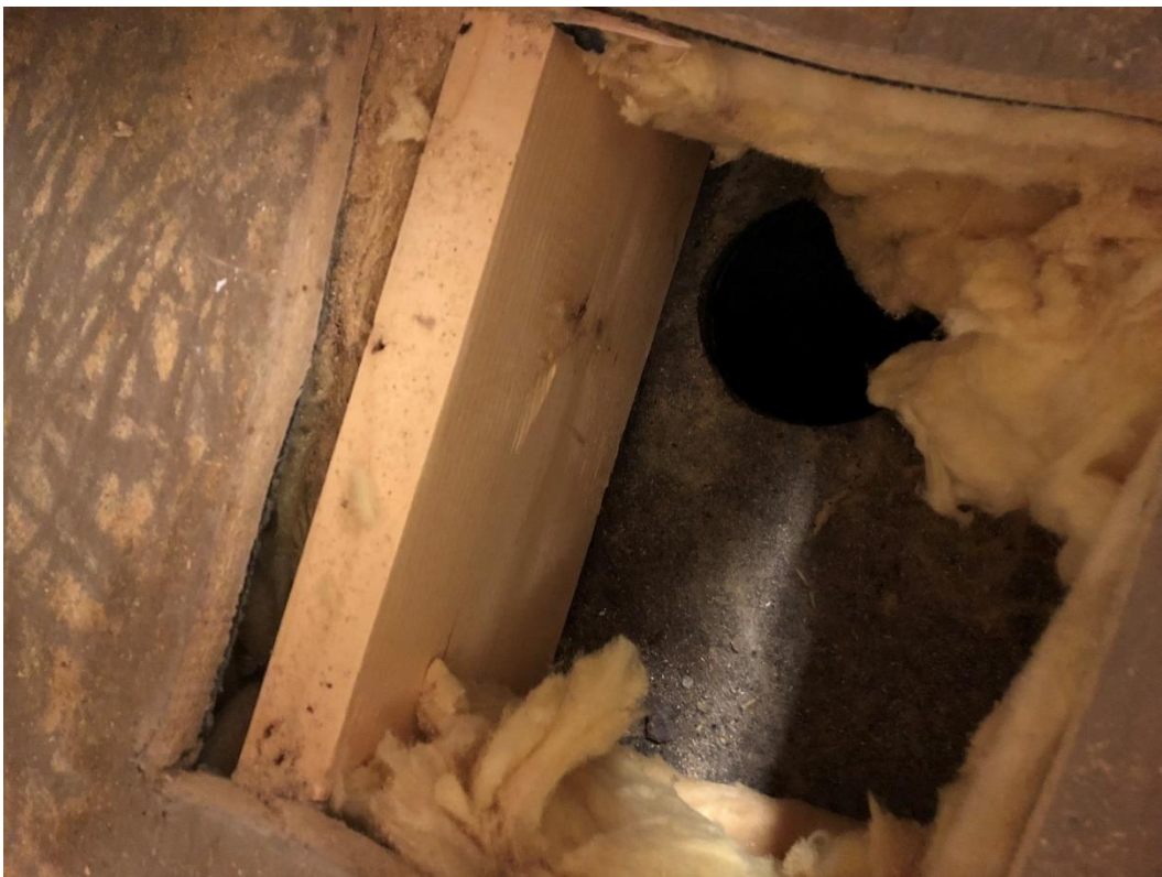
Kuva 14. Kantavien vasojen välit on täytetty eristevillalla. Vasojen puu oli kuiva ja kosteuden vaikutusta ei havaittu avauskohdassa.
