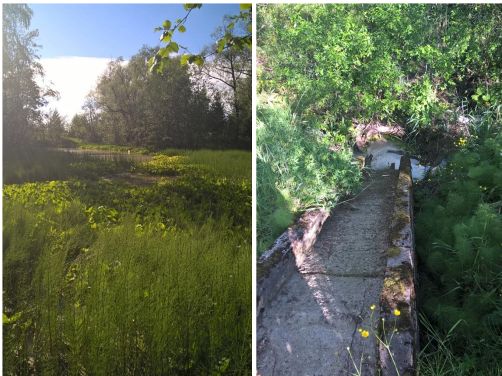
Kuva 6.7. a) Purotien pohjoispuolinen lampi, b) lammen pato, jonka alta vesi virtaa purkuojaa Jusliininojan ylämpään lampeen.
