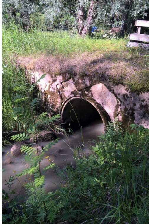
Kuva 6.6. Uoman betonipato, jossa on rumpu.
