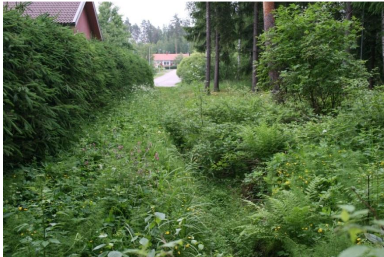
Kuva 4.7. Uoma purkaa vedet takojankaaren hulevesiverkostoon syvän ja leveän uomaosuuden jälkeen (kuvattu lännestä Takojankaarelle päin).
