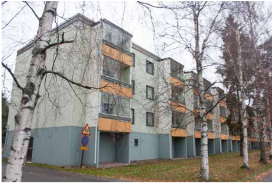
211A Mahlamäen lamellitalon avoparvekkeita on lasitettu.
