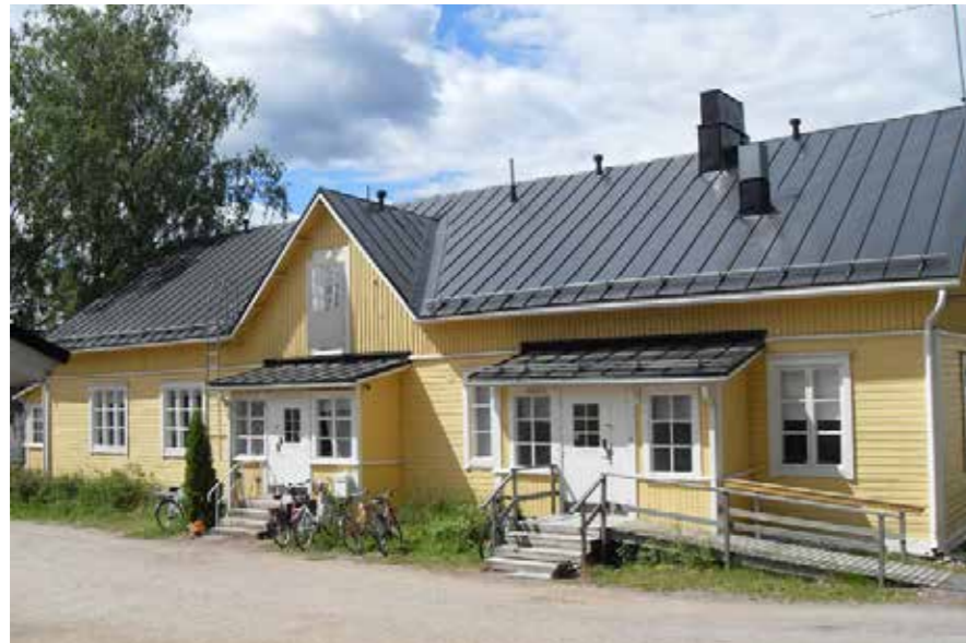
31 Maamiesseurantalo takapihan puolelta.
