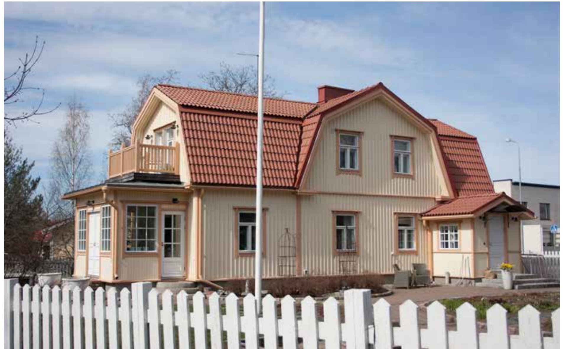
227A Villa Posti pihan puolelta; uusi umpikuisti parvekkeineen istuu saumattomasti vanhaan taloon. 227A Villa Posti.
