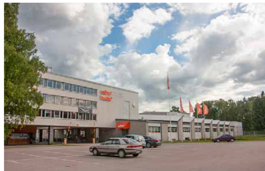
29A Tupakkatehtaan yksi tunnusomaisimpia piirteitä on ylävaloa aikanaan tuonut sahalaitakatto, joka pystylape on lasi, vino lape pellitetty.
