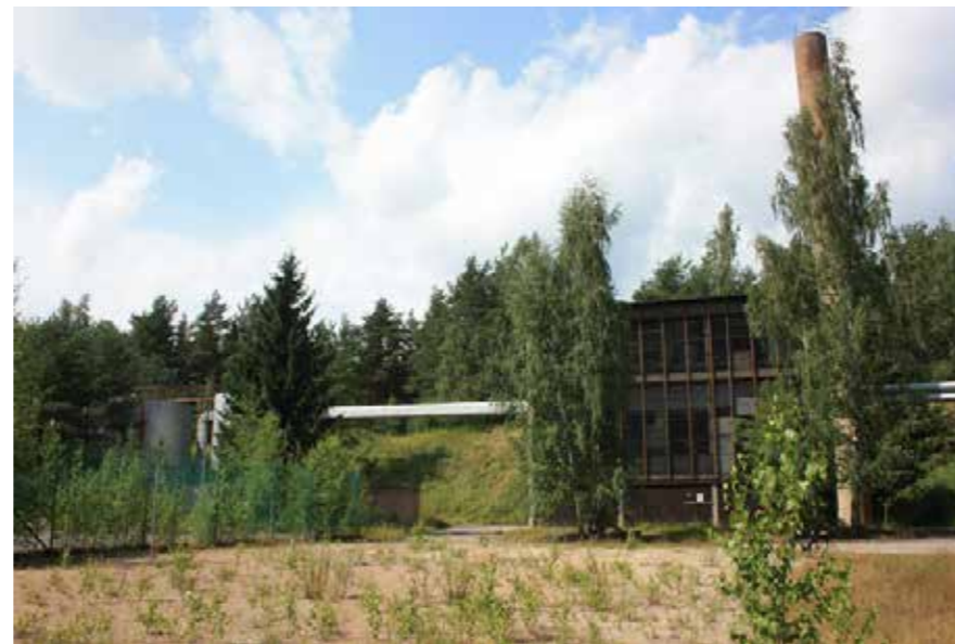
36V Lämpökeskus ja polttoainesäiliöt putkineen. Purettu 2017.
