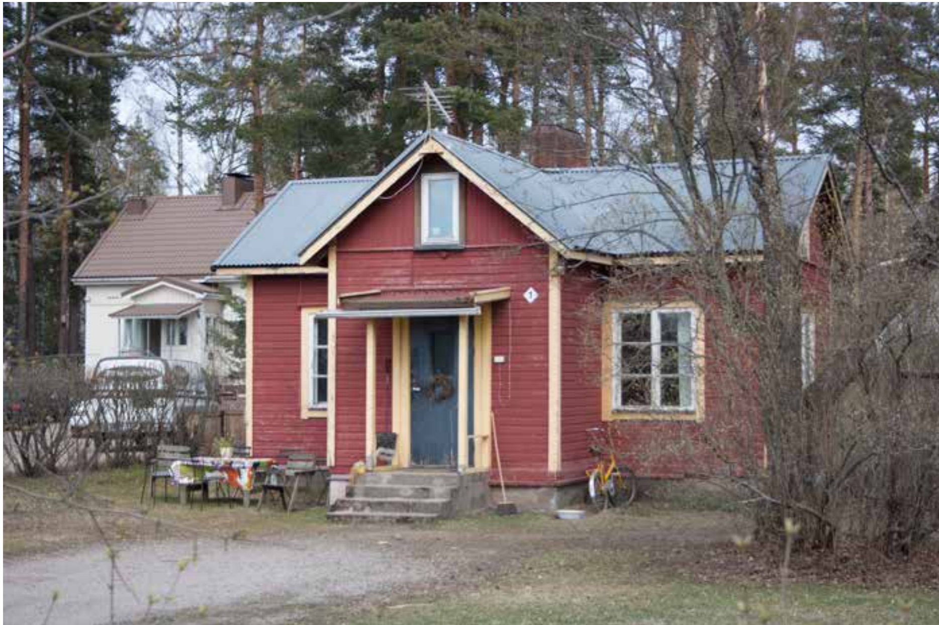
241A. Ajomiehentie 1 ja alkuperäiset kuusiruutuiset ikkunat.
