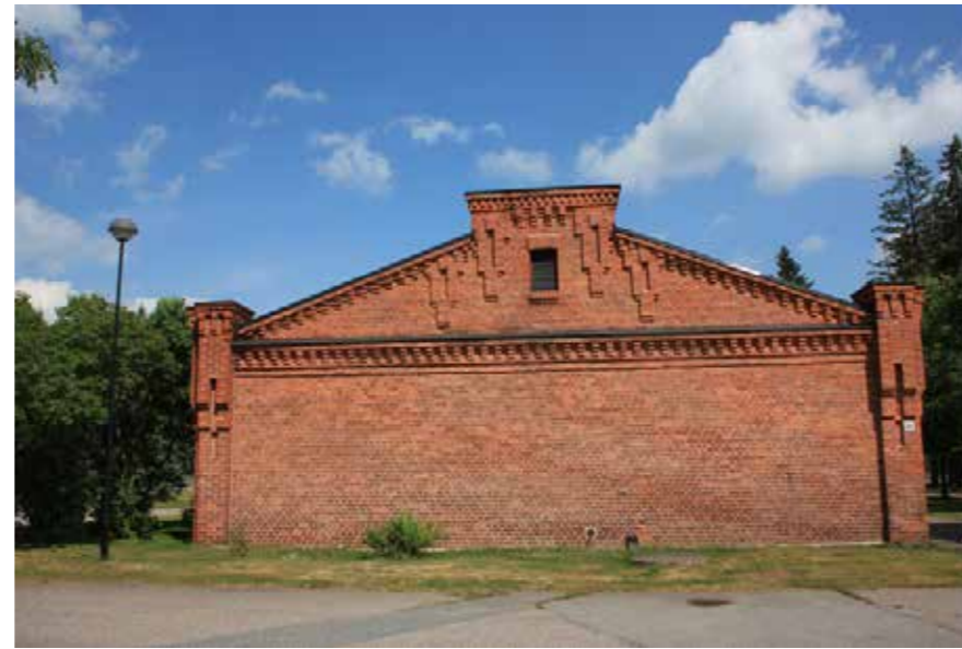
36H Kasarmirakennus vuosien 1914-15 rakennusvaiheesta.
