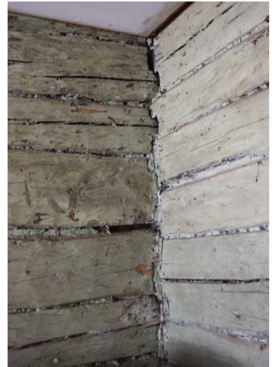
40 Puustellin esiinotettua savirappauspintaa.
