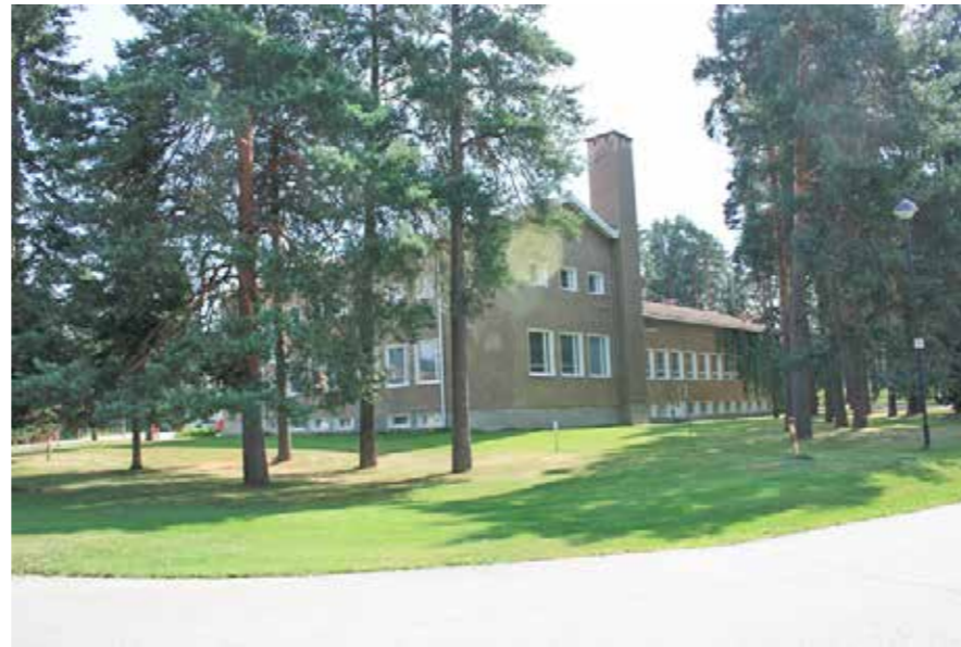
36M Rapattu tiilirakenteinen ruokalarakennus vuodelta 1952.
