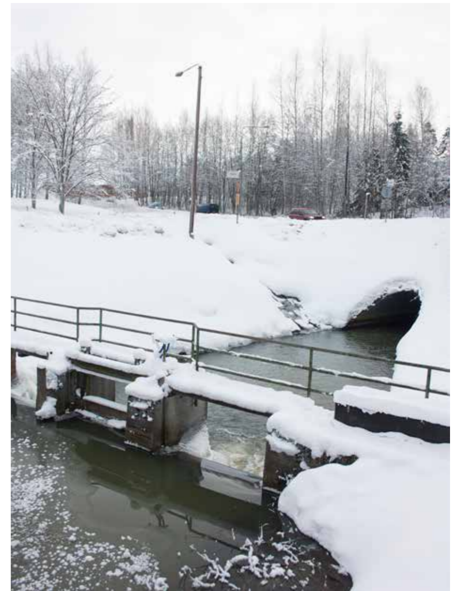
43 Tuusulanjoen pato kevyenliikenteen sillalta kohti Koskenmäensiltaa katsottuna.
