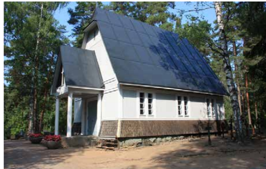
45A kappelin erityispiirre on jyrkkä katto ja helman suojaus paanuilla.
