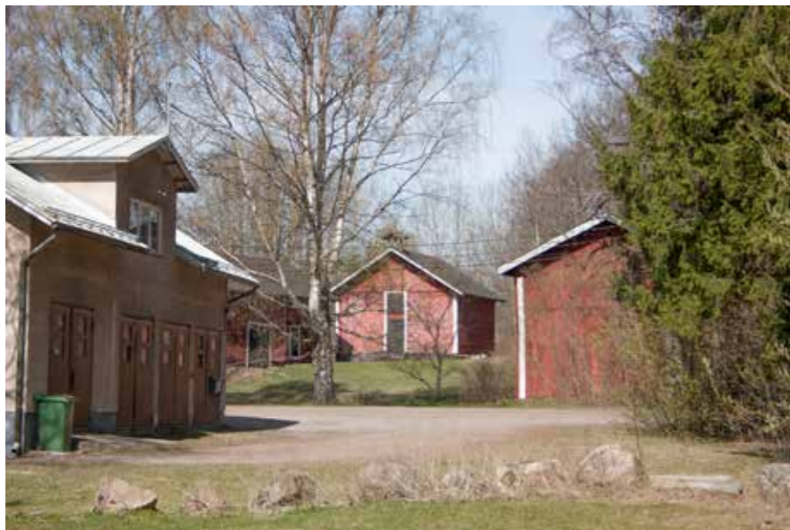
27 Viksbergin aittarakennukset ja rapattu autotallirakennus 1950-luvulta.
