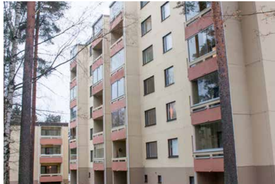
211A Elementtirakentamista puhtaimmillaan, eroavaisuudet toteutettu kerrostosten määrällä ja värityksellä. Parvekelasitus on 2000-luvun lisäys asumismukavuuteen.
