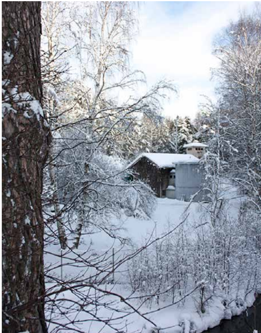
43 Tuusulanjoen varrella on vesilaitos ja yksi monista vanhoista Tuusulan sähkölaitoksen pagodi-kattoisista sähköjakotorneista.
