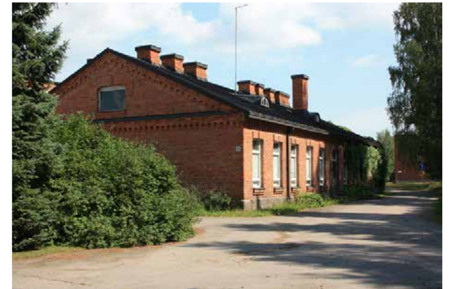
36C Leipomorakennus valmistui vuonna 1914.
