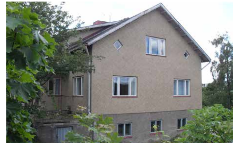
32C Hietalan asuinrakennus.
