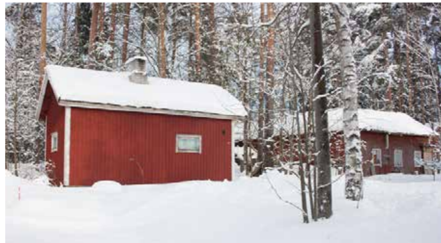
Koskenpellon tilasta Kielonkukka ja Sananjalka-tonteille jääneet talousrakennukset - taaempänä karjasuoja - 43 G , molemmat on purettu noin 2012-13.
