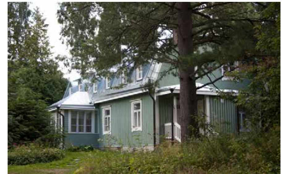
227B Lönnerbergin huvila on kunnostettu ja saanut täysin uuden peltikatteen sekä uuden päätykuistin.
