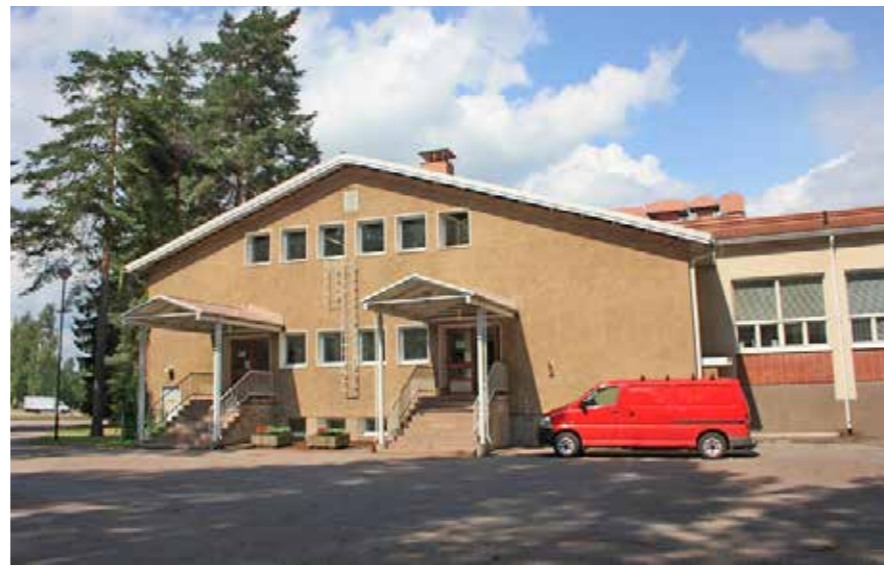
36M Ruokalarakennuksen sisäänkäynnit ja laajennusosa.
