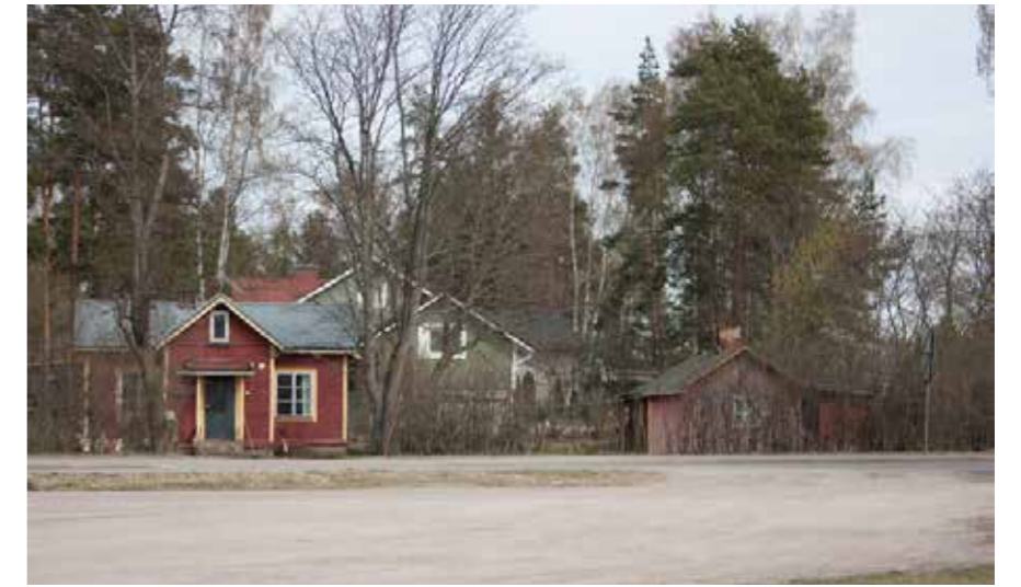
Fallbackantie241a eli Ajomiehentien tiivihkö ja usean aikakauden rakennuskantaa sisältävä omakotialue. Ajomiehentie 1 1920-luvun alusta on alueensa helmi.
