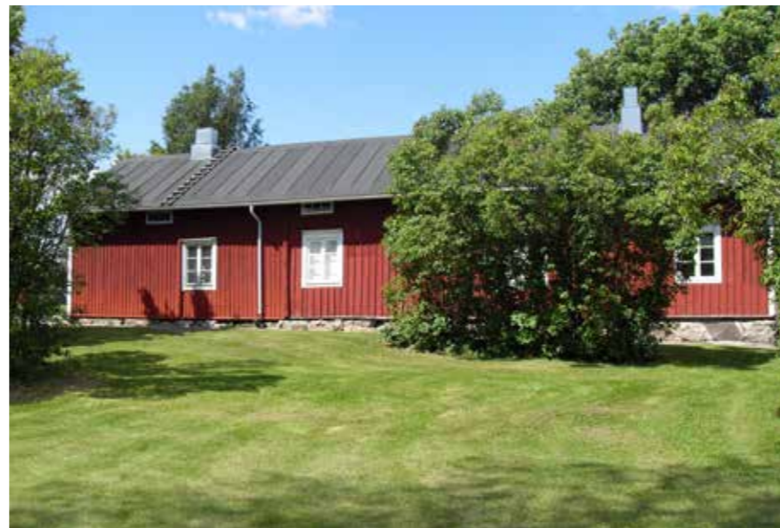
40. Puustelli takapuoleltaan paljastaa kivijalan erilaisten kokoamistapojen myötä kokonaisuuden rakentumisen eriaikaisista osista.
