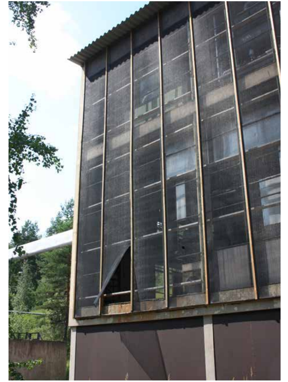
36V Lämpökeskus ja verkotetut julkisivut. Purettu 2017.
