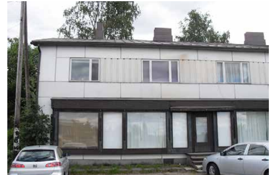
216B Haikosen kirjakauppa on muodistettu 1960-luvulla. Pohjalla on 1910-20-luvun tyyppillinen hirsirakenteinen kauppiastalo.
