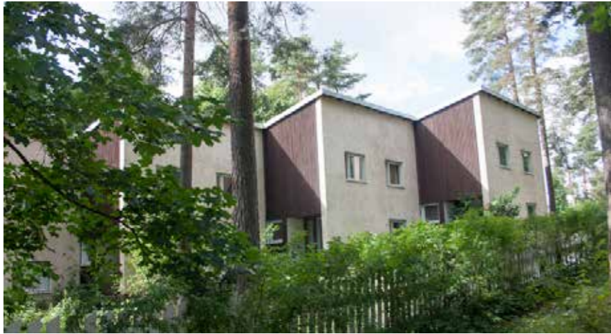
29C Amerin itäinen rivitalo ja kahdesta eri materiaalista jäsennellyt julkisivut. Samoja materiaaleja: tummaksi petsattua puurimaa ja vaaleaksi rapattua pintaa käytti jo Alvar Aalto 1930-luvulla omassa talossaan Munkkiniemen Riihitiellä.
