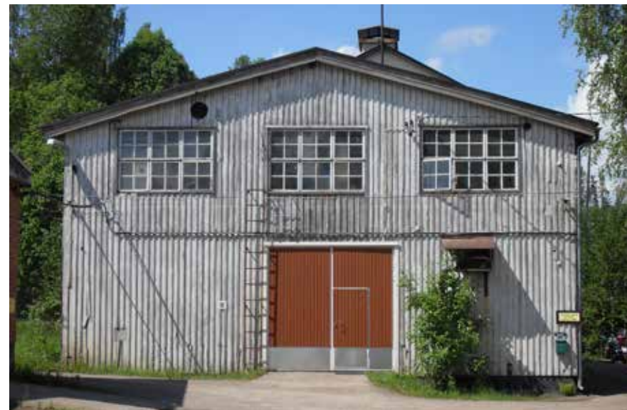
159F Puurakenteinen painosorvaamo.
