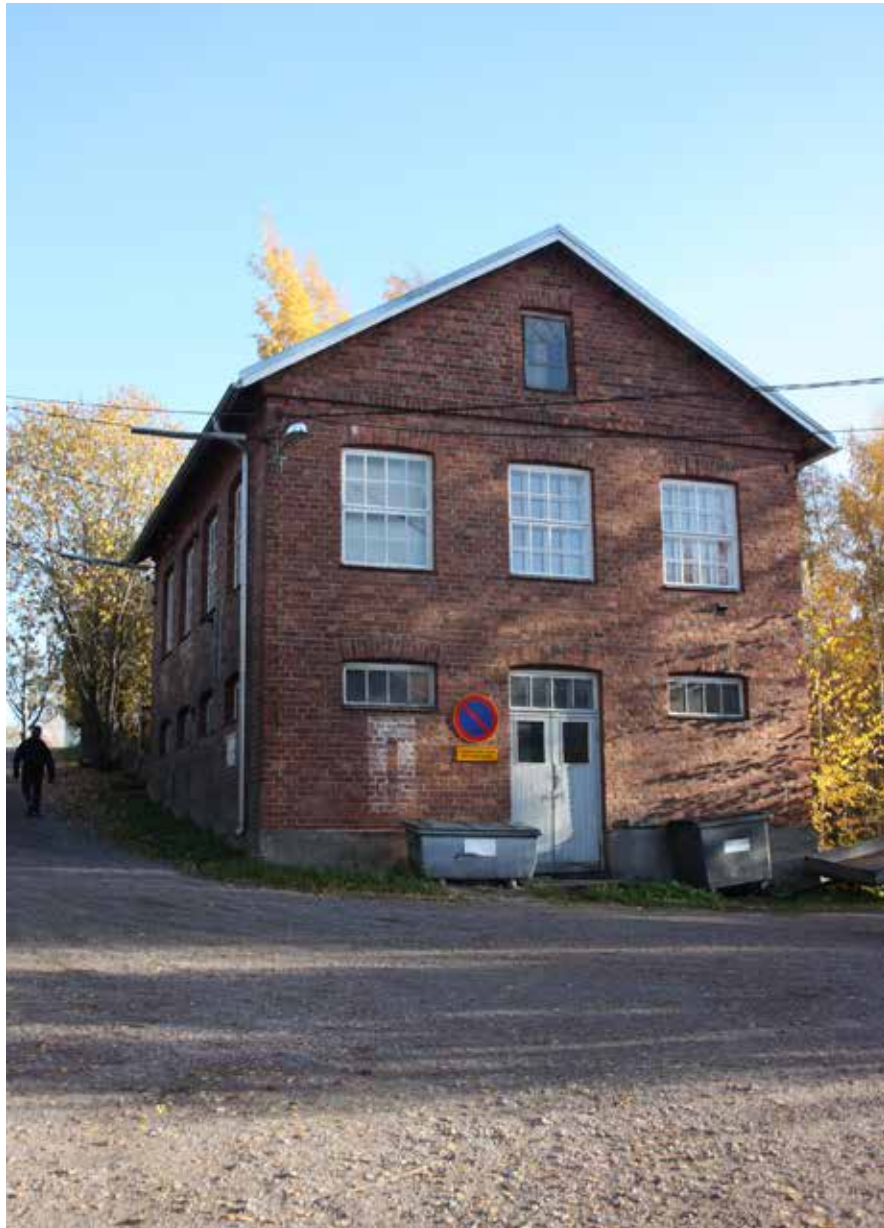
159K Puusepänverstaas kunnostettuine ikkunoineen.
