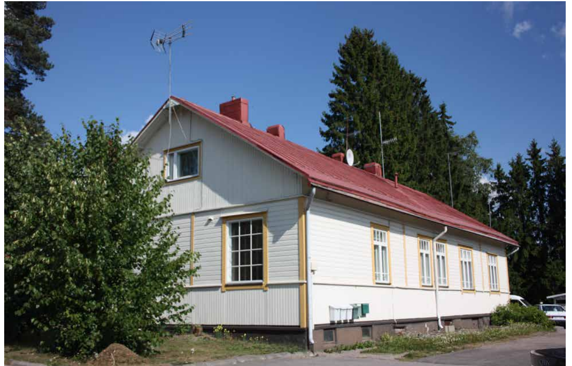
167 Roinilan talo, päädyssä ovesta ikkunaksi muutettu aukko.
