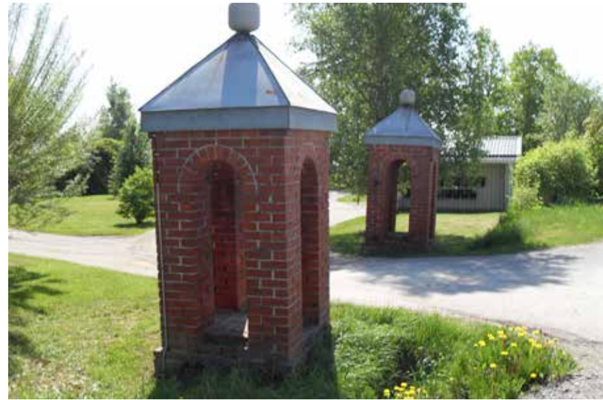
162D Patruunanpuiston porttitornit, jotka ovat kallistuneet ojankaivuun ja muiden muutosten myötä. Pellitys ja huippukoriste ovat 1950-luvun lisiä samaan tapaan kuin tien vieressä olevat maitotonkat tolppien varassa.
