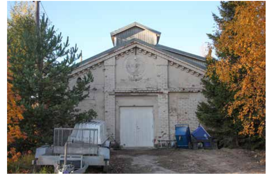
159J Tinaamon pääty toistaa verstaiden ja varastomakasiinin arkkitehtuuria.
