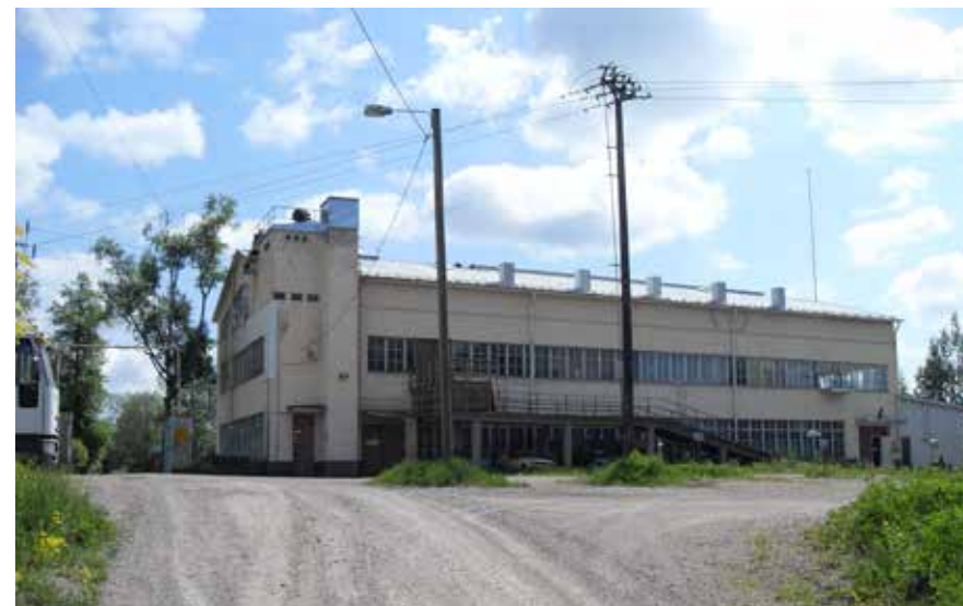
160 Lasipalatsi takapihan puolelta.
