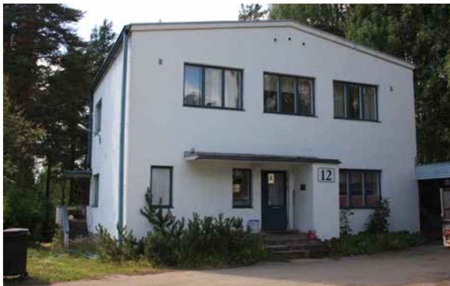
164F Ylilääkärintalon tasakatto on muutettu harjakatoksi.
