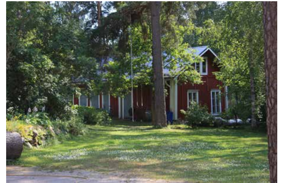
163D Lövbon ulkorakennus pohjoisen suunnasta.
