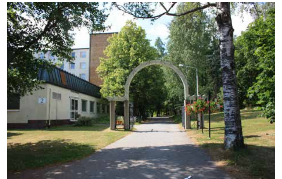
164 Uudelleenrakennettu portti sairaalan alueelle.
