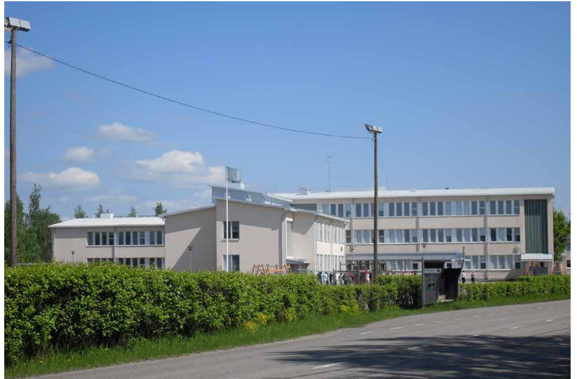
174 Ruukin alakoulu ennen vuonna 2017 rakennettua laajennusta. Keskiakselista pitää ulos vuoden 1997 laajennus.
