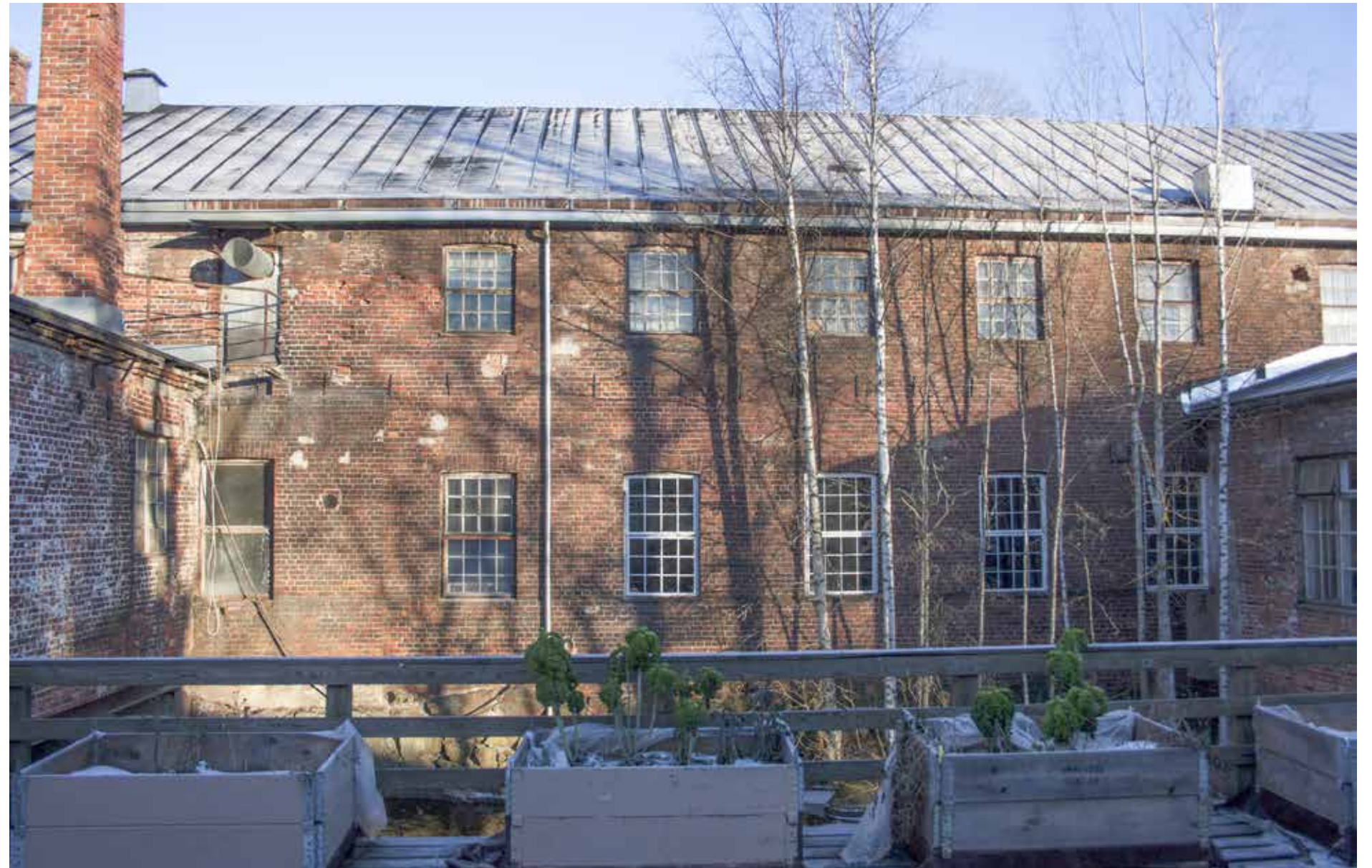
159 B Ali- ja Yläverstas joelta nähtynä kunnostettuine ikkunoineen.
