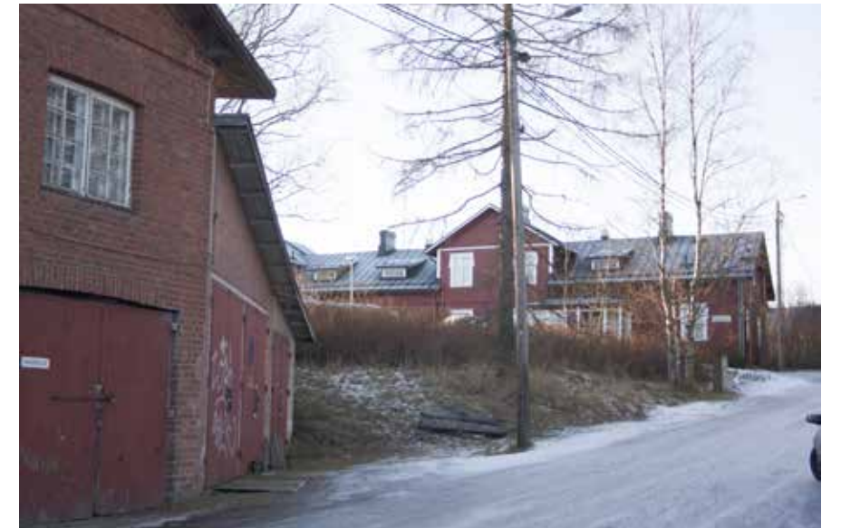
159 H maalaamo ja I autotalli sekä 161 D Uusitalo.
