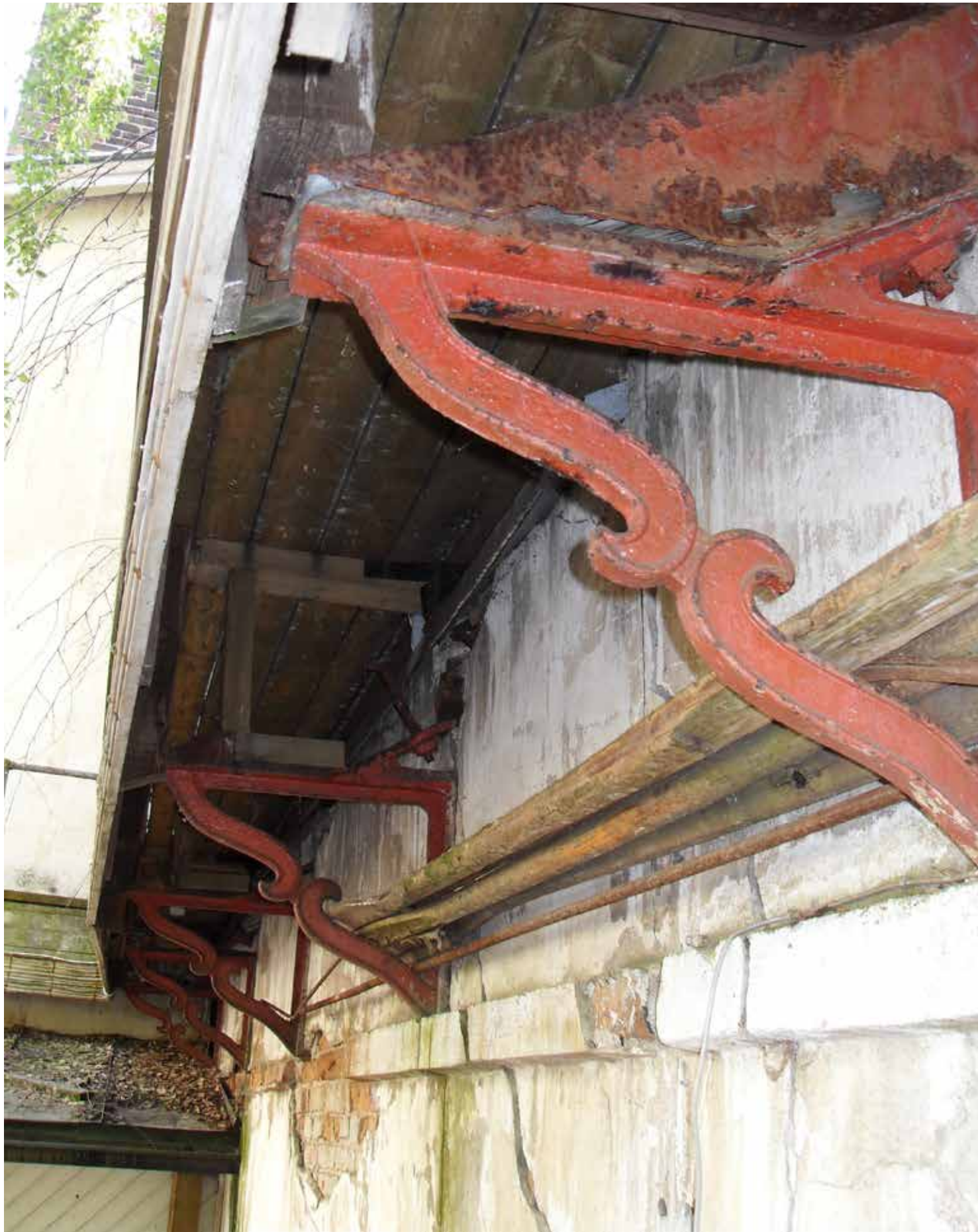
Kellokosken ruukin vasarapajan polonceau-kattotuolien konsolit pistävät ulos tiilimuurista.
