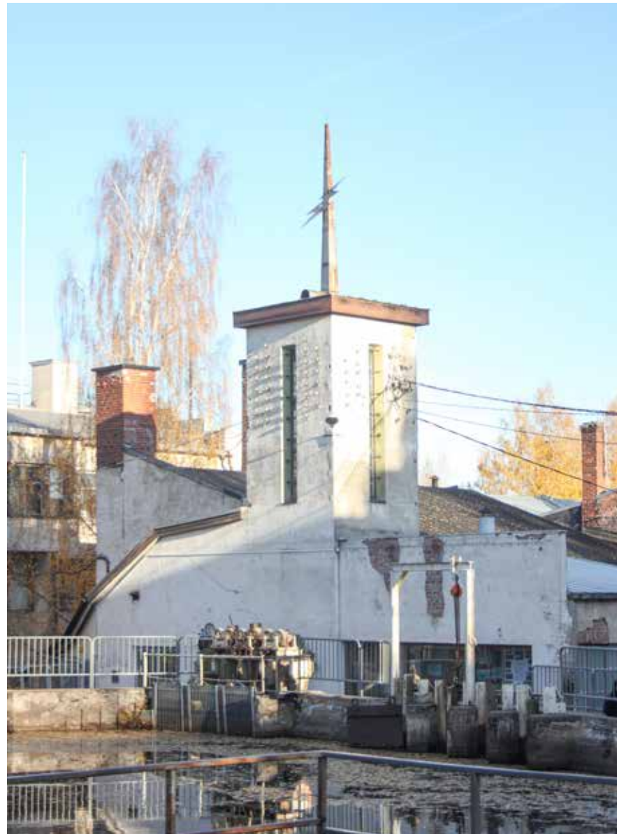
159 D Sähkönjakokeskus on rakennettu vanhan vasarapajan jatkeeksi.
