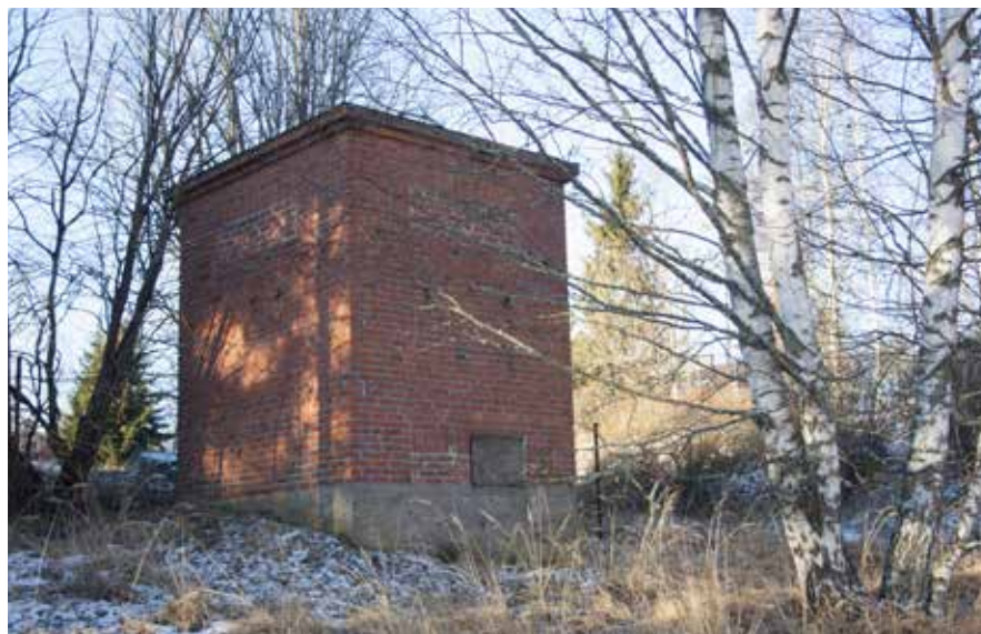
159 Tehtaalle lunastettu ja varastoksi muutettu muuntamotorni.
