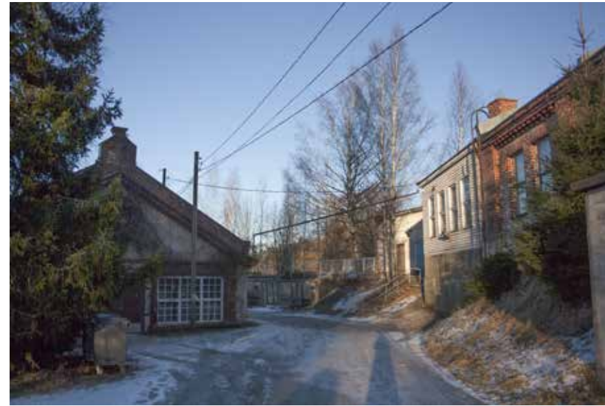
159 C Varasto ja J tinaamo pohjoispäädyn lämpökeskuksineen Ruukinkujalta.
