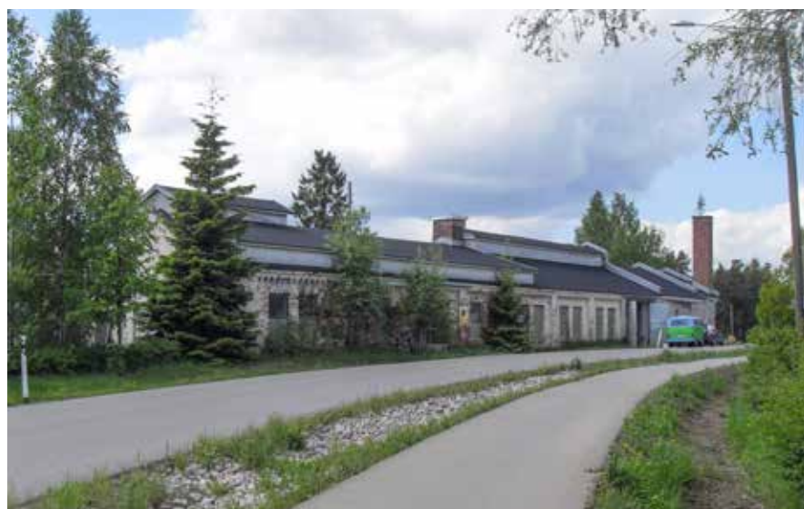
159J Tinaamo, jonka jatkeena oli lämpökeskus ja puutavaravarasto.
