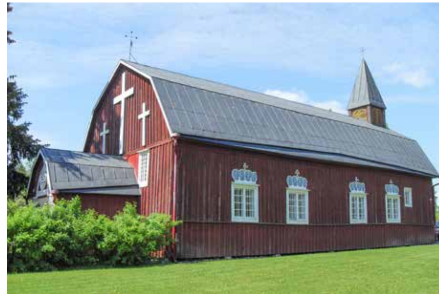
158 Ruukinkirkko idänpuolelta ennen ylläpitomaalausta kesällä 2010.
