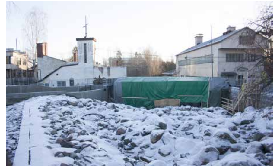
159 E Konttorirakennus D Sähkönjakotorni ja G Kaasulaitos ja uusi koski.
