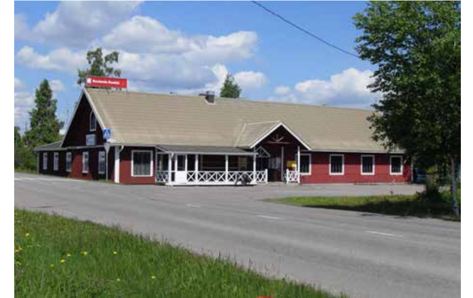
161E Kauppatalo eli ravintola Ruukki etelästä, vasemmanpuoleinen siipi alkuperäinen, oikeanpuoleinen uudisosa.
