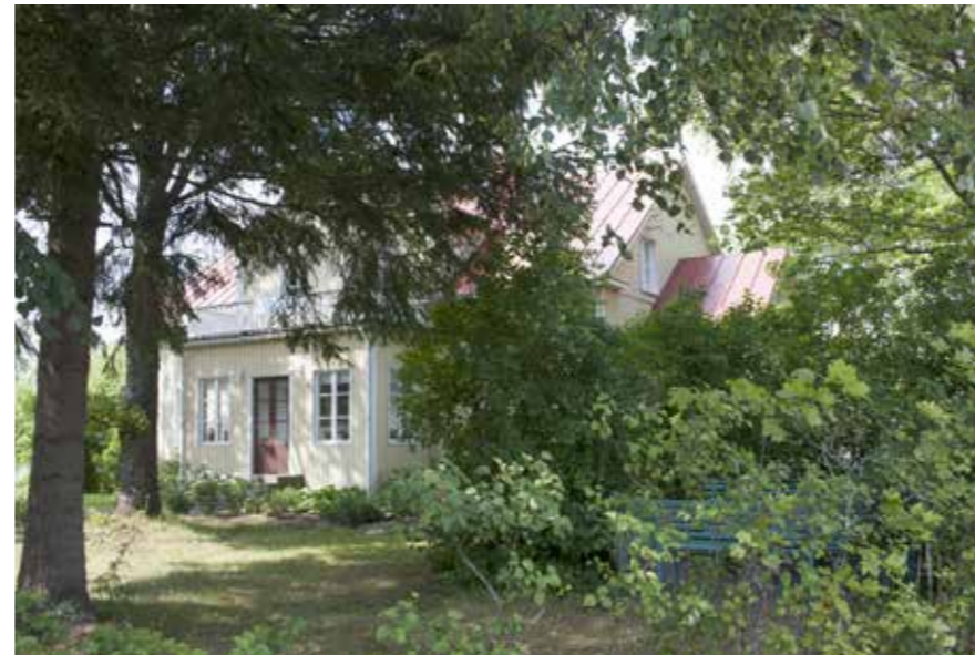
133A Päärakennuksen pääjulkisivu.
