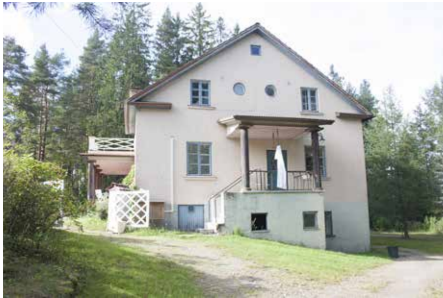
151 Malmarin päärakennuksen pääty ja ns talouskuisti.
