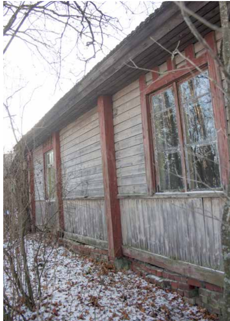
144A Lepänojan vanha päärakennus idän puolelta.
