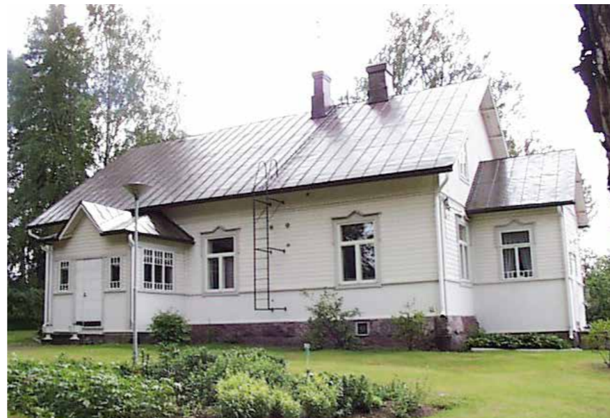
131 Söderkullan päärakennus idästä, pihan puolelta. PS.
