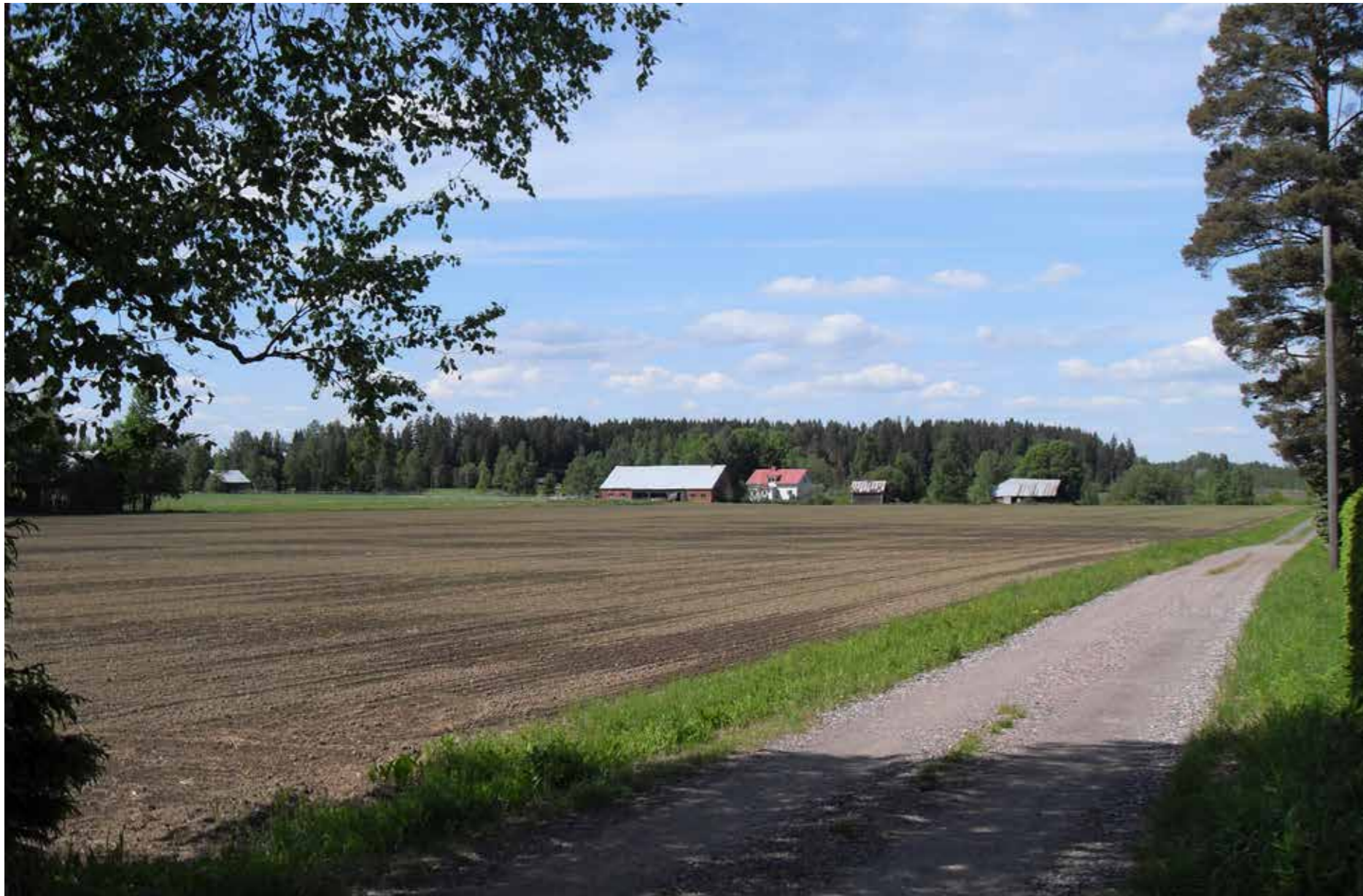
215 Anttilan tilakeskus: ladot, navetta, asuinrakennus, sauna ja riihi.
