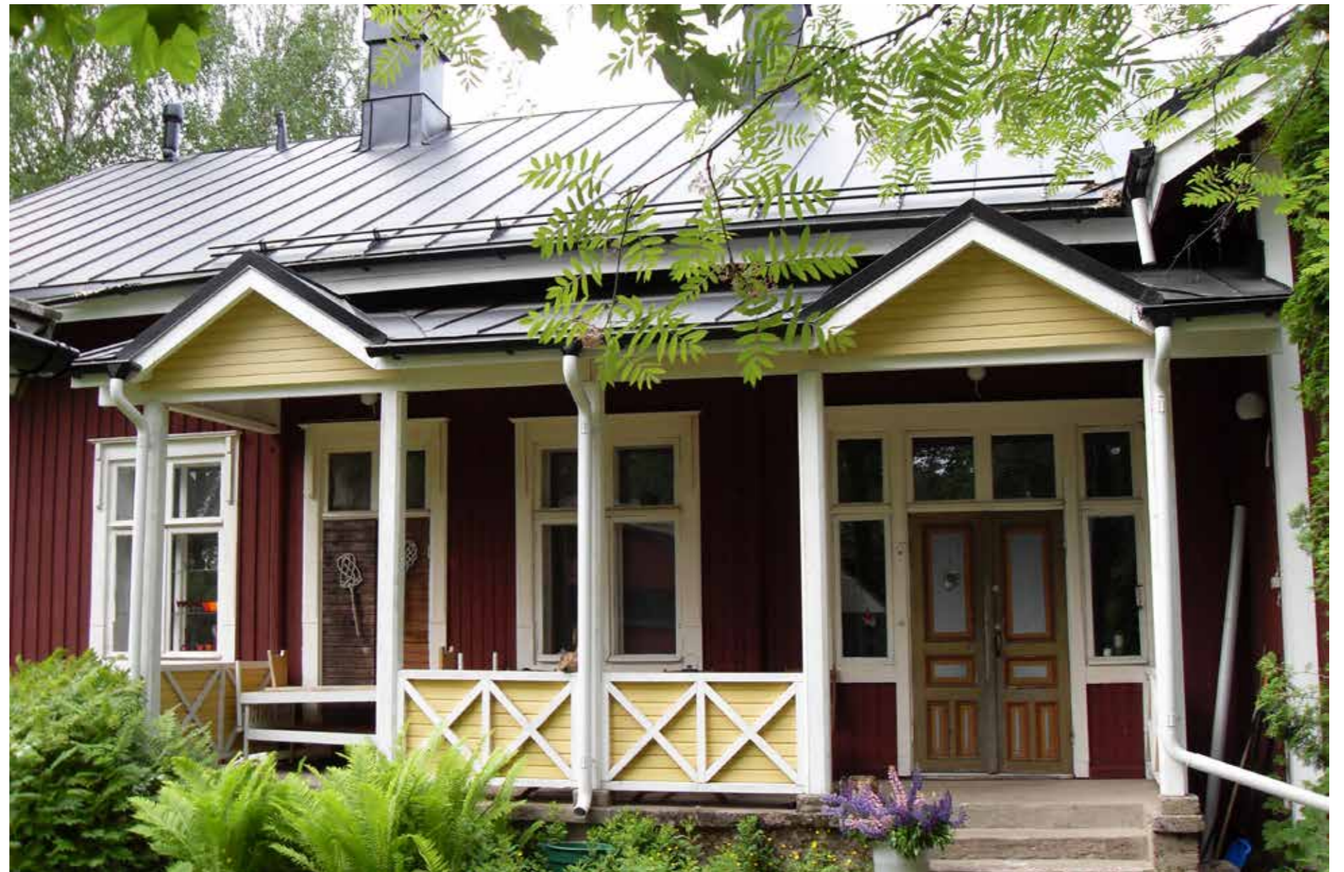
149A Nummenkylän yläkoulu sisäänkäyntikuisti.
