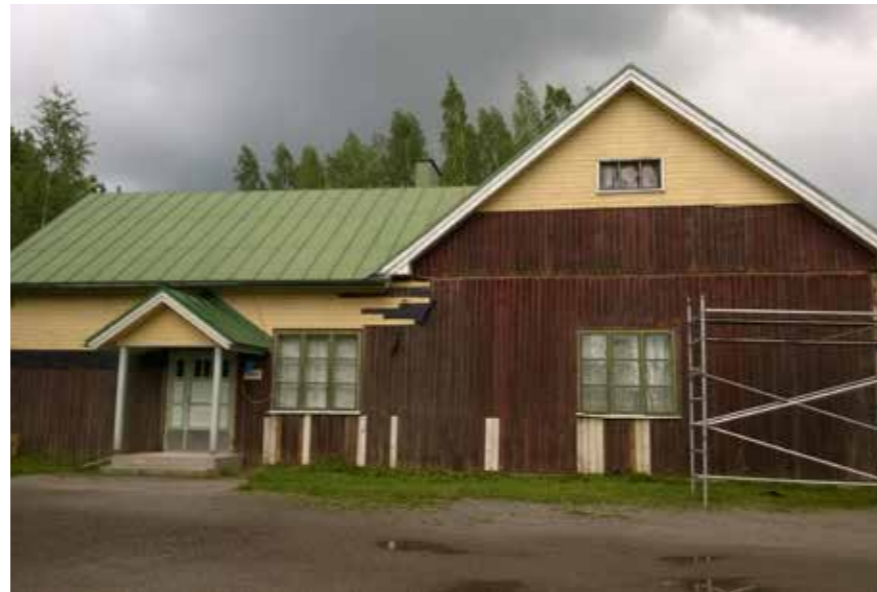
155 Linjala julkisivun uudelleenvuoraus paljasti alkuperäisen värityksen ja pystyvuorauksen. Uusi ulko-ovi ja katos rappuineen lisättiin vuonna 2012.
