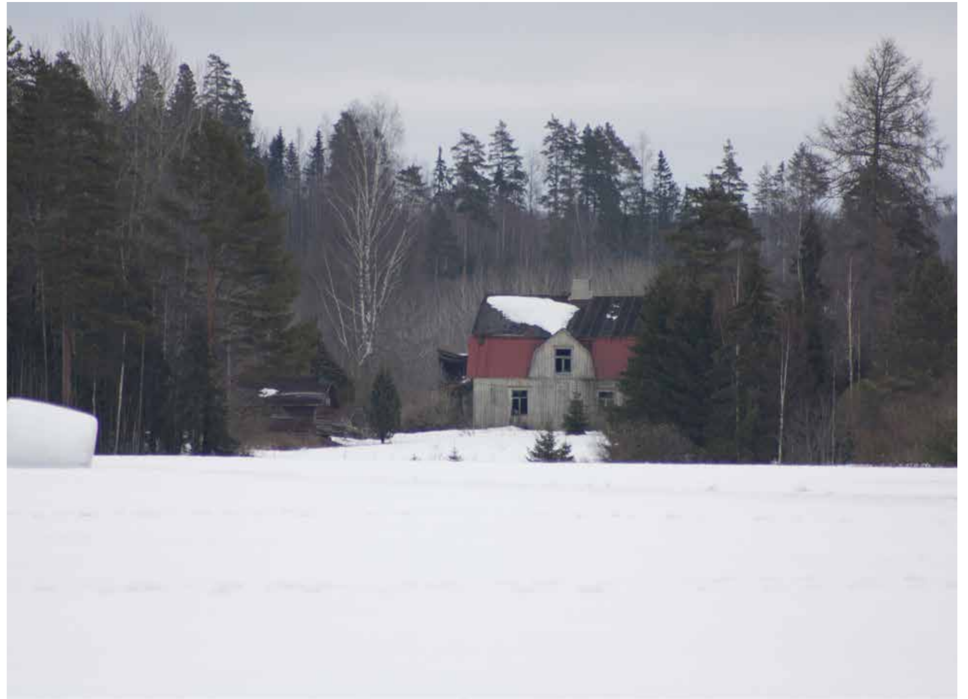
132B Ojalan taitekattoinen asuinrakennus.
