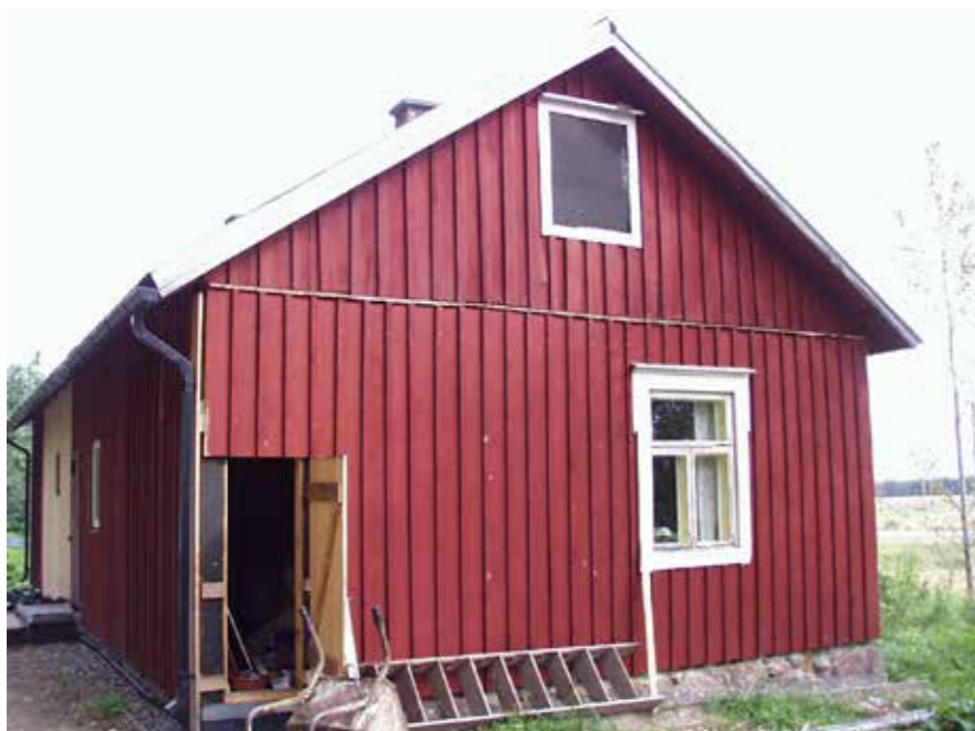
124 Rinteen asuinrakennus 2005 kunnostustyöt kesken. PS.
