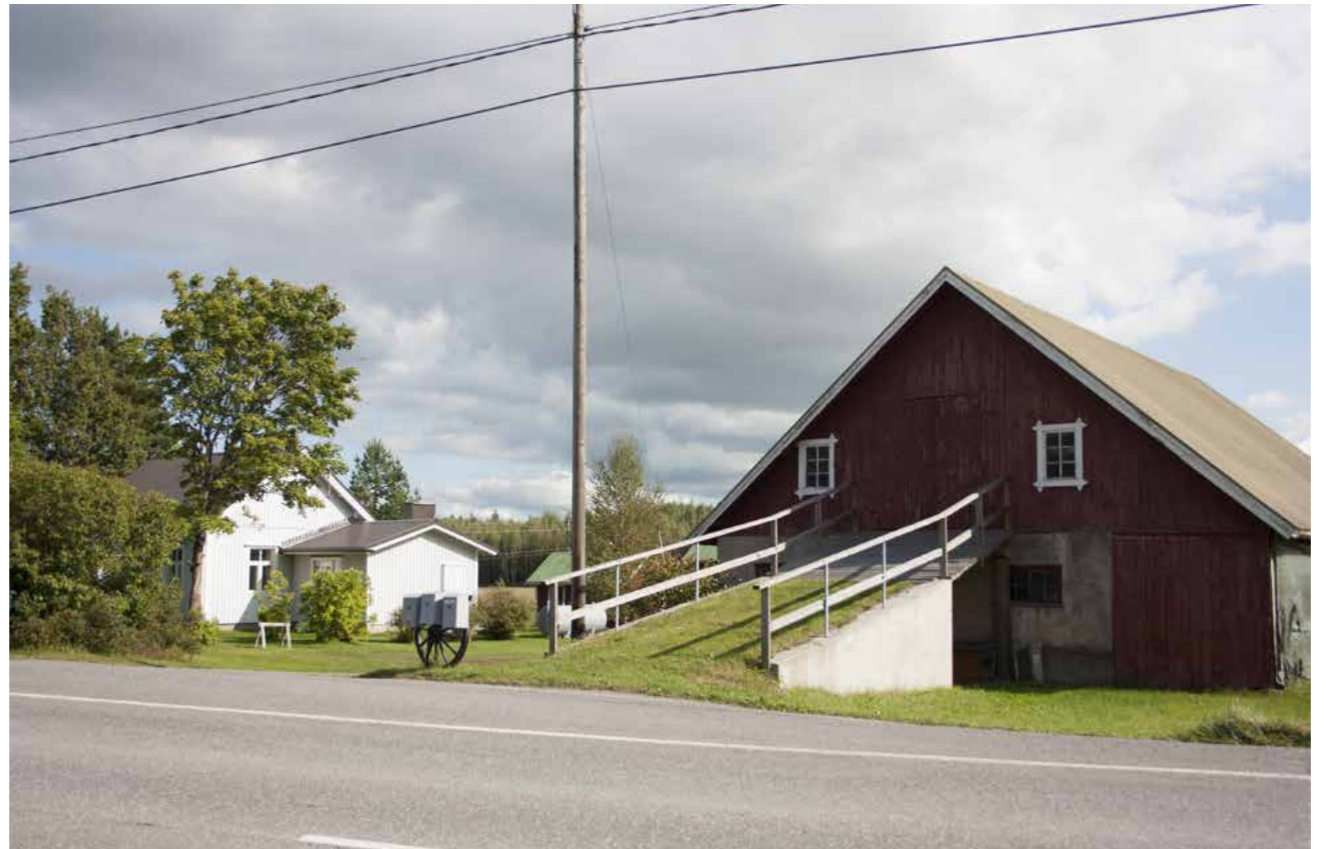
123D Nurmelan päärakennus ja 123E navetta.
