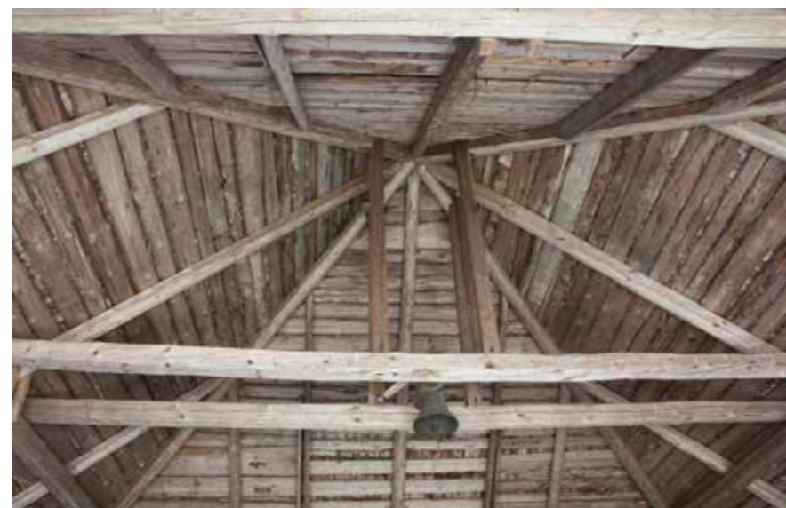
129D Mykkylän makasiinin komea kattorakennelma on alkuperäinen, seinät on uusittu.
