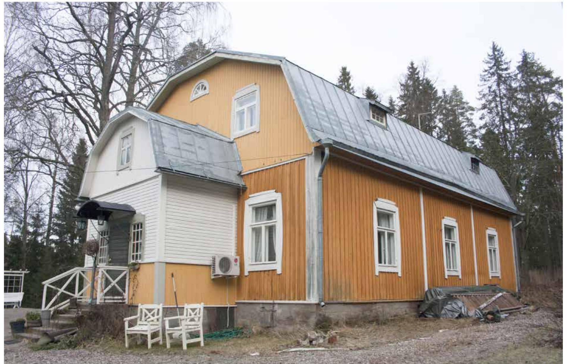
135 Lehmusvaaran päärakennus puutarhan puolelta kunnostettuna.
