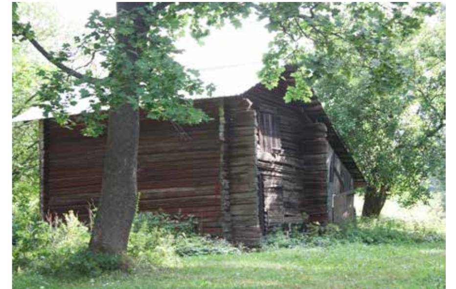
134B Junttilan poskellinen kaksikerroksinen aitta on poikkeuksellinen rakennustyyppi Tuusulassa.
