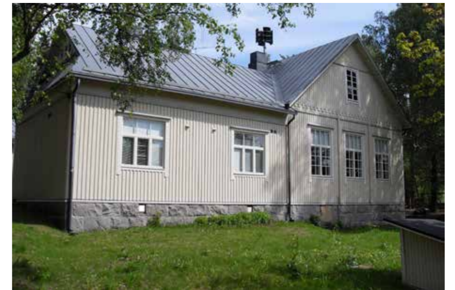
156 Koulun yleisilme tielle päin on säilynyt alkuperäisen kaltaisena.
