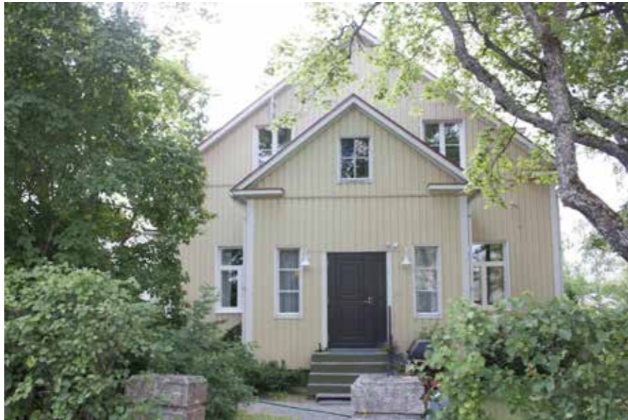
133A Tammilehdon päärakennuksen päätykuisti.
