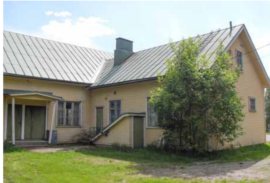
155 Linjalan sisäpihalta on kulku suoraan juhlasaliin. Keittiön ovi on suljettu.
