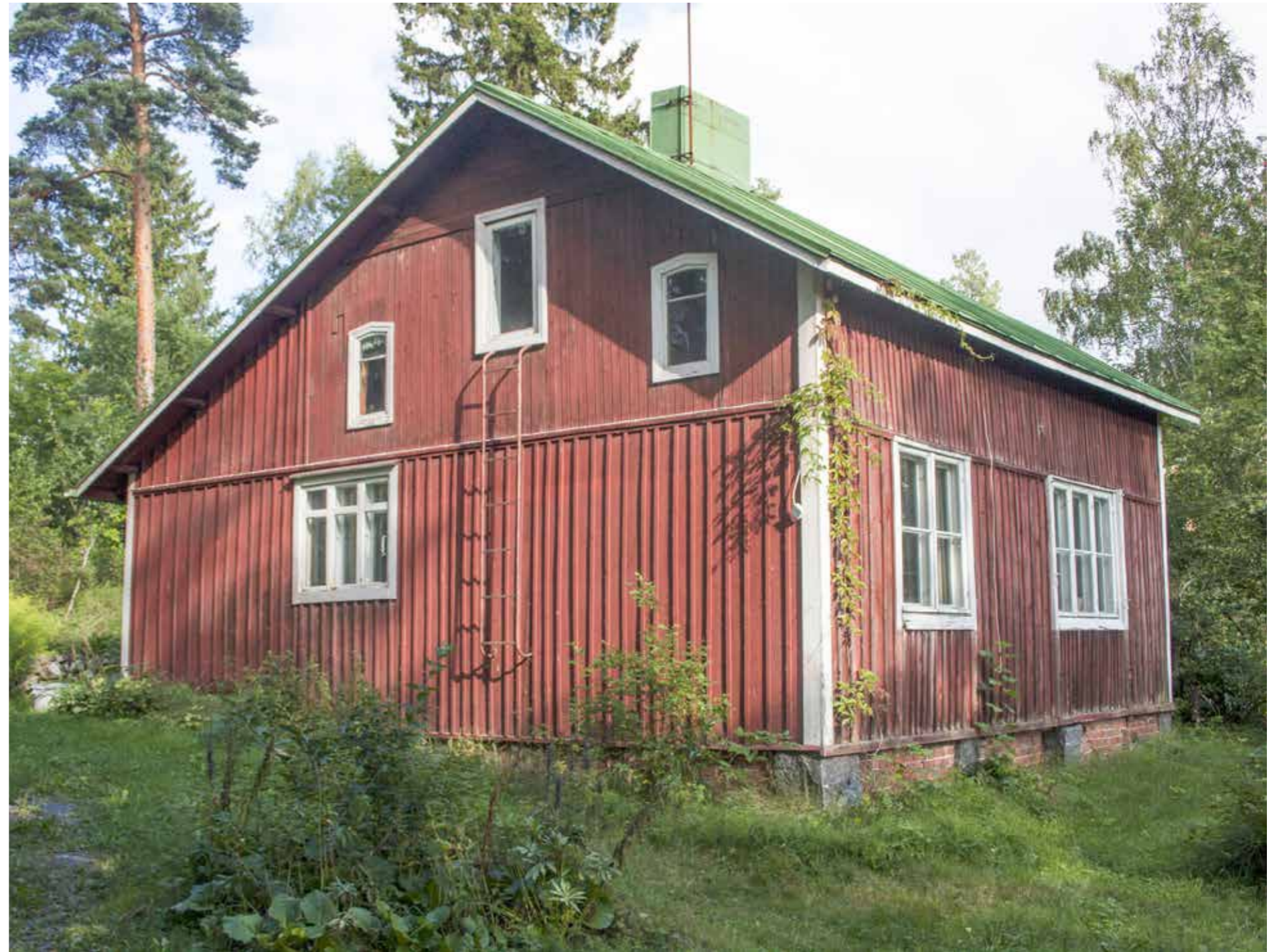
143 Riitahuhta ja muuttunut kattomuoto.
