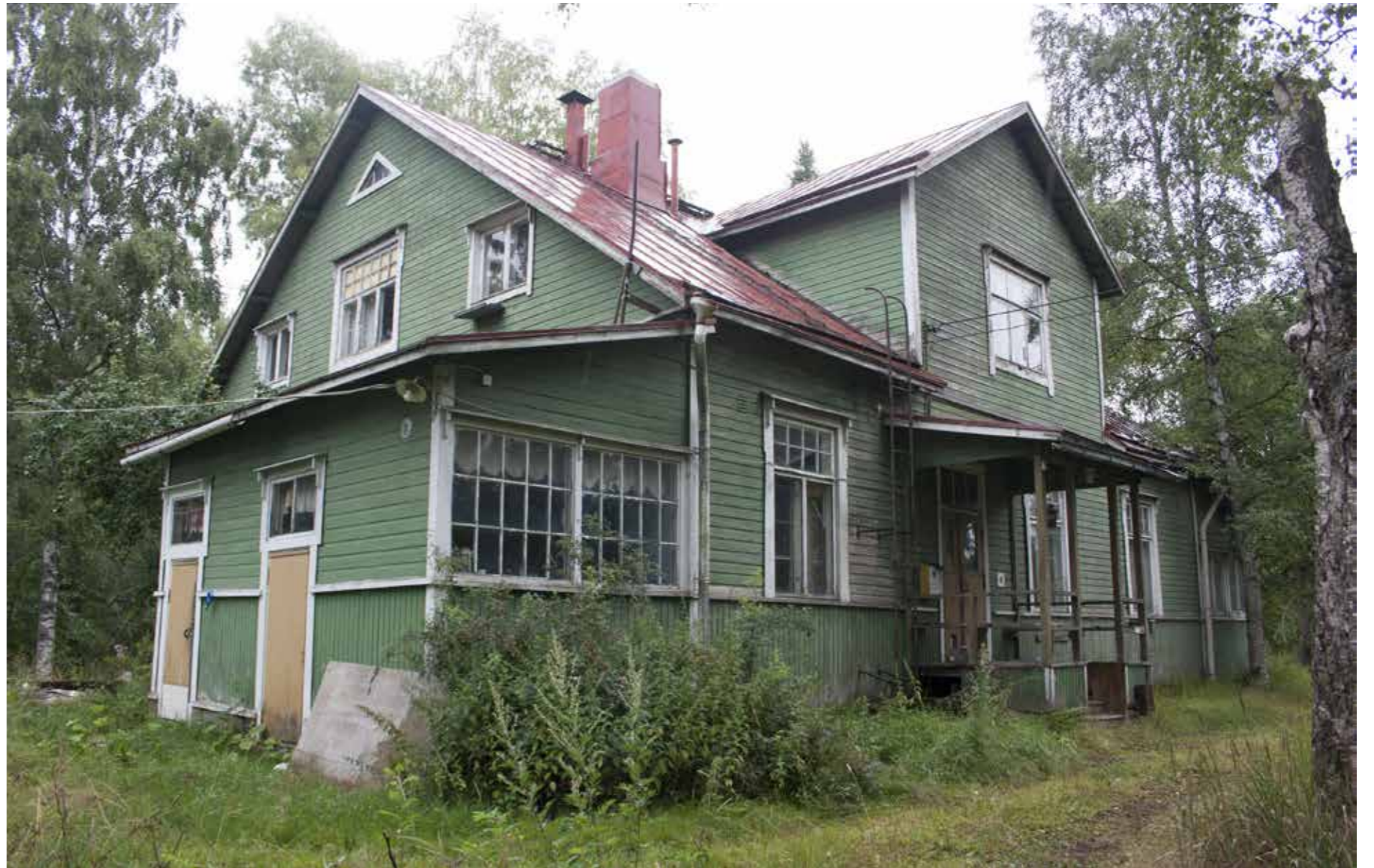
137A Tehtaala eli Jokelan Valun isannoitsijantalo.
