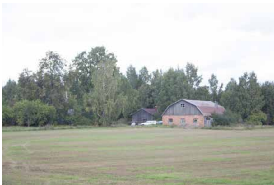
152B Furunäsin taitekattoinen tiilinavetta ja pihapuustoa.
