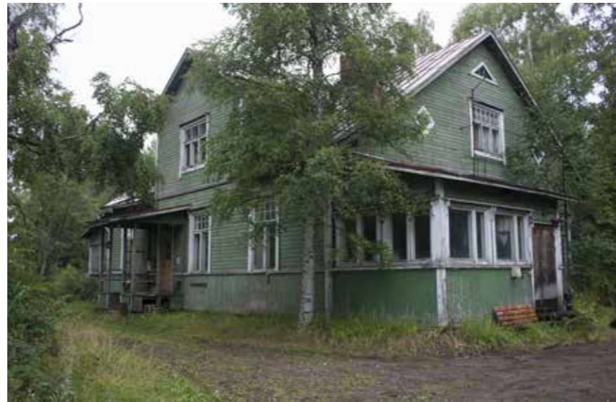
137A Tehtaala eli Jokelan Valun isannoitsijantalo.
