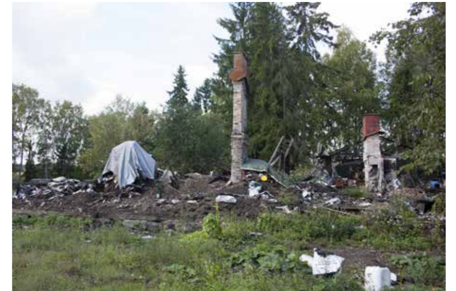
152 Murron loppuvuodesta 2009 palanut päärakennus.
