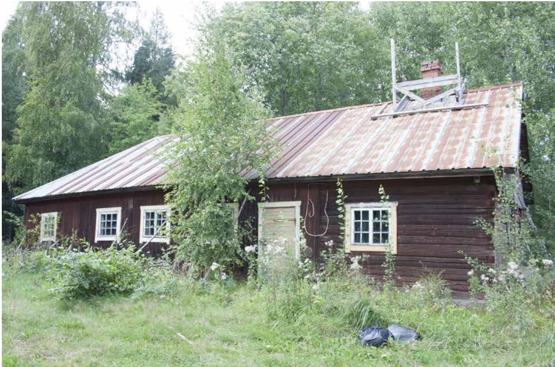
142B Kantamaan hirsinavetta purettu 2016.
