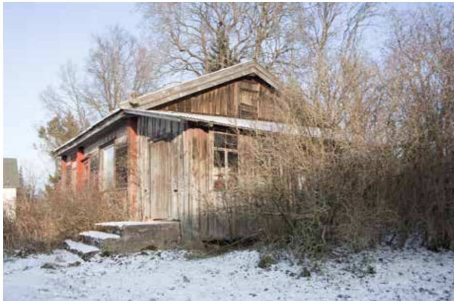
144A Lepänojan vanha päärakennus etelästä ja ullakon ulkoluukku.
