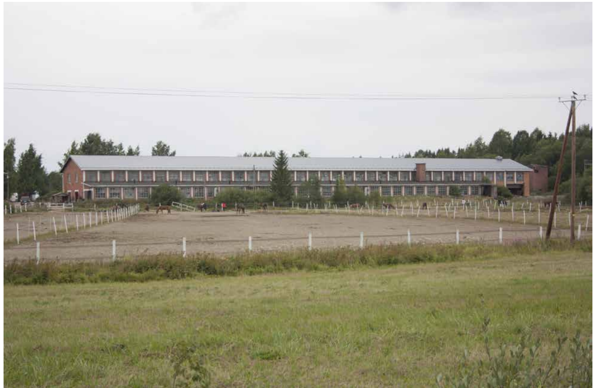
136 Raken vanha tiilitehdas on nykyisin maneesi ja talli.
