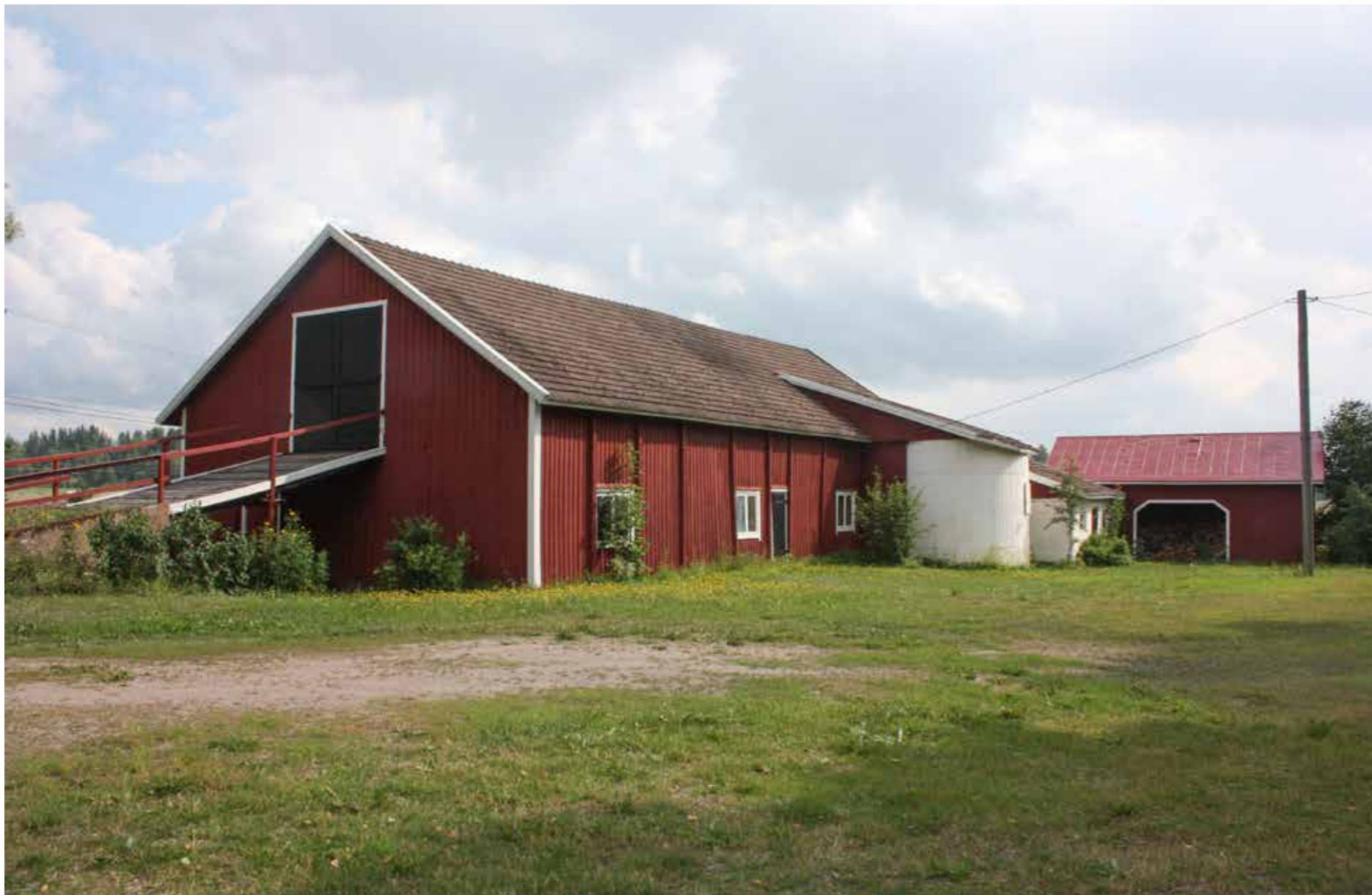
133B Hirsirakenteinen navetta ja vajarakennus.
