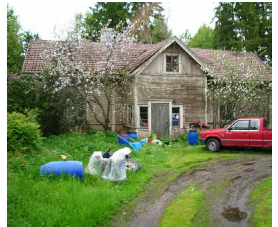
152 Kellokosken Murron päärakennus ennen paloa kesällä 2005 PS.
