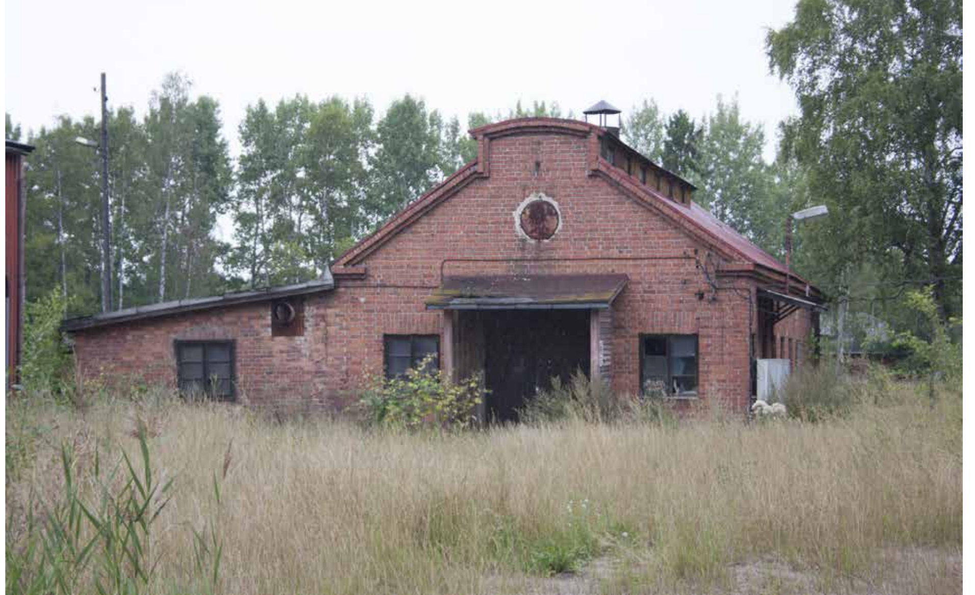
137D Jokelan Valun vanha valimo Toimela asuntopäätyineen ja sivusiipineen.
