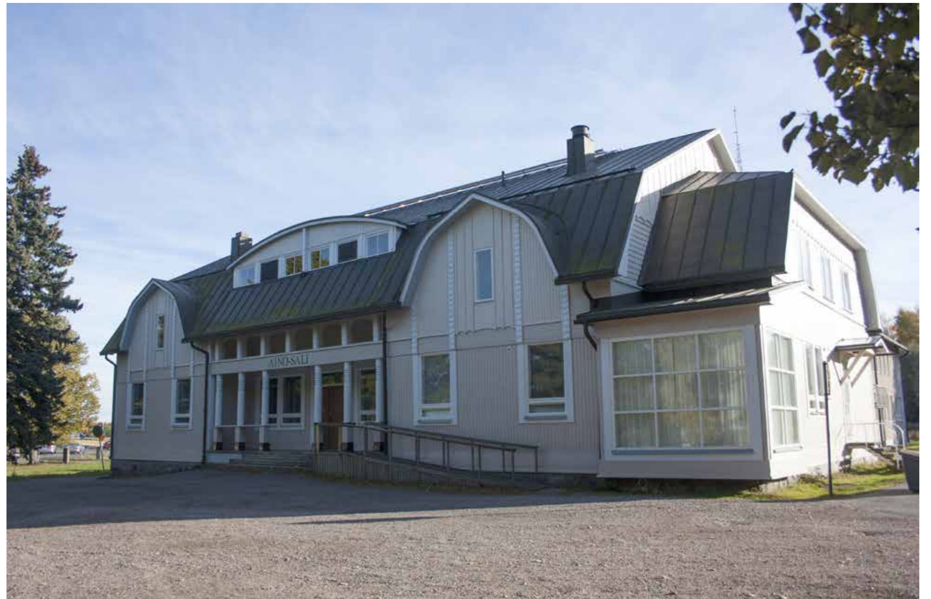
63 Tuusulan vanhan kunnantaloon pääjulkisivu ja myöhemmin lisätty ramppi sekä lasierkkeri.
