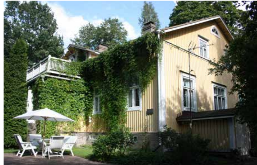
61 Kirkonkylän Saksan päärakennuksen eteläpääty eri kokoisine ikkunoineen.
