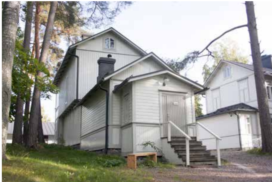
72A Onnelan Jukolan porrastettu länsipääty.
