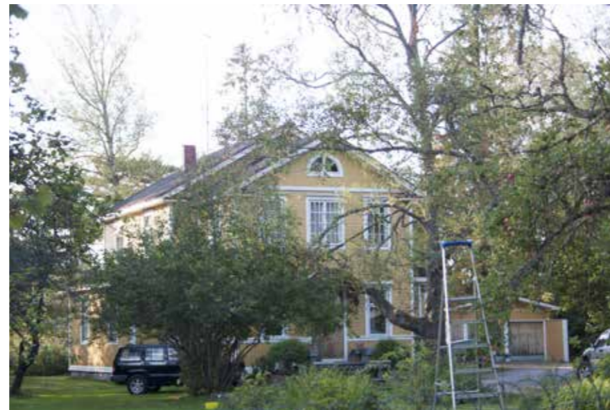
74 Bergbon itäpääty ja koristeelliset ikkunat.
