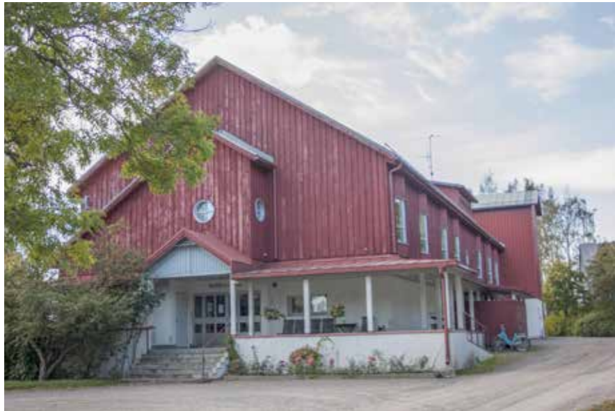
64D Krapin navetasta rakennettu hotelli.
