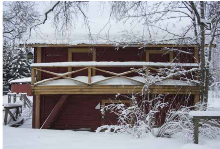
64A Krapin luhtiaitta miltei alkuperäisessä asussa 2010.
