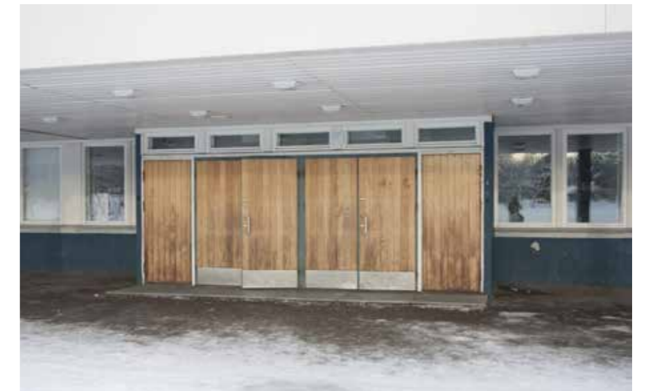
48 Pääsisäänkäynnin ajalleen tyypilliset lakatut puuovet ja väritys: valkoinen ja sinivihreä sokkeli.
