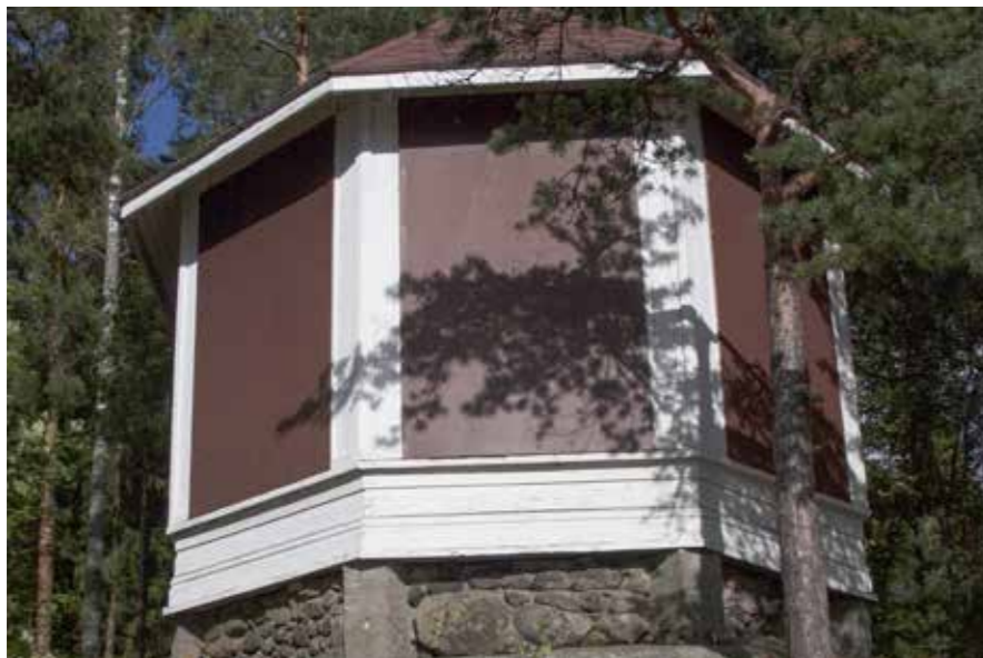
68C Fjällbon huvimajan koristeelliset ikkunat on peitetty ilkvallan takia.
