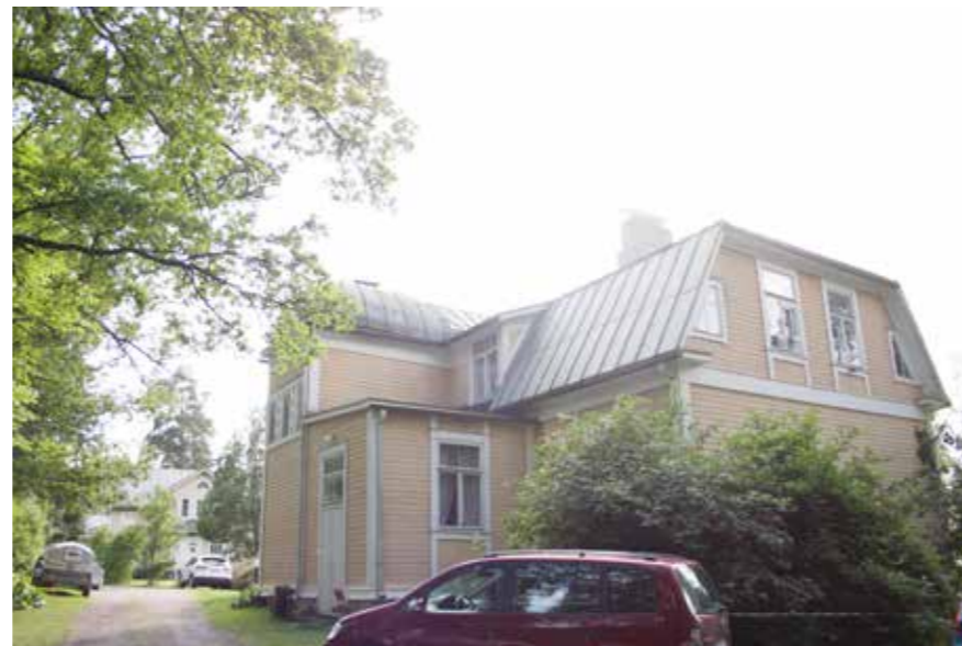
69 Syvälahden päärakennus ja myöhemmin rakennettu uudisrakennus.
