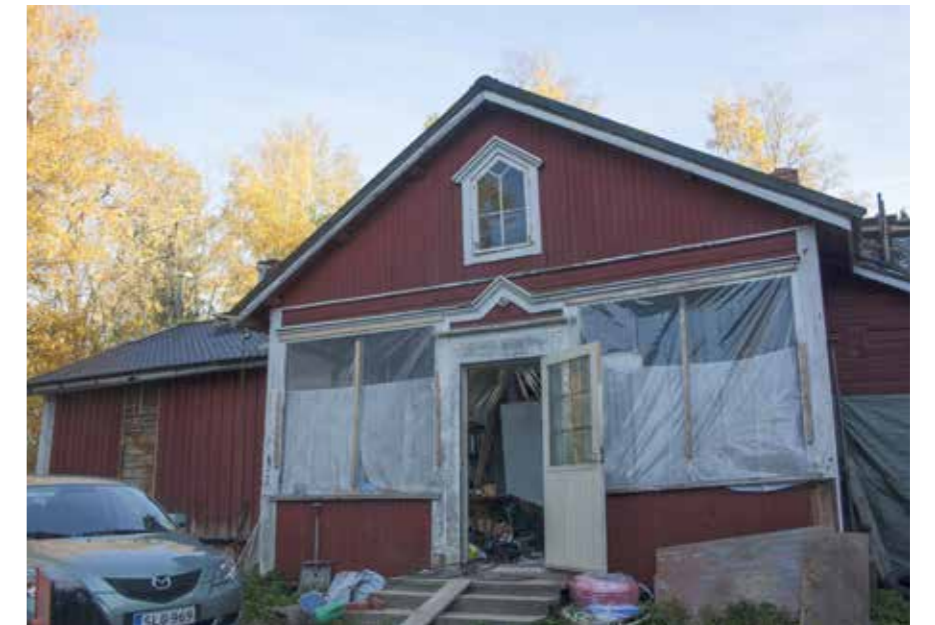
57 Ali-Kotun pääkuisti kunnostustöiden aikana 2013.
