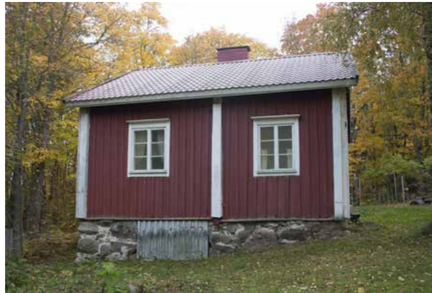
54 Nordbergin mökki pohjoisjulkisivultaan - korkea kivijalka on mahdollisesti taloa huomattavasti vanhempi.
