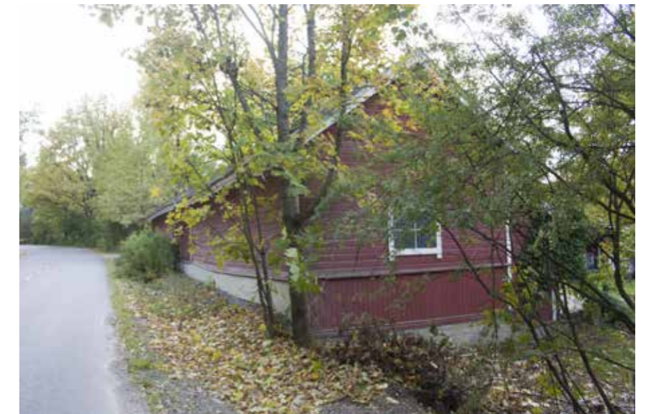
51B Bjelastotskyn aikaisen kärryvaja- ja tallirakennuksen pohjoispäätty ikkunoineen.
