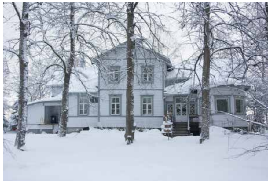
64 Krapin päärakennuksen länsijulkisivu ja pääsisäänkäynti.
