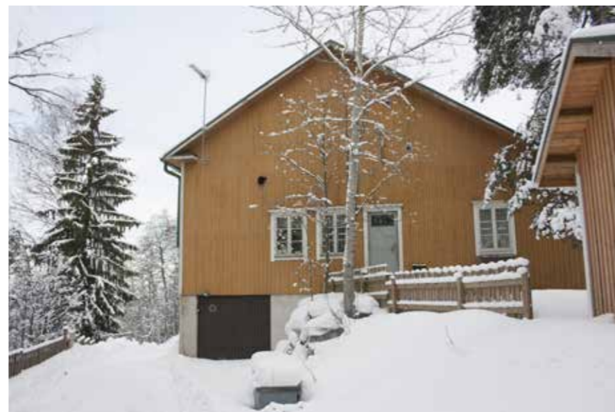
46 Väinölän eteläpääty on uudisrakennus.
