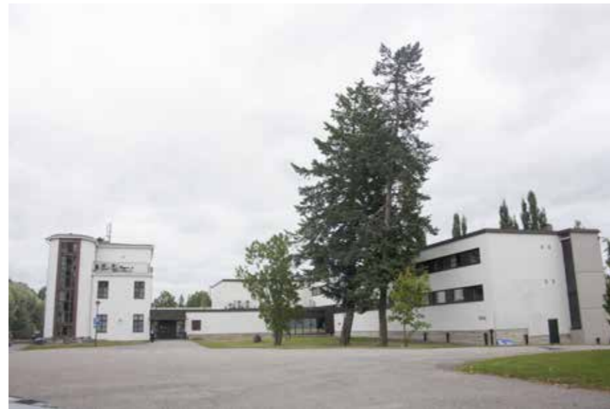
78C Taistelukoulun pääjulkisivu etelään.
