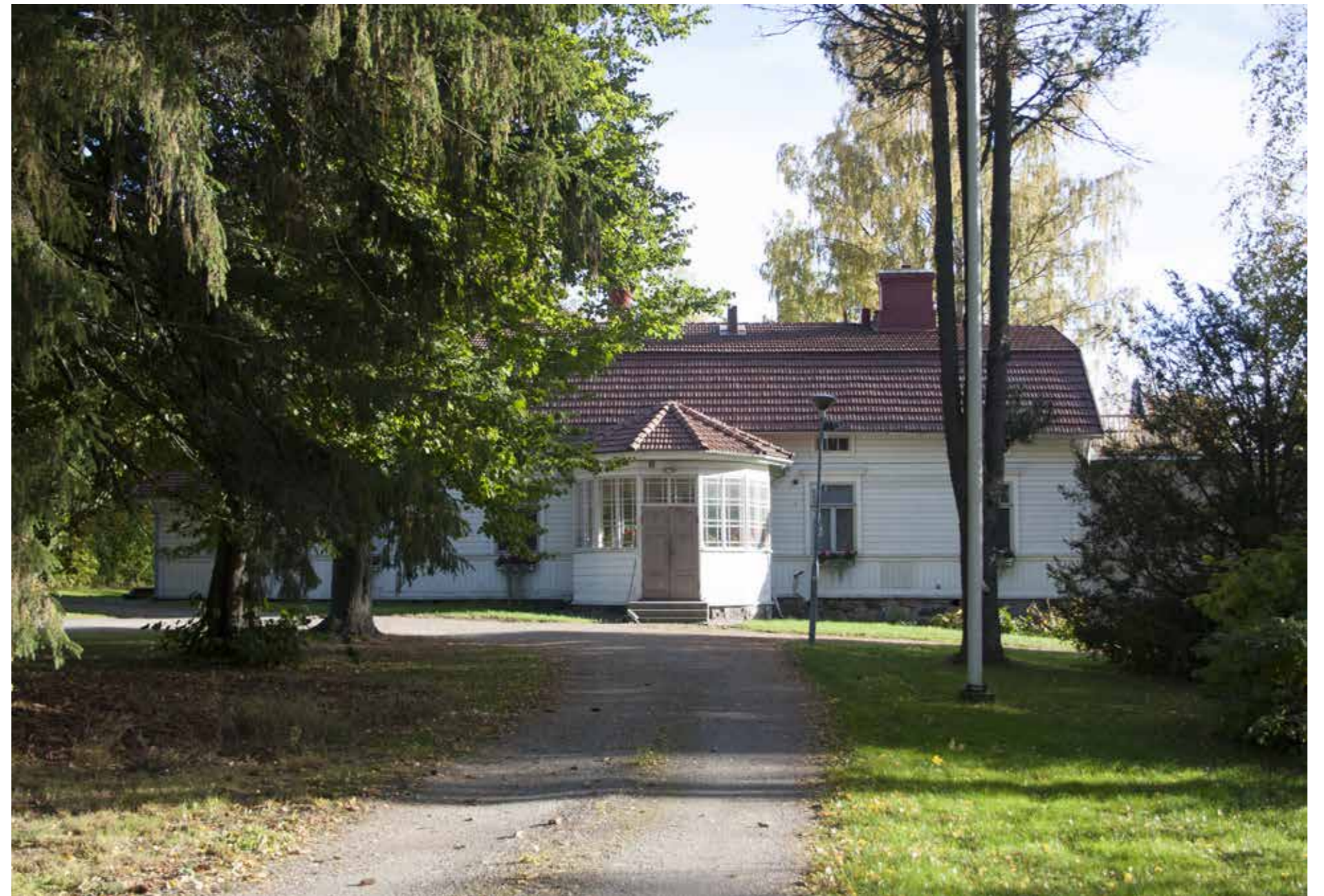
58 Pappilan pääjulkisivu lasikuisteineen Kirkkotien suunnasta.
