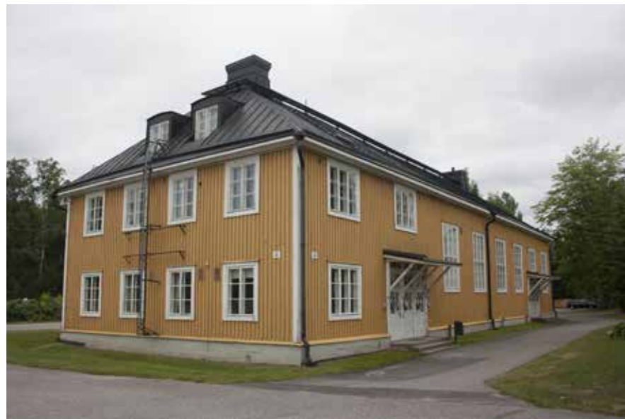
78E Levälä pihan puolelta sisäänkäynteineen.
