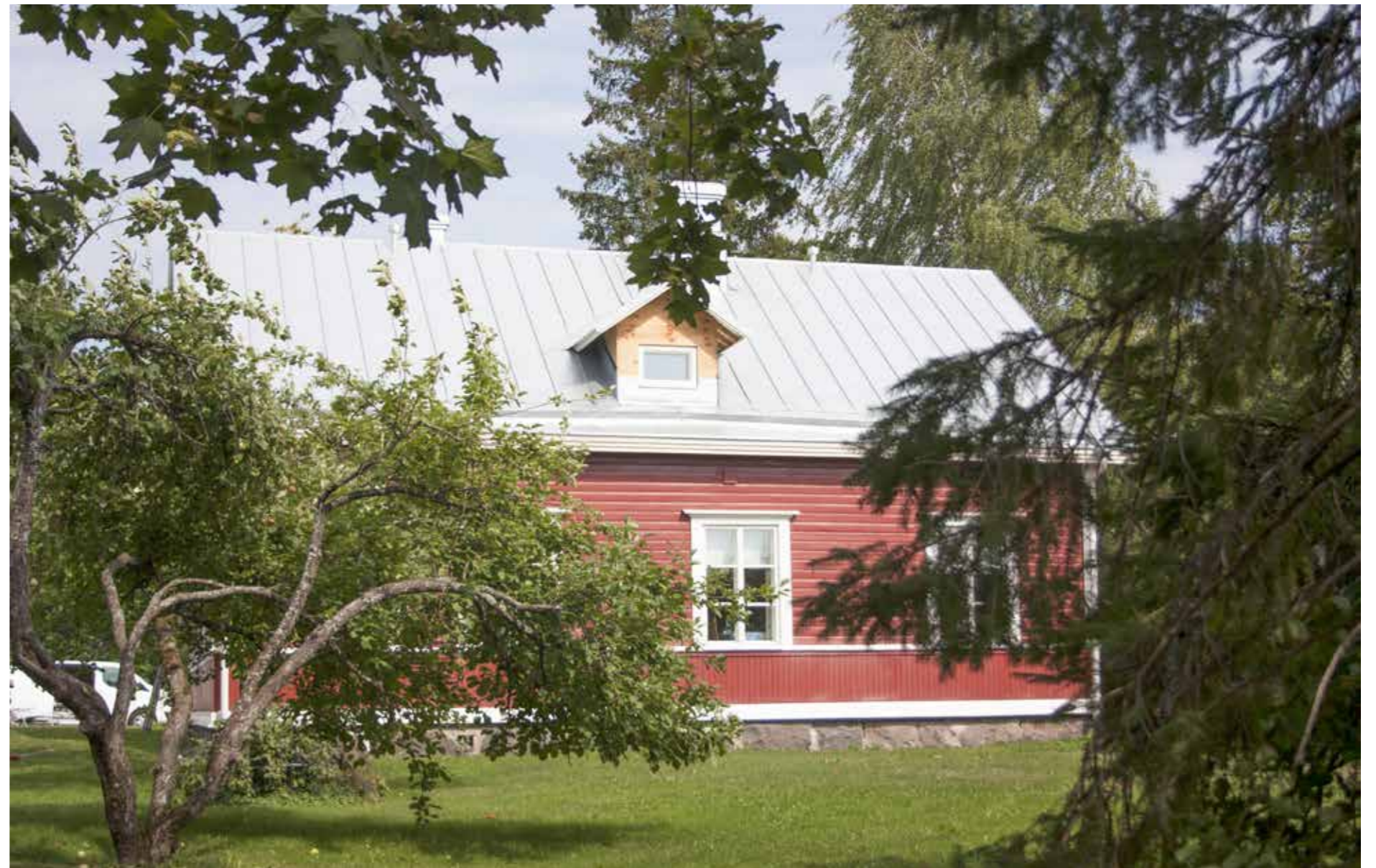
82 Immolan päärakennuksen eteläjulkisivu ja katolle lisätty uusi lapeikkuna.
