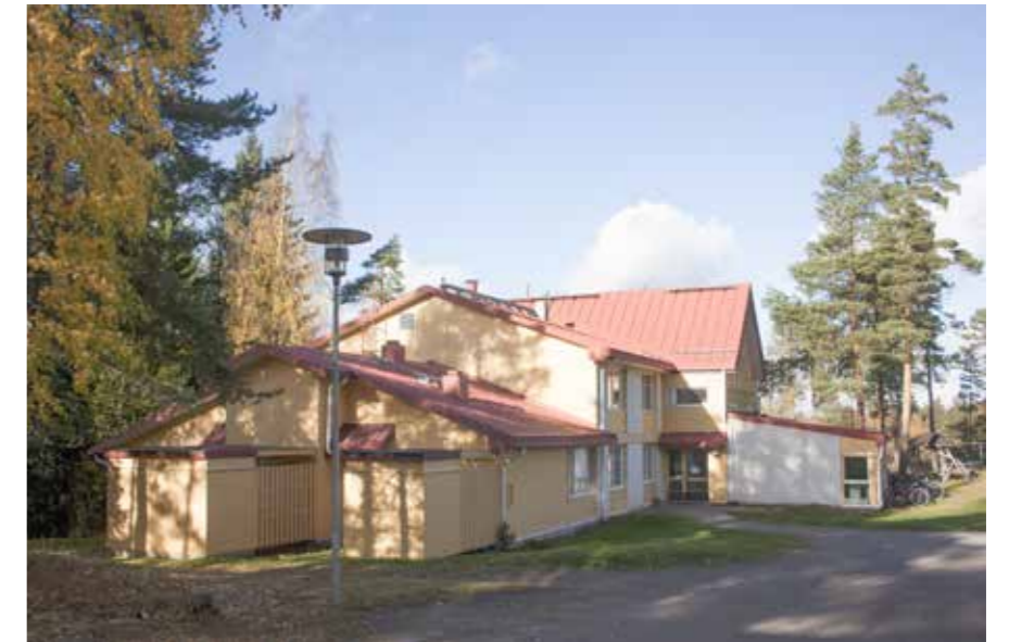
90 Kansanopiston asuntolarakennus 1980-90-lukujen vaihteesta.
