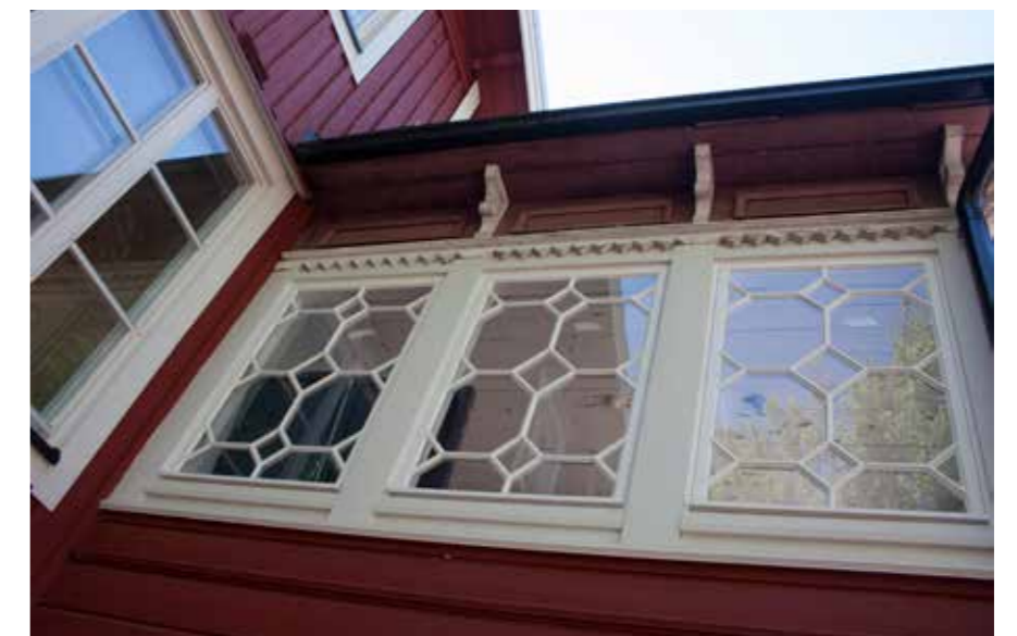
55 Kansakoulun kuistin koristeellinen ikkuna pitsimäisine puitteineen.
