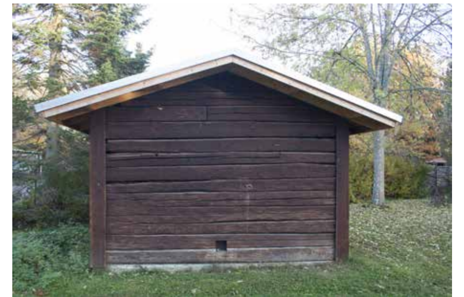
71A Erkkolan saunan pääty, turvekatto on purettu.
