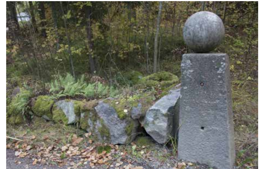
250F Portinpylväessä on reiät portinsaranatapeille. Kiviä on toteutettu latomalla luonnonkiviä.
