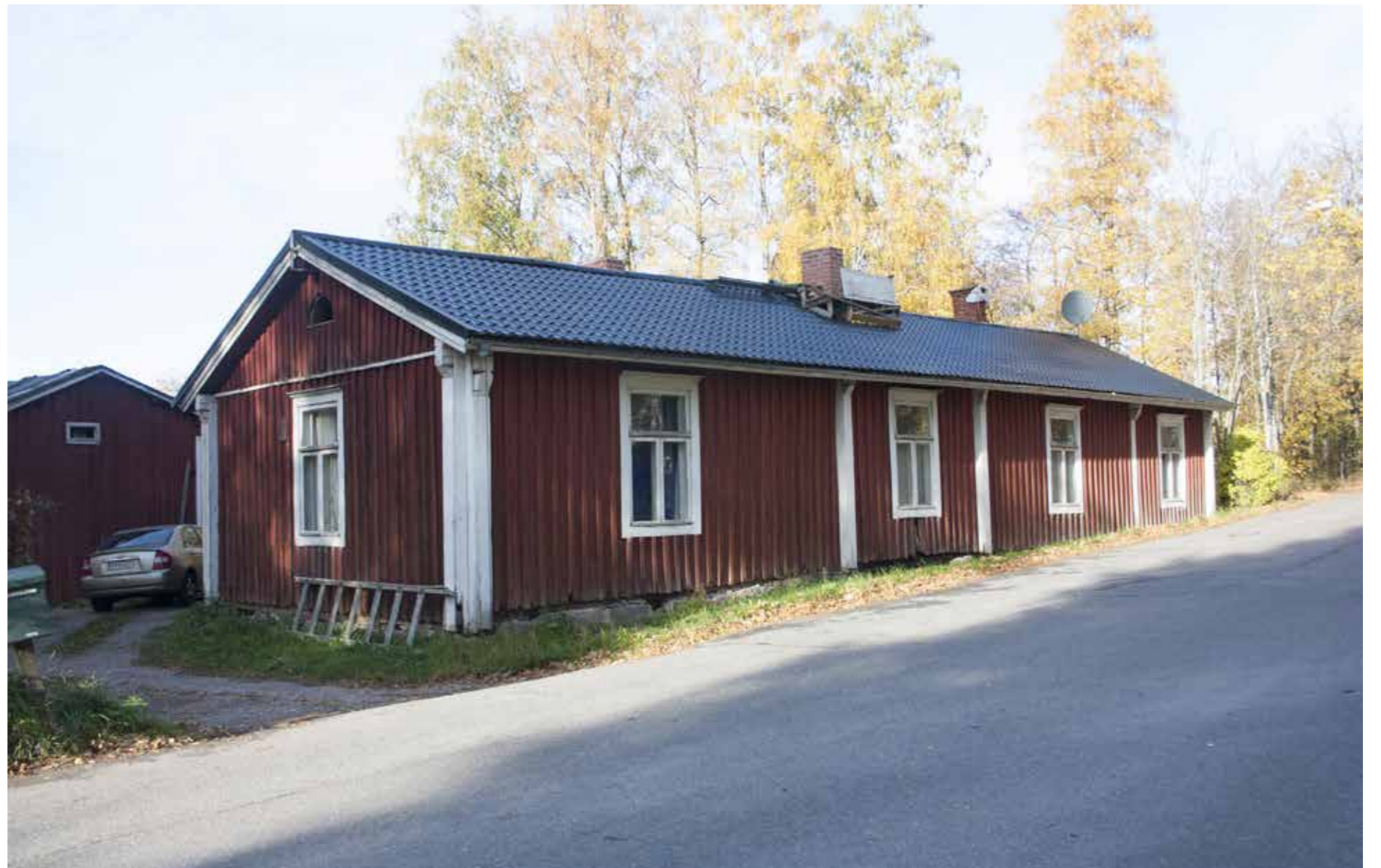
57 Ali-Kotun päärakennus on tiessä kiinni ja osittain tienpintaa alempana.
