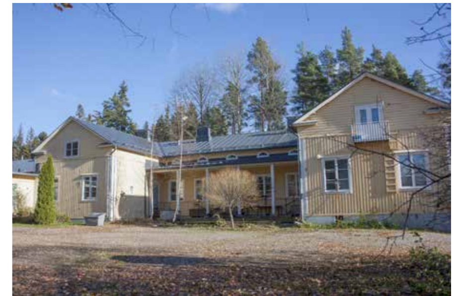
89 Tuomalan koulun länsijulkisivu on samalla pihan puoli.
