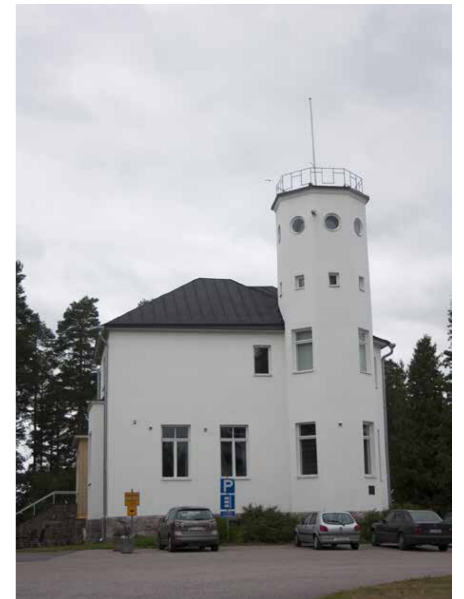
78B Sandbergin huvila upseerikerhoksi muutettuna ja korotettuna.
