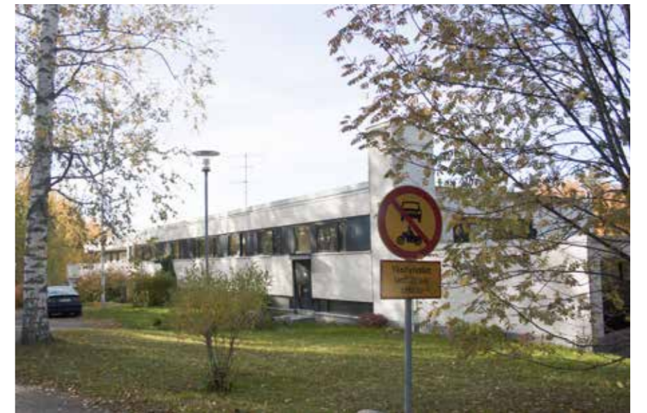
56C Rivitalon sisäänkäyntien puoleinen julkisivu on pitkää nauhaikkunaa lukuunottamatta hyvin suljettu.
