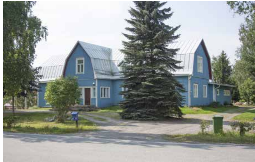
83 Tuomalan Kylänpään päärakennuksen itäjulkisivu ja räystäiden alta pilkistävä punaväri.
