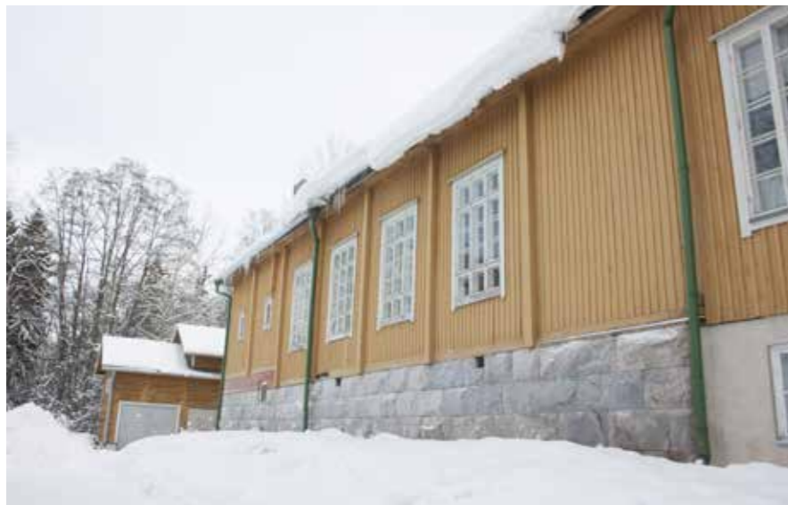
46 Väinölän julkisivua järven puolelta. Uudisosan sokkeli on betonia, vanhassa on kivipaadet.
