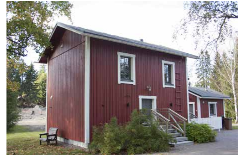
64A Krapin luhtiaitta muutosten jälkeen kesällä 2016.
