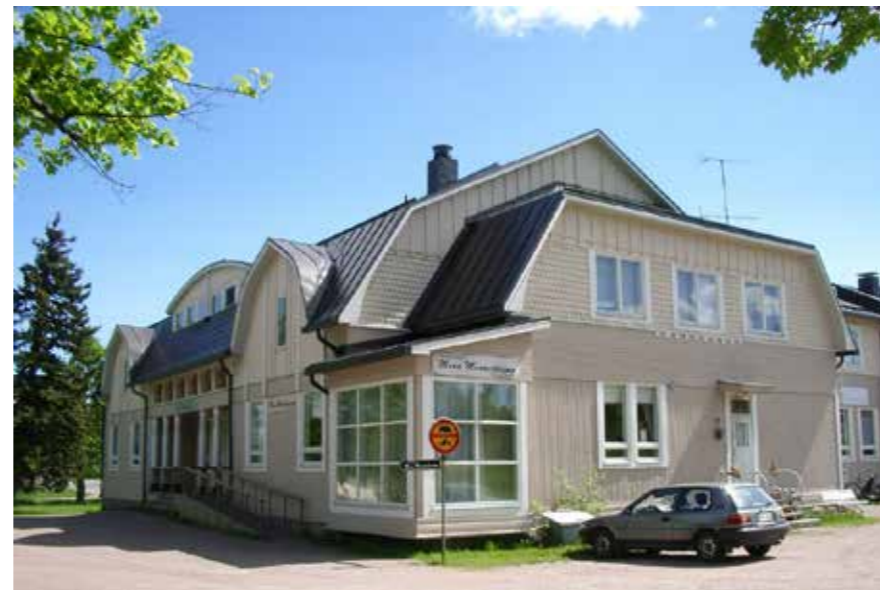
63 Vanhan kunnantaloon muoto on alkuperäinen pohjoisesta päin. PS.
