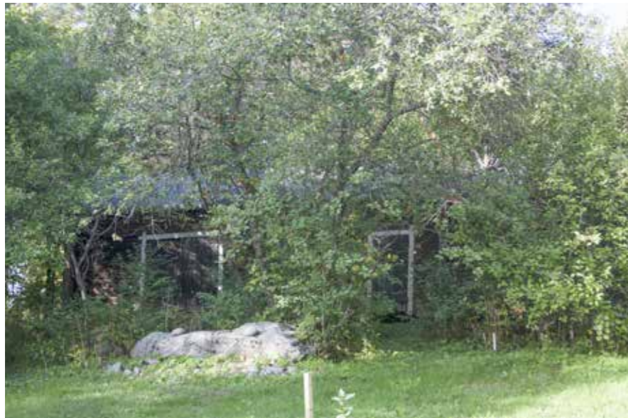
75A Pikku-Toivolan puurakenteinen navetta.
