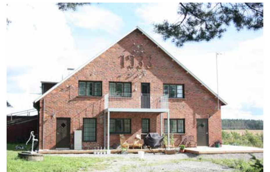
61D Saksan tiilinavetta ja asumiskäyttöön muutettu länsipääty.
