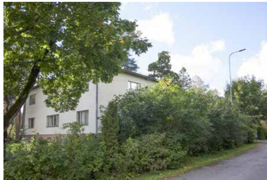
80C Einolan itäjulkisivu.
