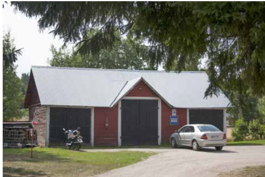
83B Tuomalan Kylänpään puurakenteinen talli.
