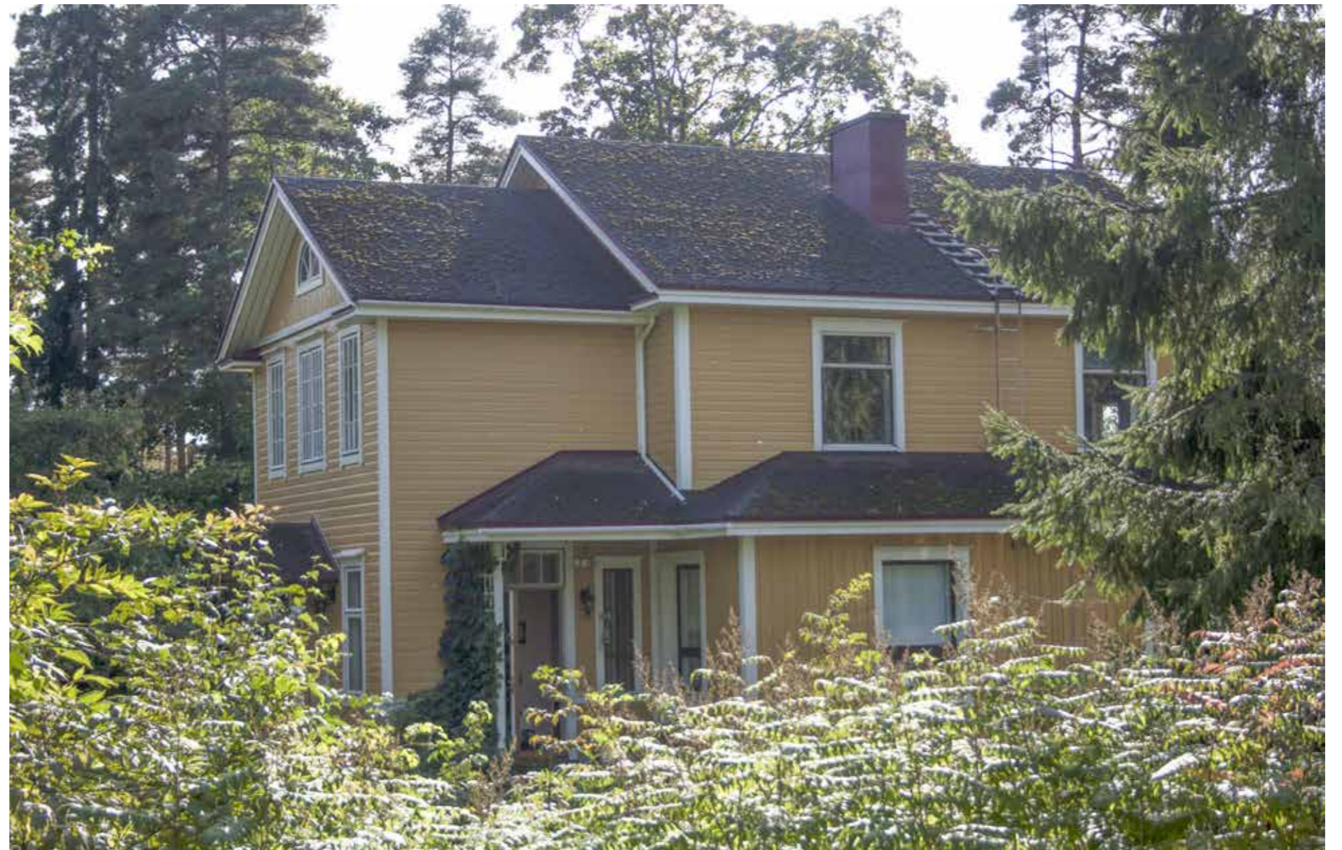
74 Bergbon huvilan pohjoisjulkisivu.
