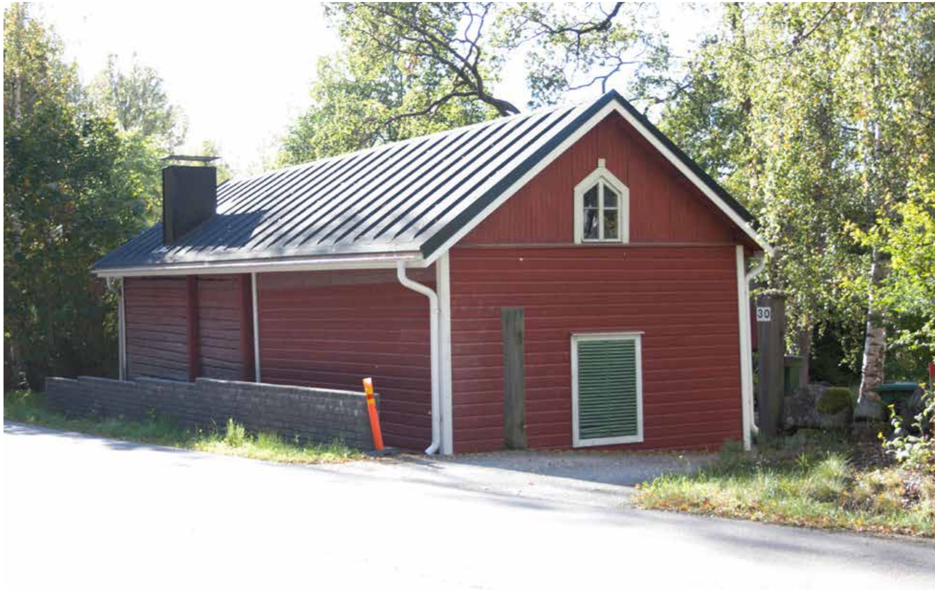
51A Iloniemen pakaritupa korjauksen jälkeen 2016.
