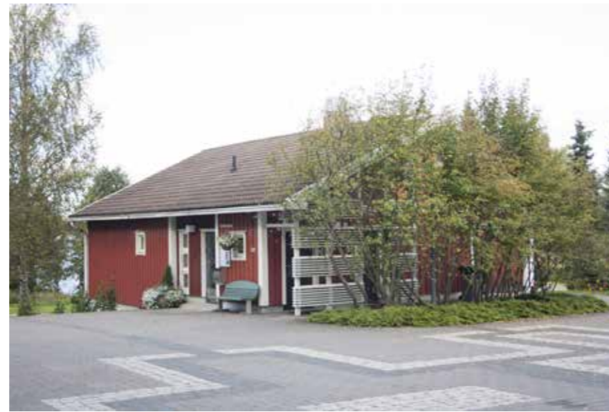
52 Kirkon sivurakennus 1980-luvun alusta.
