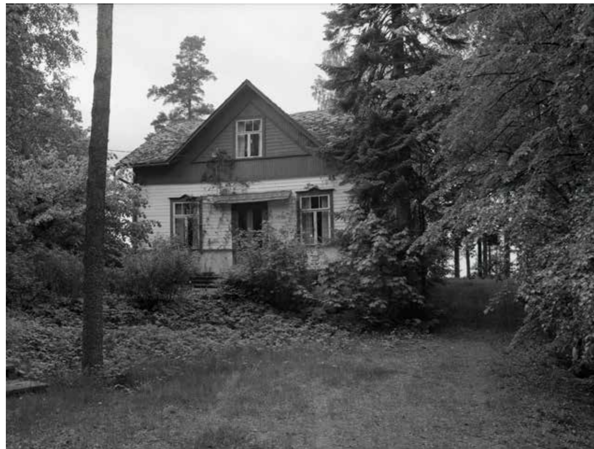
Mustavalkoinen dokumentointi valokuva Rauhalan huvilasta, joka piiloutuu taitavasti, kuvannut István Kecskemét 1989. TM.
