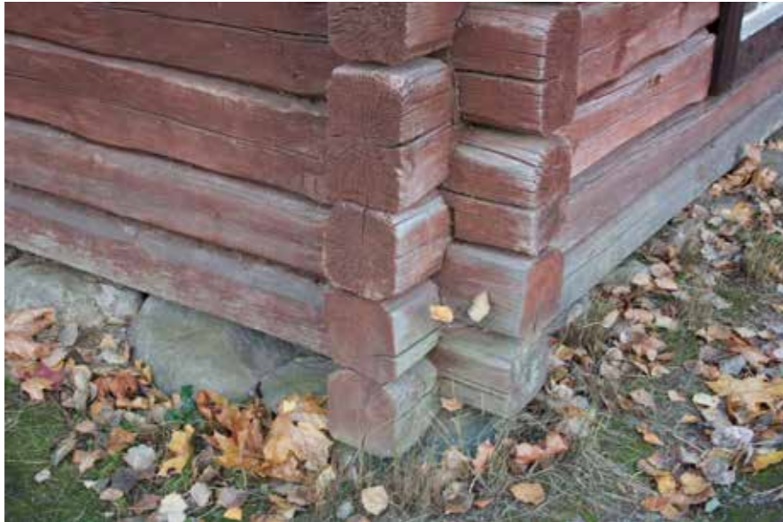
68 Stenvallin pihasaunan alimmat hirret on vaihdettu. Saunassa lienee maalattia.
