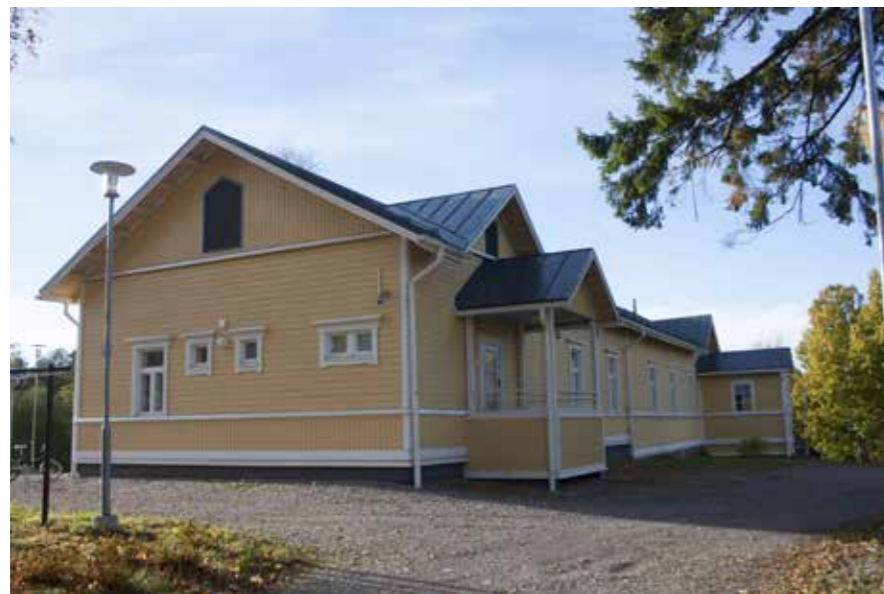
59A Kotorannan uudisosa toistaa vanhan osan muotoa.
