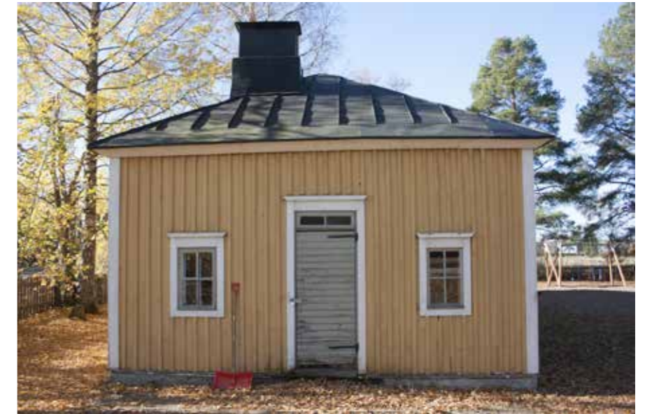
89A Tuomalan koulun piharakennuksen itäpäätä.
