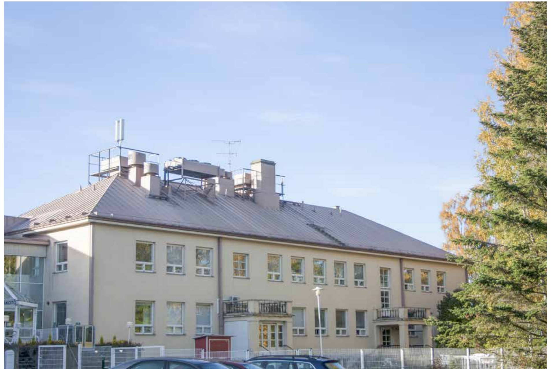
62 Tuuskoto eli kunnallissairaalan vanhin osa - katolla oleva laitteisto on myöhempää lisäystä.
