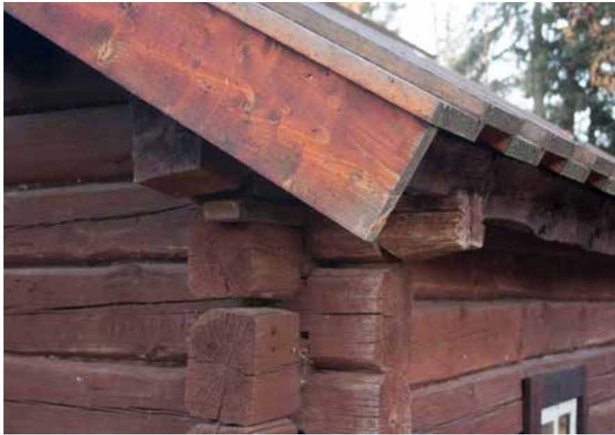
68 Stenvallin mökin pihasaunan nurkka ja uusi lautakatto.
