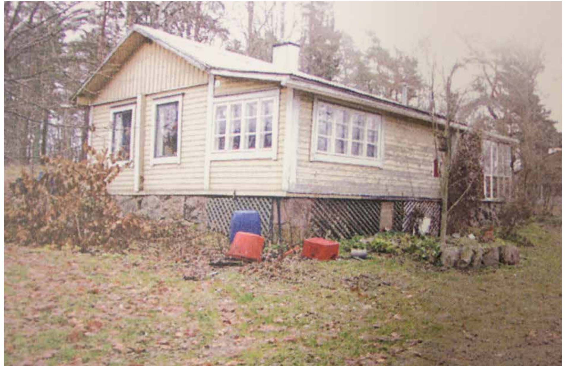
80B Öljymäen asuinrakennus.
