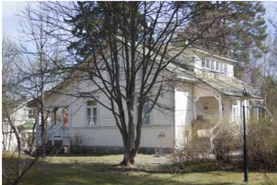
73D Syvärannan vanha puutarhurintalo on ainoa alkuperäinen rakennus huvila-ajalta.
