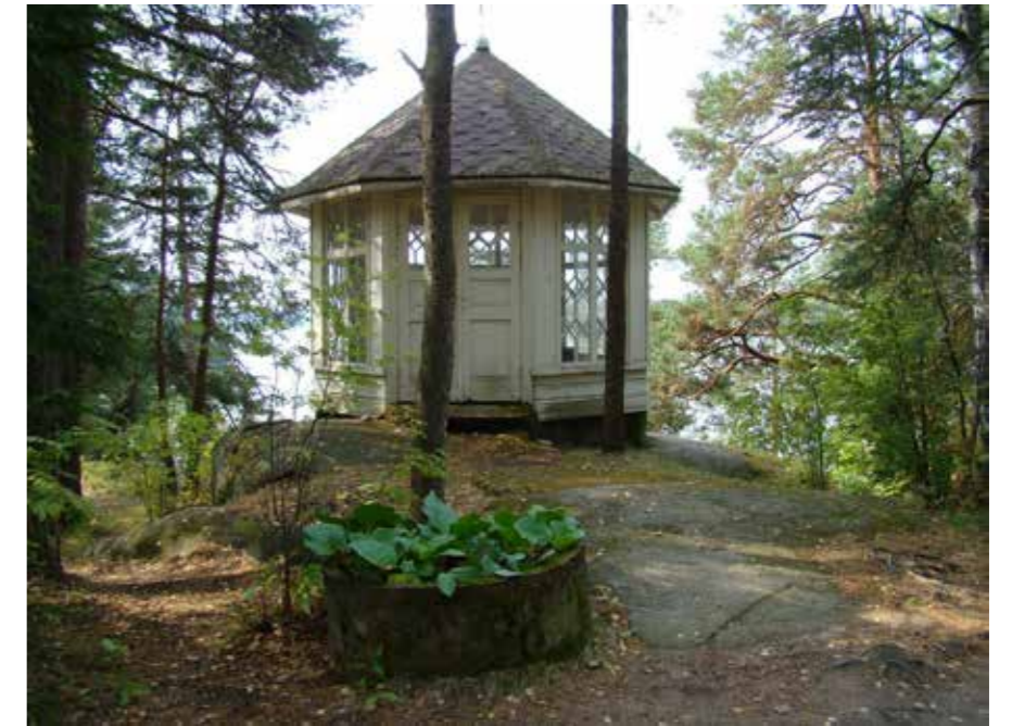
68 Fjällbo vuonna 2011 ennen ikkunoiden levyttämistä.
