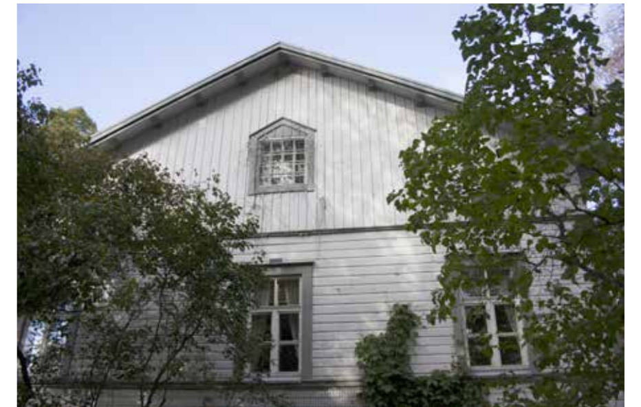
64 Krapin päärakennuksen eteläpääty ja ullakon pikkuruutuinen ikkuna.
