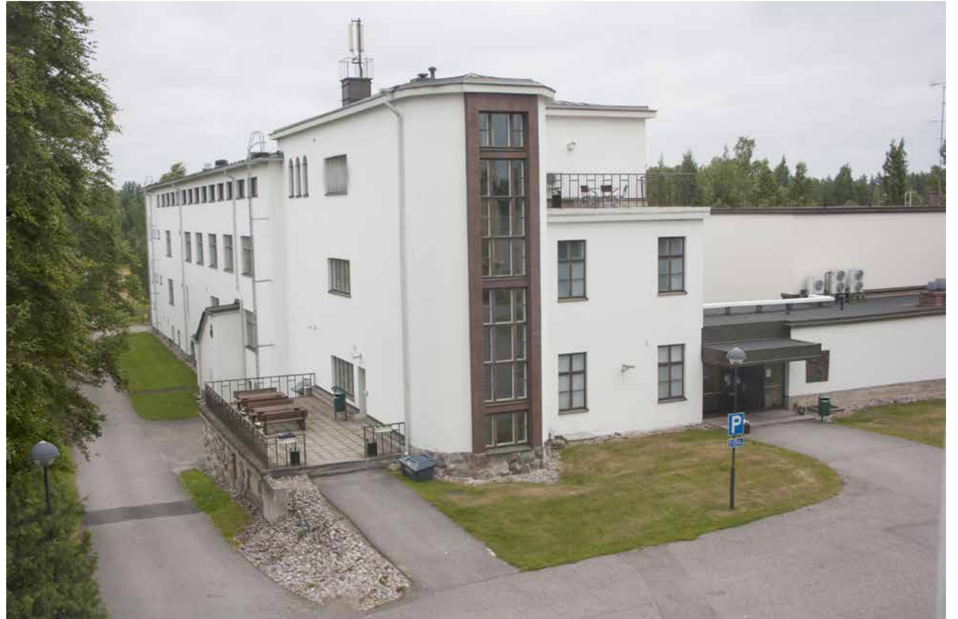
78C Kurssirakennuksen funkista ja klassismia yhdistelevä länsijulkisivu.
