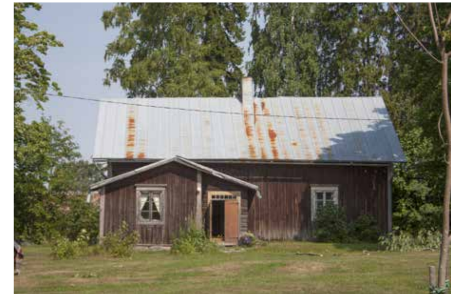
86 Saarelan päärakennuksen eteläjulkisivu.
