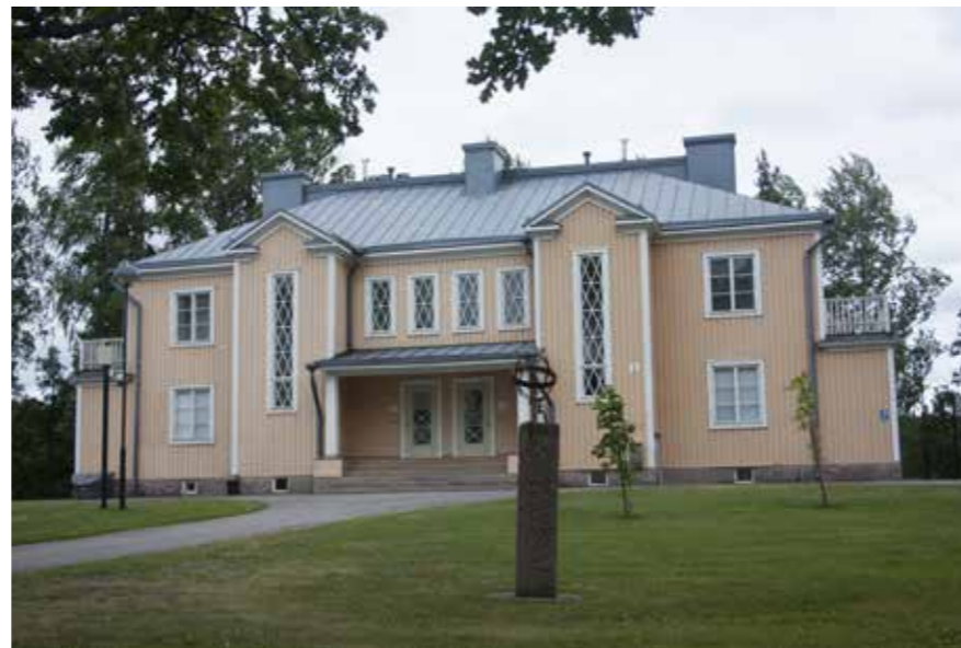
78D Vihmala ja koristeelliset porrashuoneiden ikkunat.
