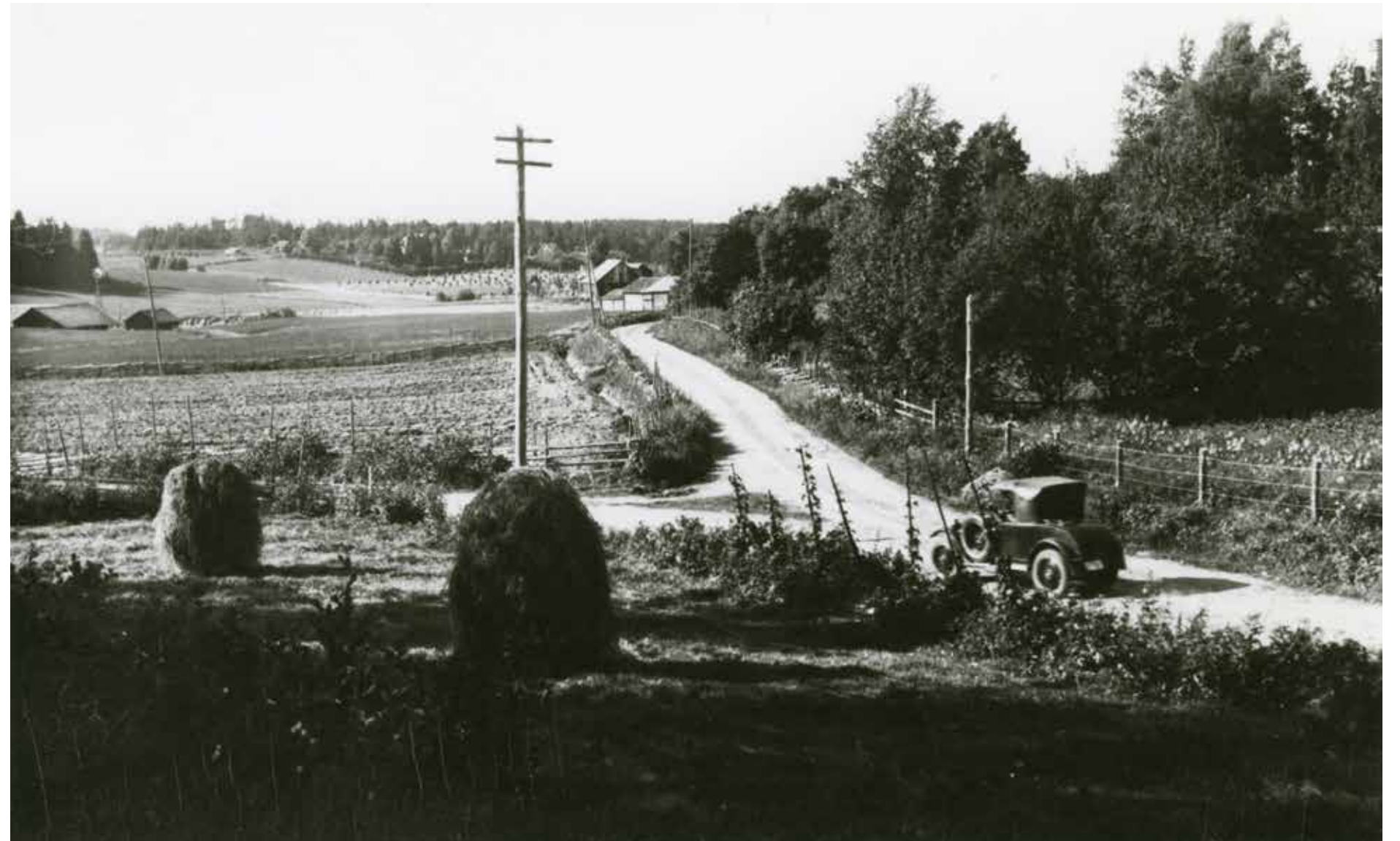
Ruotsinkylän Maisilantie ja kohti Hyrylää vievän tien risteys Övre-Gummin edustalla 1920-30-luvun vaihteessa. Tie on kapea ja noudattelee ikaikaista kulkureittiä. V5555. Tuusulan museo.
