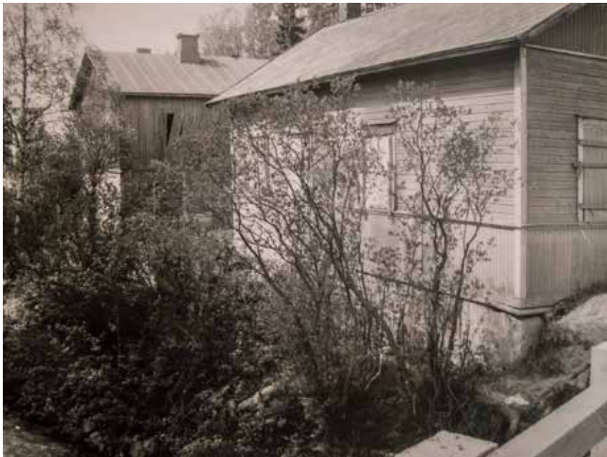
Sama rakennus ennen purkuaan vuonna 1967. Rakennuksen ja sen takana olevan rakennuksen kivijalka on edelleen olemassa. Kuva Kati Kummu. Tuusulan museo.
