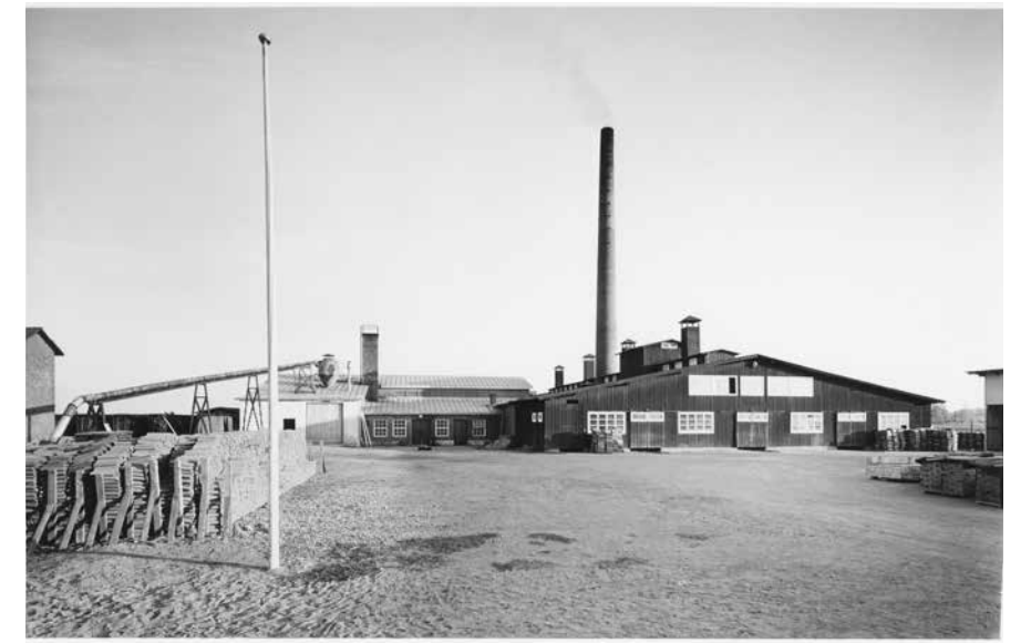
Kolsan tiilitehtaan rakennuksia noin vuonna 1961. Tiilitehtaan tehdasrakennus, vasemmalla ilmeisesti tiilien valmistus (massan sekoitus ja puristus tiiliksi). Oikealla lautaverhoiltu polttouuninsuojarakennus ilmastointihormeineen ja korkea savupiippu. Pihalla vasemmalla salaojaputkia pinottuna. V7493. Valokuvaamo Pohtimo Jokela. Tuusulan museo.
