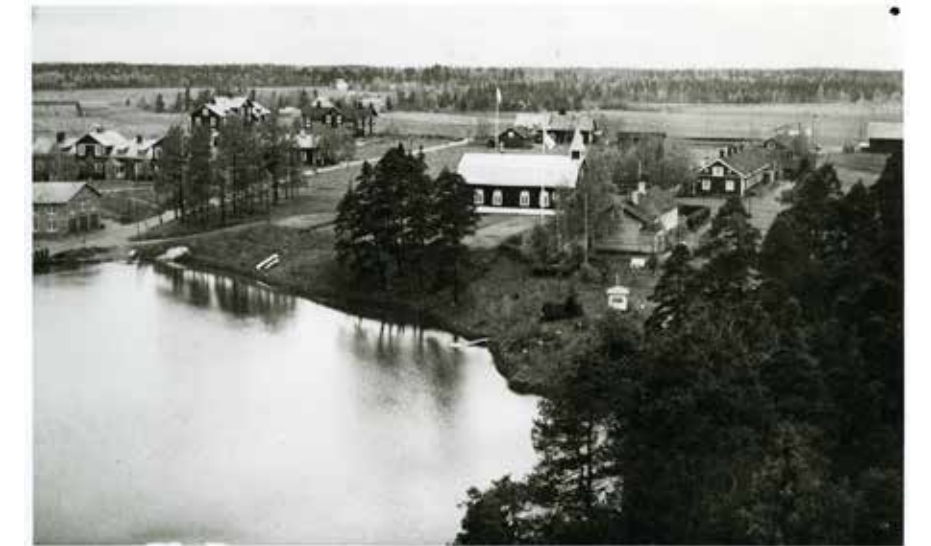
Kellokosken patoaltaan ja kirkonseutua noin vuonna 1933. Vasemmalla näkyy tiilisen autotalli-paloasema -rakennuksen päätyä, jonka takana asuintalot: Uusitalo, Keskitalo, Suurtalo ja Pientalo. Tien oikealla puolella Ruukin kirkko, jonka takana näkyy kaupan talo ulkorakennuksineen. Kirkon oikealla puolella lähellä rantaa kirjasto-koulu-kirjanpitäjätalo, jonka takana Kirkkotalo ja Kaivotalo. Kaupan ja Kaivotalon välissä sikalarakennus, jossa oli asukkaiden sikaboksit ja takana kuvan oikeassa laidassa näkyy osa tehtaan ladosta, jonka jatkeena oli tehtaan riihi. Kuva, Jussi Kangas, V4949. Reprottu kahdessa osassa. Tässä kuvan oikea puoli. V.5027. Ruukin kokoelmat, Tuusulan museo.
