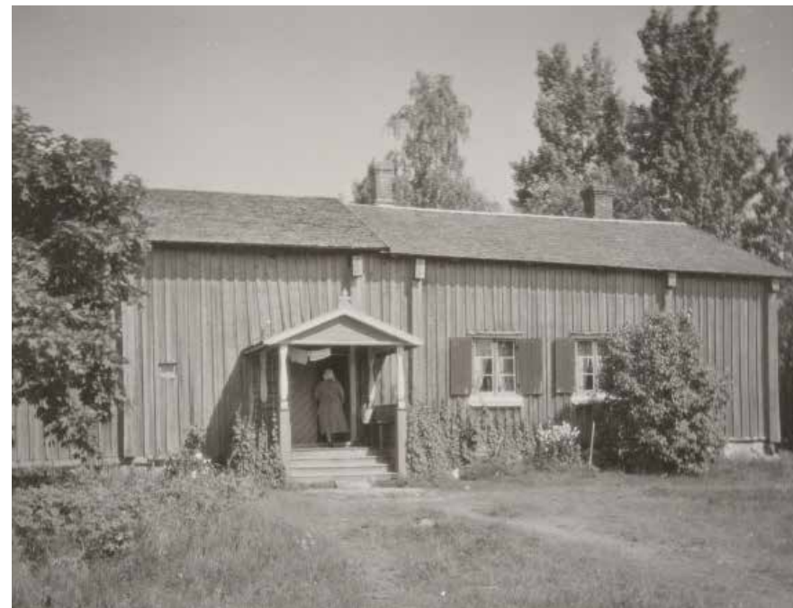
Nummi-Mattilan asuinrakennus vuonna 1929. Kuvassa näkyy selvästi kahdesta eri kehikosta yhdistäminen: myös vesikatto on kahdessa tasossa. KK1929:408 Kansatieteen kuvakokoelma. Museovirasto. Kuva Esko Aaltonen.
