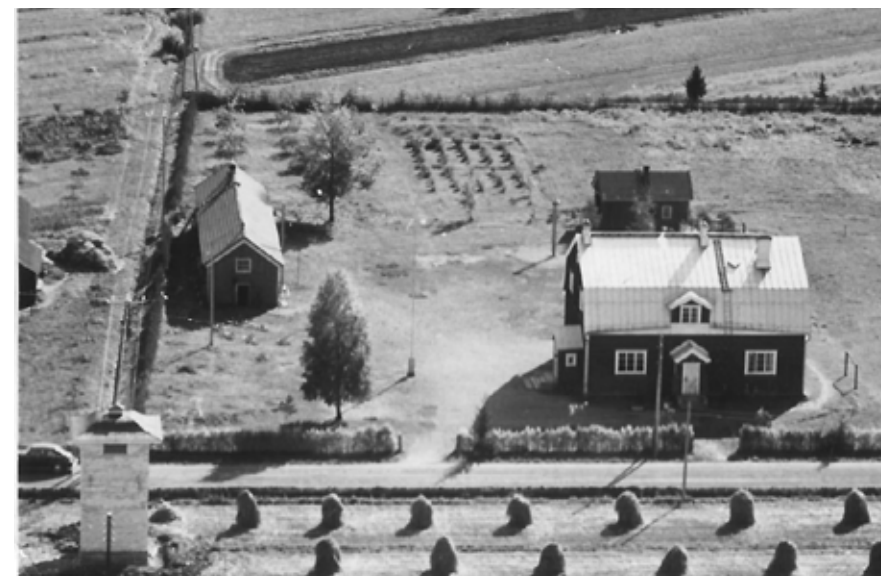
Kellokosken Aimolanpellon muuntamo ja Kellokosken vanha kansakoulu. Kuvassa näkyy hyvin tornin tunnusomainen kattomuoto. Kuva Martti Järvinen.
