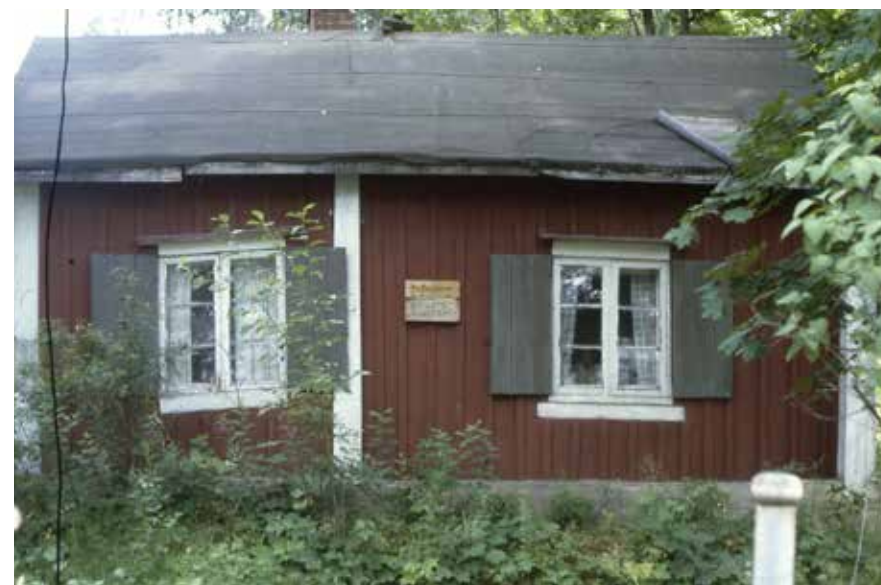
Turkin suutarin mökki Rantatiellä vuonna 1986, pääjulkisivu Rantatielle päin. Ikkunoissa on luukut. Kivijalka on silattu valesokkelilla. D1310. Kuvaaja Ulla Anttonen. Tuusulan museo.
