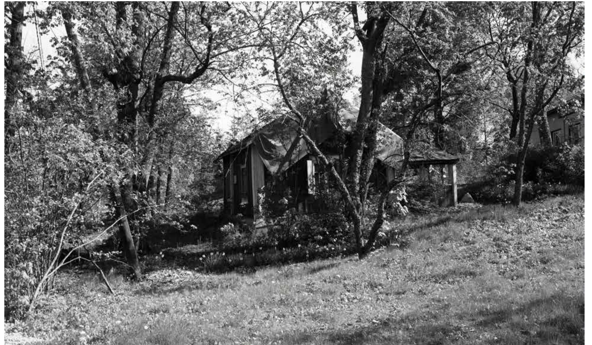
Korjausta odottava Turkin suutarin mökki alkukesällä 1989 tai 1990. Vuotava huopakatto on peitetty rakennuspressulla. V6719_31. Kuvaaja István Kecskemét. Tuusulan museo.
