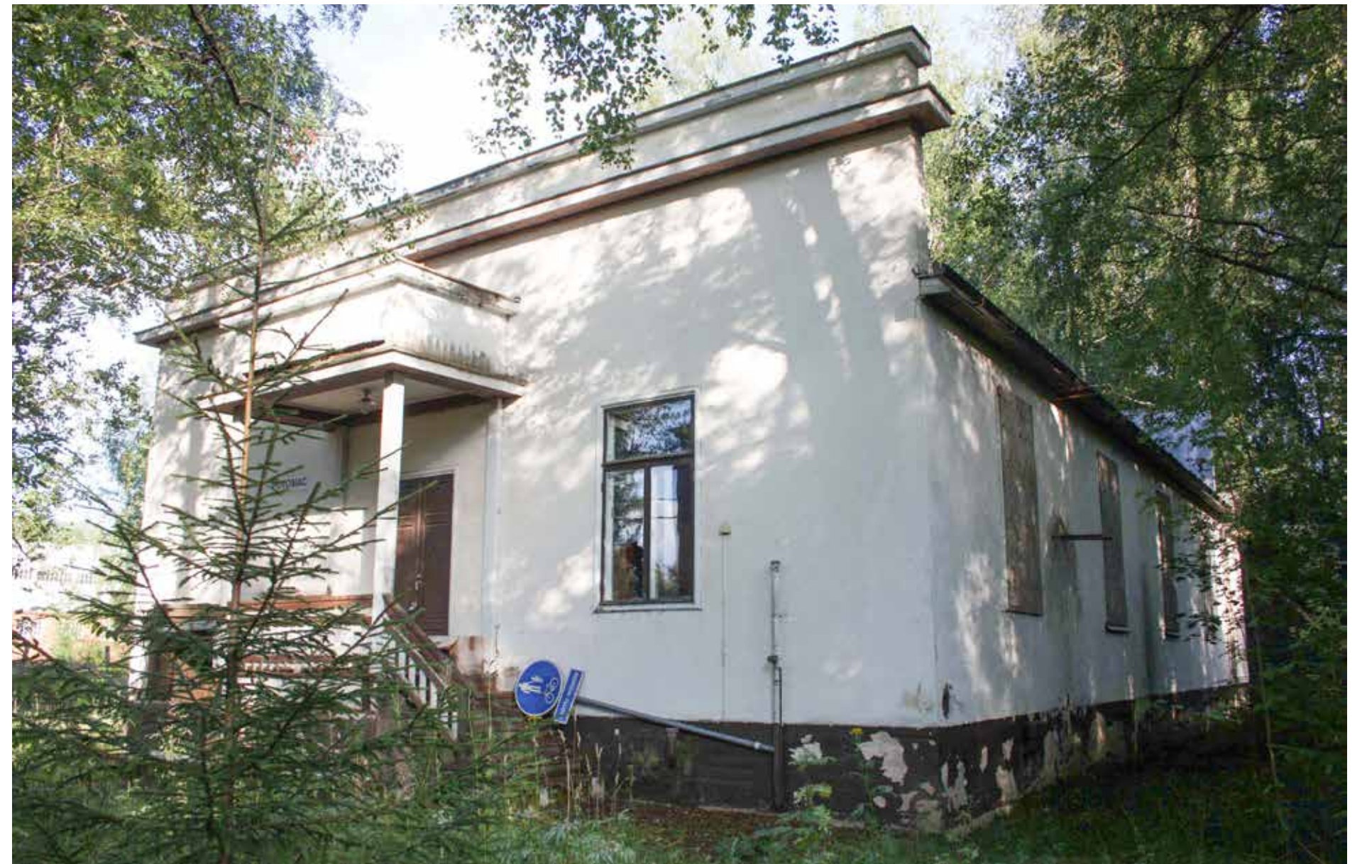
Laatikkotehtaan konttori edustaa Tuusulassa harvinaista uusklassismin ja funktionalismin sekoitusta valetasakattoineen.
