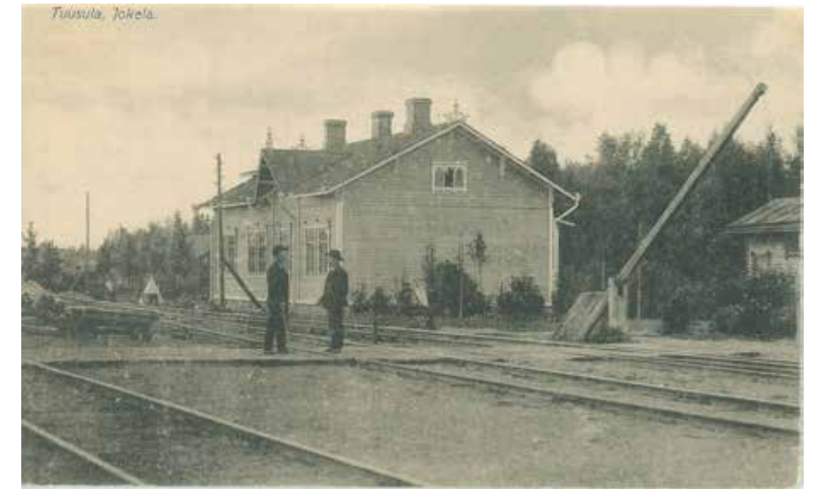
Rautatien tasoylikäytävä Jokelan asemarakennuksen pohjoispuolella 1900-luvun alussa. Asemalla oli myös varastomakasiineja, rautatieläisten asuinrakennuksia, huoltorakennuksia ja toisinaan myös putka kuten Jokelassa. Oikealla puolella näkyy puomi, jolla tasoylikäytävä suljetaan kun juna on tulossa. Radan oikealla puolella (länsipuolella) puinen koristeellinen VR:n asuintalo, joka on edelleen olemassa Siljalantien ja Asemapolun päässä. Kuvaaja: A. Pellinen, Tuusulan museo.
