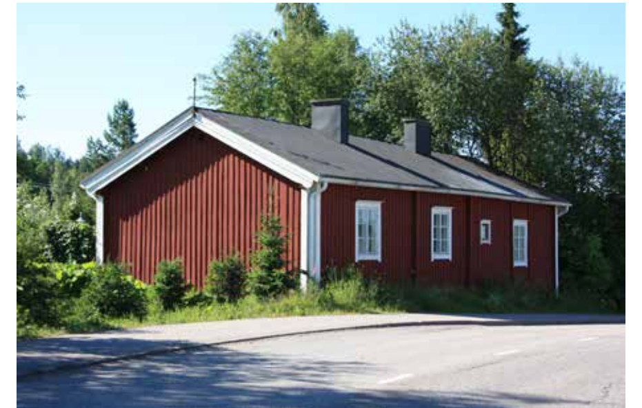
12 Nedre-Gummin sotilasvirkatilo. PS.
