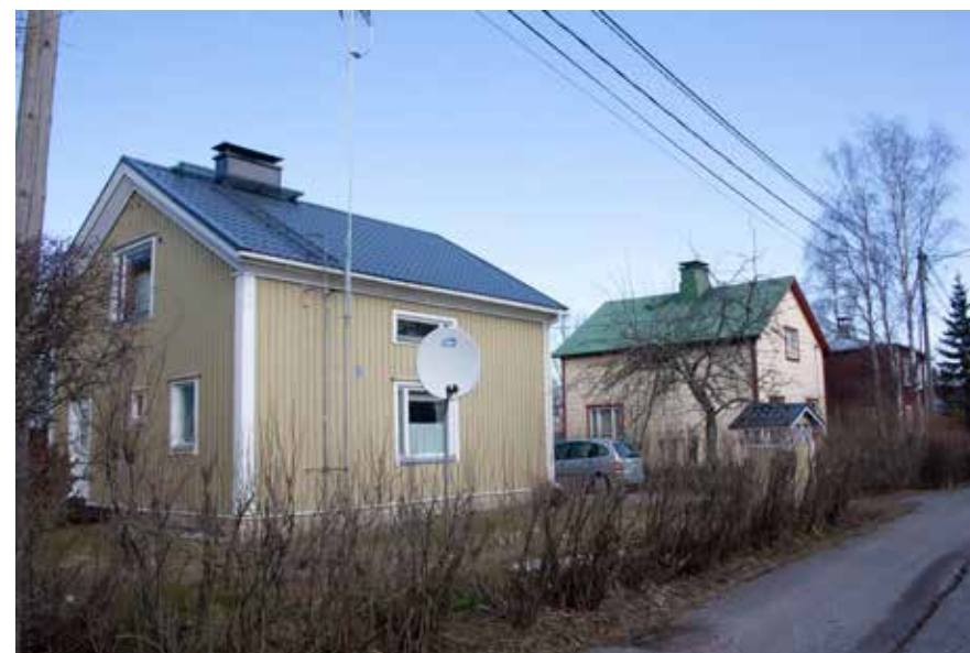
Tiriläntien jälleenrakennuskauden talot ja 1930-luvun talot sopeutuvat hyvin toisiinsa. Useita on muodistettu mm. mineriittiverhouksella 1970-luvun ”huoltovapaaseen” henkeen.
