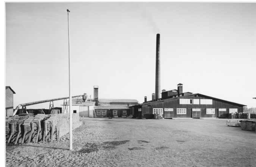
Kolsan tiilitehtaan uunirakennus ja kuivaamot. Tuusulan museo.
