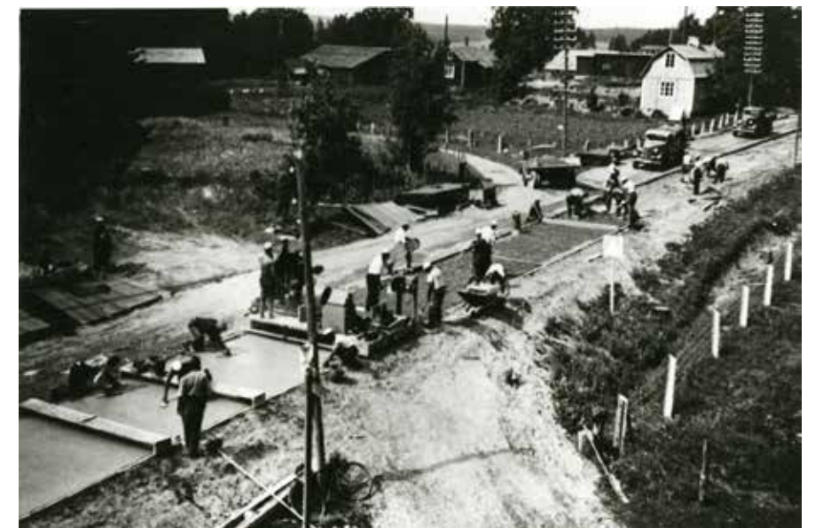
Hämeentien rakennustyömaa Hyrylään eteläpuolella kesällä 1938. Tien pinta valettiin betonista saksalaisen autobahn -mallin mukaan. v5948. Tuusulan museo.
