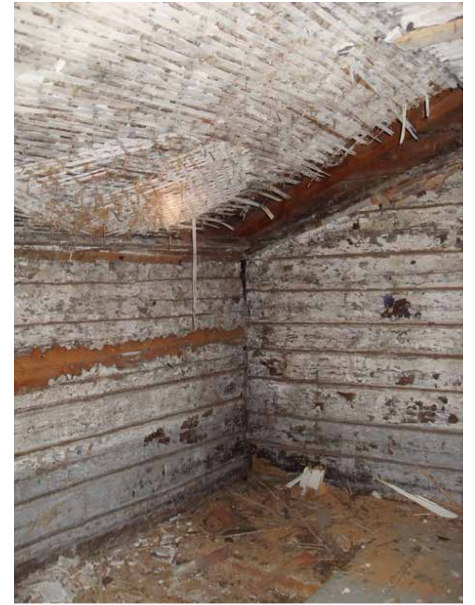
Toimelan eteläpäädyn yläkerrassa on seinillä savirappausta ja alakatossa on ristitikutus savirappausta varten.
