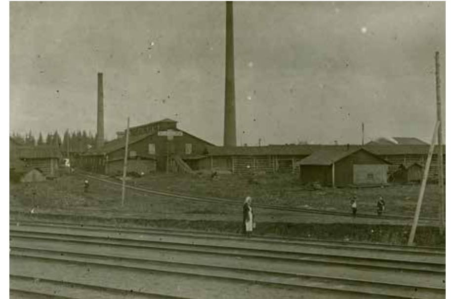
Jokelan Tiilitehtaan rakennukset vuosien 1917-1929 välisenä aikana. Tehdas eli uunit piippujen välissä, ympärillä kuivaamot, edessä rautatie ja tehtaalle vievä sivuraide. Rakennuksen päädyssä teksti: Jokela tegelbruk. V8290. Tuusulan museo.
