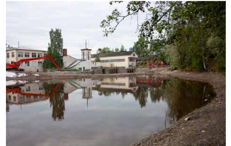
Kellokosken patoallasta muokataan pohjapadoksi ja tekokoskeksi vuonna 2016.
