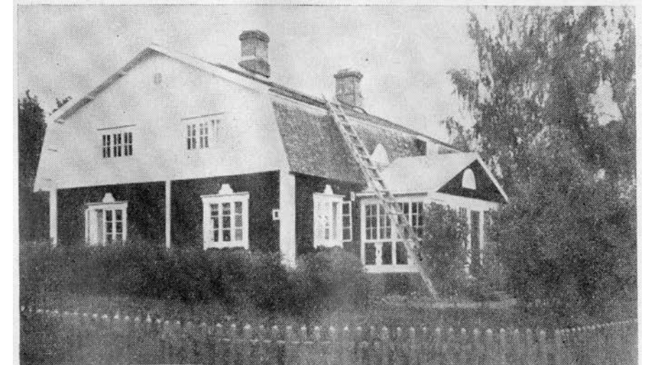
Ruotsinkylän Lindbergin Kaura. Kaksikerroksinen salilla ja tuvalla sekä frontonilla varustettu suuri ja syvärunkoinen maalaistalo. Taitekatto. Jugendvaikutteita. Mahdollisesti Thomén käsialaa. Umpikuisti julkisivussa. Vuodelta 1911. Kohde 9. Kuva on Suomen kartanot ja Suurtilat- kirjasta.
