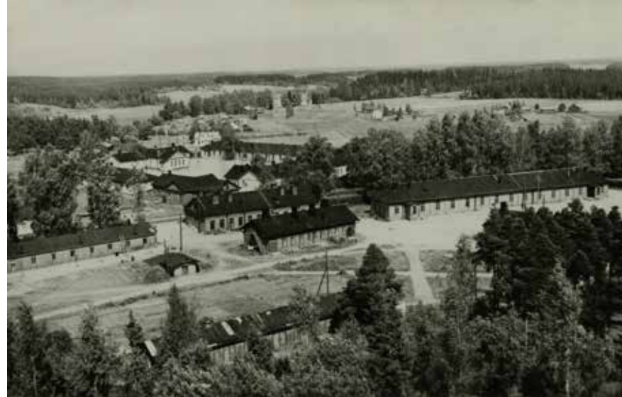
Varuskunta-alue ja Hyrylän keskusta 1940-luvulla. Kuvattu ortodoksikirkolta. Etualalla näkyvät vanha pitkä ja matala puinen varastorakennus, entinen tiilirakenteinen ruokala, jonka edessä toinen varastorakennus. Ruokalan oikealla puolella pitkä hirsirunkoinen rakennus, ns. rakennus 10, joka rakennettu 1860-luvulla. Tien toisella paikalla on keskusneliön ympärillä 1860-luvun vaiheen puukasarmit, jotka purettiin 1960-luvun loppupuolella. Keskusneliön paikalla on nykyisin Tuusulan terveyskeskus. Neliössä olevien talojen takana (nurkassa) näkyy Ljungbergin - Rantasen leipomo-kahvilarakennus, joka purettiin 1980-luvun alussa, kun uusi kunnantalo rakennettiin sen paikalla. Kaukana rannassa näkyy Koskensillan saha. V.7157. Tuusulan museo.
