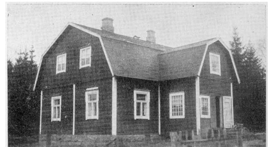
Vanhankylän Kivimäki. Kaksikerroksinen salilla ja tuvalla varustettu maalaistalo. Taitekatto ja poikkipäätty. Jugendvaikutteita. 1910-luvulta. Kuva on Suomen kartanot ja Suurtilat- kirjasta.
