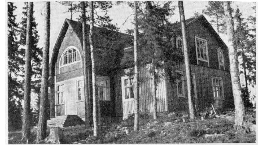
Ristinummen Hongisto. Kaksikerroksinen salilla ja tuvalla varustettu maalaistalo. Taitekatto ja poikkipäätty. Jugendvaikutteita. 1910-luvulta. Kuva on Suomen kartanot ja Suurtilat- kirjasta.
