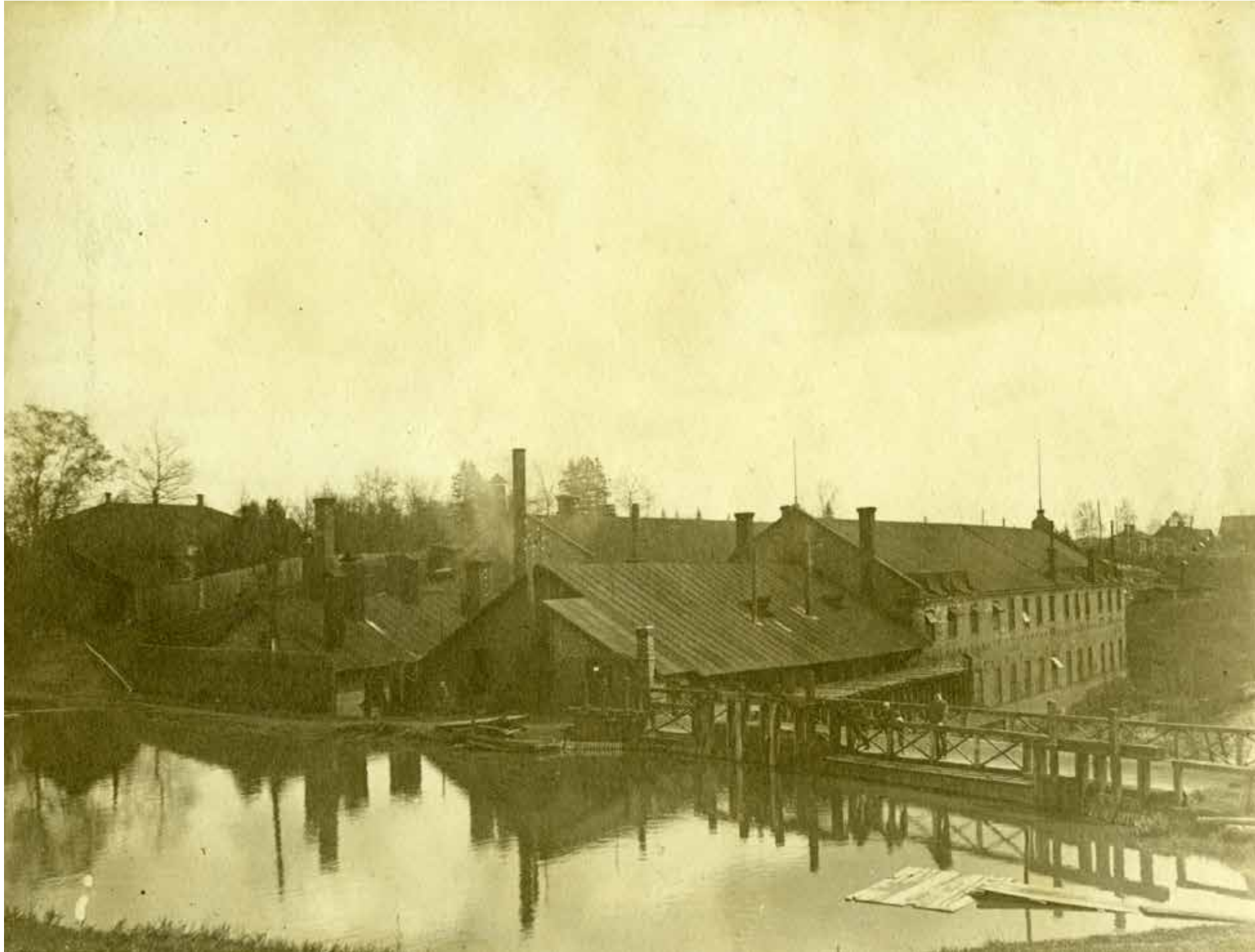
Teollisuuden nousu seurasi rautatien rakentamista, vaikka Kellokoskella olikin ollut ruukki jo 1800-luvun alusta. Kuvassa laajentuneen tehtaan pato ja patoallas. Padon vieressä vanha paja vesiränneineen, sen takana aliverstas ja pajan vasemmalla puolella valimo. Kuva on 1900-luvun alusta, pian vuoden 1898 tulipalon jälkeiseltä uudisajalta. Vasemmassa reunassa häämöttää Kellokosken kartanon vanha aumakattoinen päärakennus. V3498. Kellokosken ruukin kokoelmat. Tuusulan museo.
