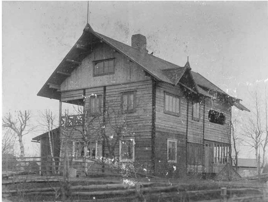
Vastavalmistunut Erkkolan hirsihuvila 8.11.1908. Huvila on kuvassa vielä laudoittamaton, joten vanhan mökin, josta Erkkola laajennettiin, hahmo näkyy tummempina hirsinä. V7951. Tuusulan museo.
