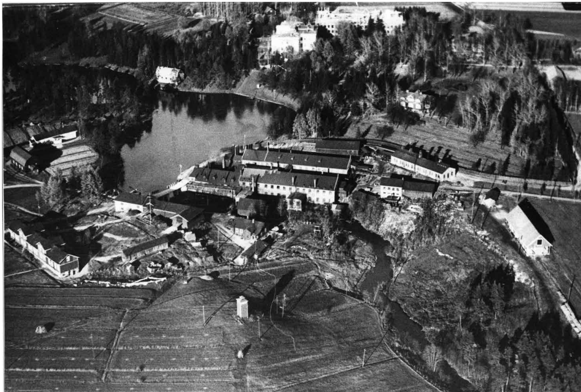
Ilmakuva tehtaan ympäristöstä 1930-luvun alusta; sairaalan Keskitaloa rakennetaan ja kirkko on vielä vailla Carlanderin kruunukoristeita. MeKen kokoelmat.
