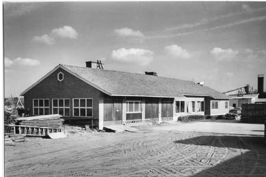
Kolsan Tiilitehdas Oy:n konttorin autotallipääty vuonna 1961. Rakennus edusti 1950-luvun romanttisia piirteitä sisältänyttä ruotsalaistyyliä, jonka yksi tunnus oli kuusikulmion eli hunajakanno-muodon käyttö ikkunoissa. V7479. Vilho Laiho. Tuusulan museo.
