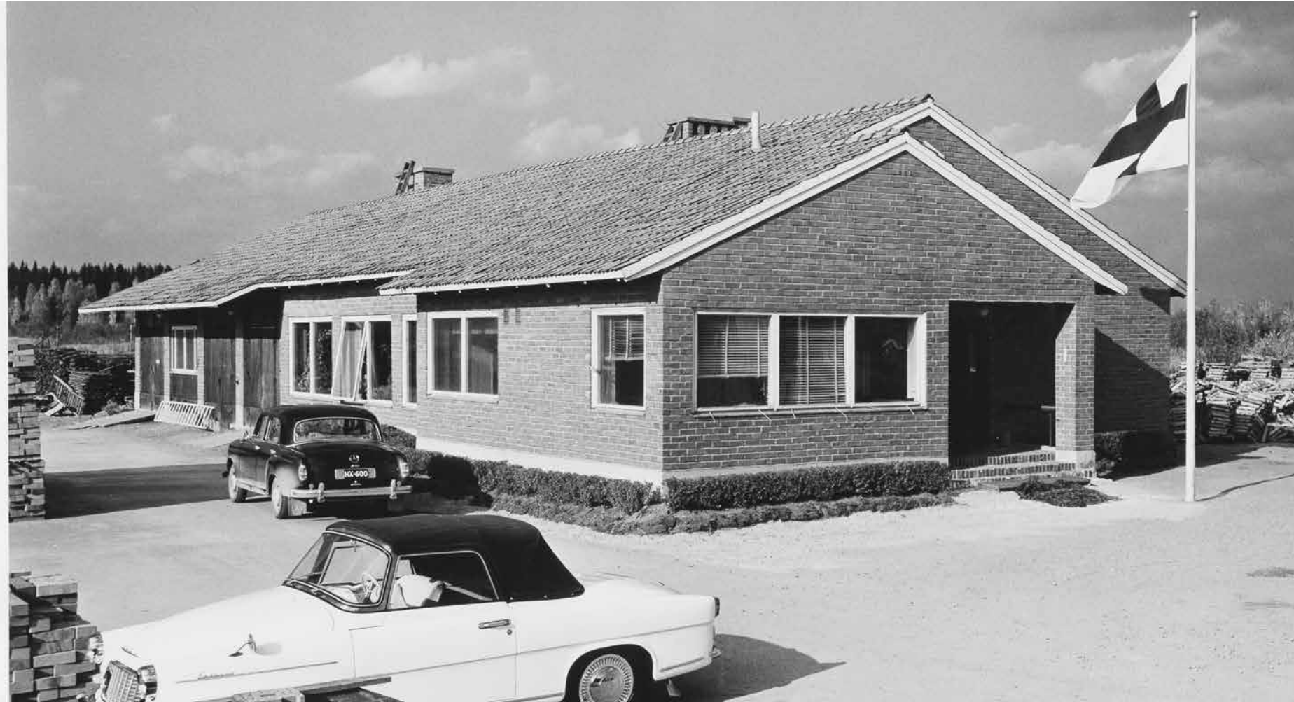
Kolsan tiilitehtaan konttori ja pääsisäänkäynti. Tuusulan museo
