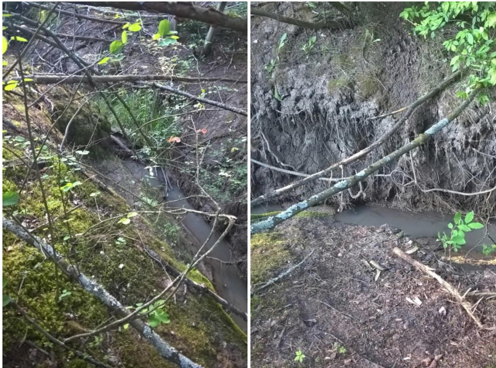
Kuva 6.22. a) ja b) Uoman alaosalla on voimakasta eroosiota.
