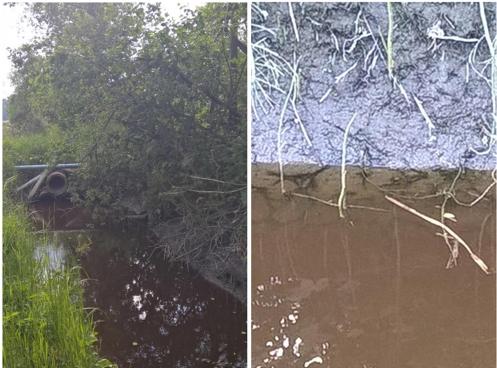
Kuva 5.26. a) Uomaan on asennettu liian pienet rummut, jotka ovat ylävirran puolelta täynnä roskaa. b) Uoman pohjassa on mustaa tuntematonta likaa ja veden väri on koko purossa erikoinen.
