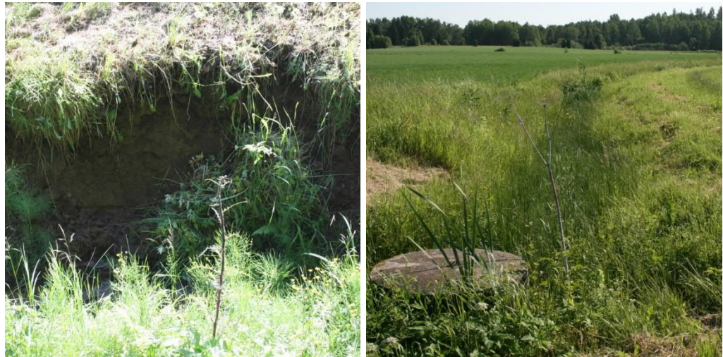
Kuva 5.5. a) Pellon reuna on syöplynyt uoman haaran kohdalta. b) Uoma jatkaa putkitetun osuuden jälkeen avo-ojana peltoaukealla.
