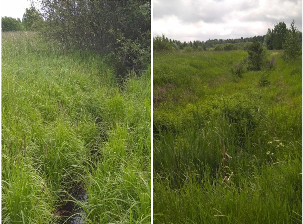
Kuva 4.14 a) Uoma virtaa peltoaukealle. b) Suurten sivuojen jälkeen uoma on suuri ja jyrkkäpenkkainen, jonka yläosissa näkyy eroosiovaurioita.
