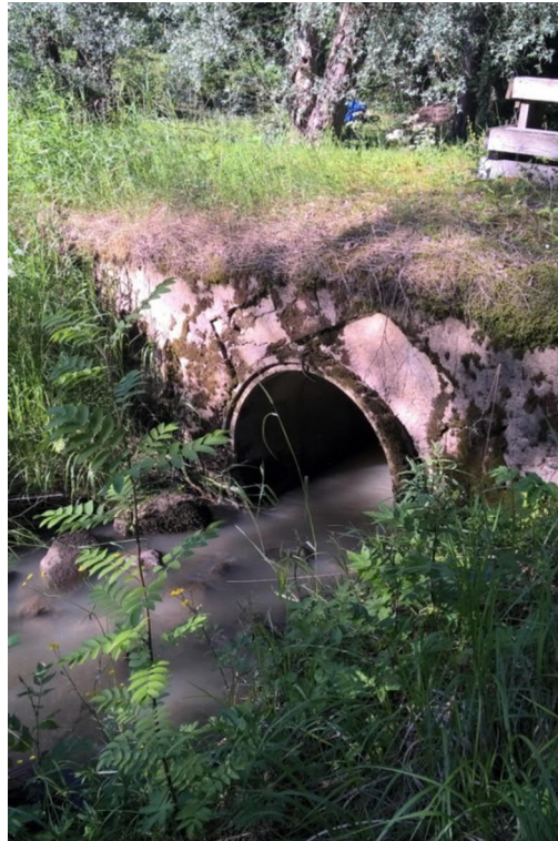
Kuva 6.6. Uoman betonipato, jossa on rumpu.
