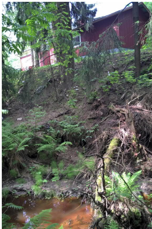
Kuva 5.23. a) Penkkasortuma eroosion takia Lillmalmintien pohjoisosassa. b) Uoma jatkaa pelto-ojana putkitetun osuuden jälkeen.
