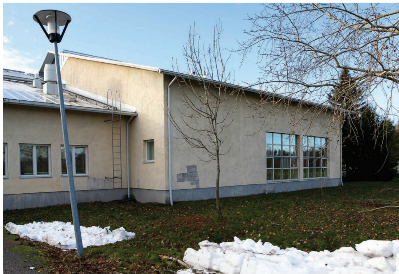
Yllä: kuva 32, 1989 laajennusosa, ruoka- ja juhlasalin julkisivu
