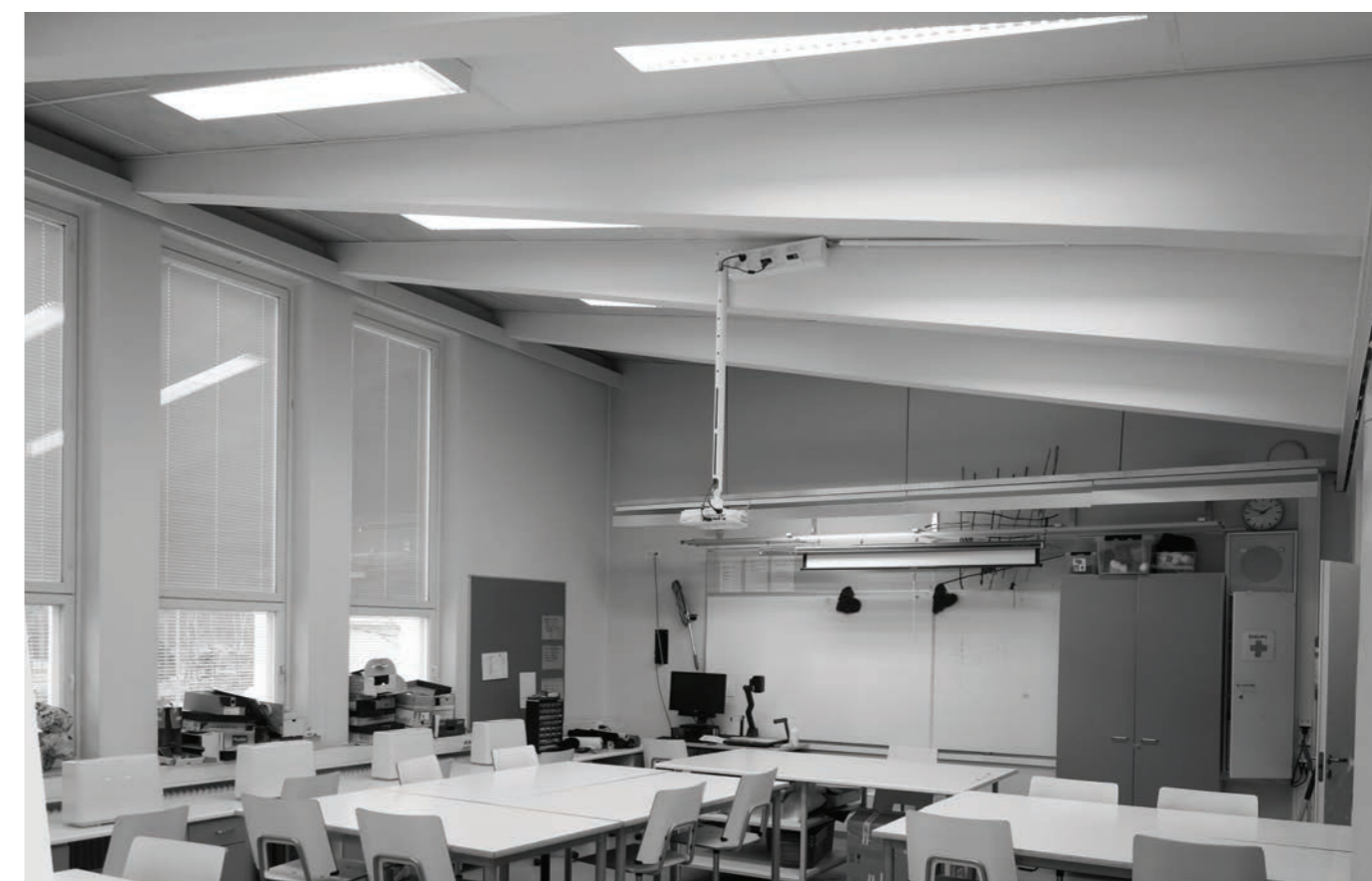
Yllä: kuva 28. Ullakkokerroksen luokkahuone, alakattopalkit
