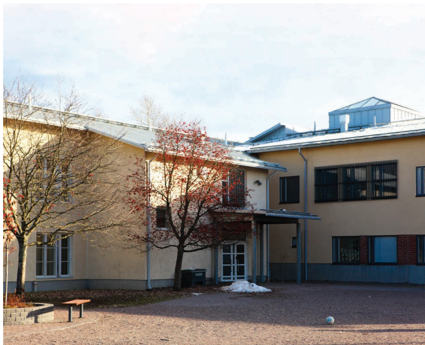
Yllä: kuva 45, 2007 laajennusosan julkisivu länteen ja liittyminen 1989 laajennusosaan
