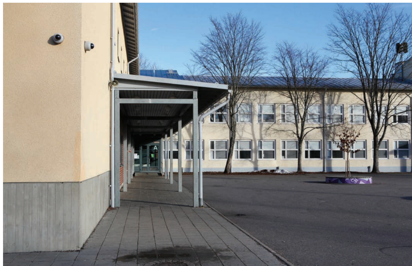
Yllä: kuva 47, 2007 laajennusosan sisäänkäyntikatos
