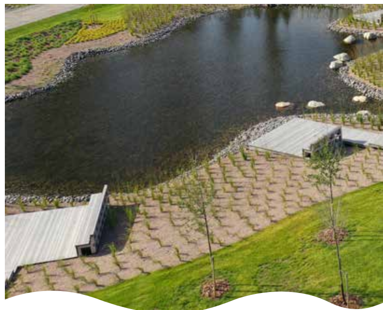
Hulevesialtaat Puustellinpuistossa Kuva: Tuomo Halmetoja
