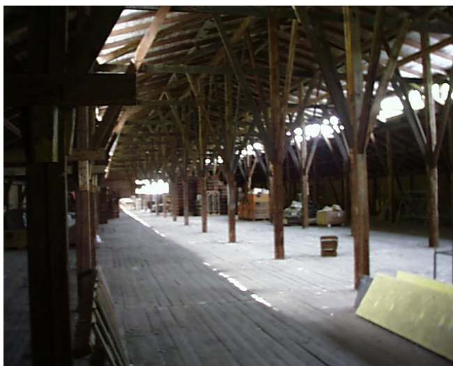
Laatikkotehtaan varaston sisätillaa
