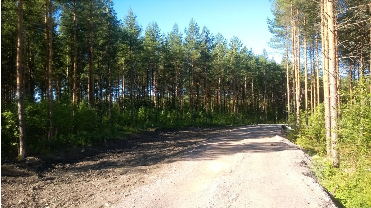
Kuva 4. Rakenteilla oleva tie kuviolla 1.
