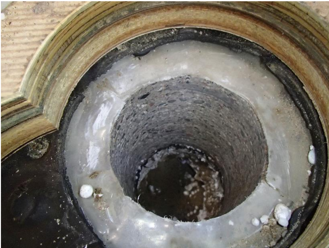
Kuva 9. Rakenneavauksen RAKL2 rakenteet.
