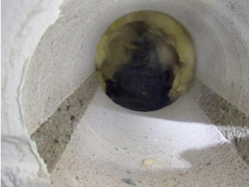
Kuva 2. Rakenneavaus RAKS1 liikuntasalin ulkoseinärakenteeseen.
