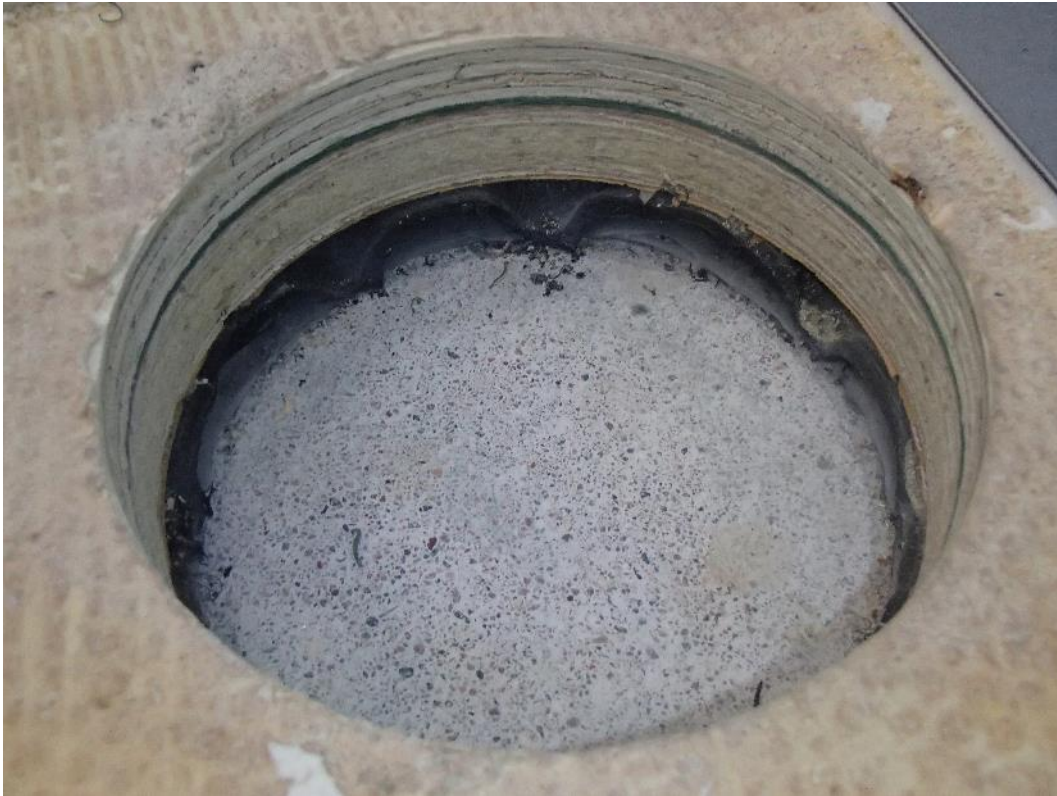
Kuva 7. Rakenneavauksen RAKL1 rakenteet.
