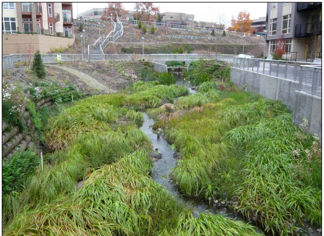
Kuva 12. Esimerkki rakennetusta kanaalista, jossa on kasvillisuutta ja reilusti tulvatilaa. Kohde sijaitsee Seattlessa, Yhdysvalloissa. 12
