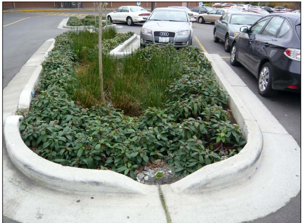
Kuva 9. Pysäköintialueen yhteydessä oleva biopidätysalue. 9
