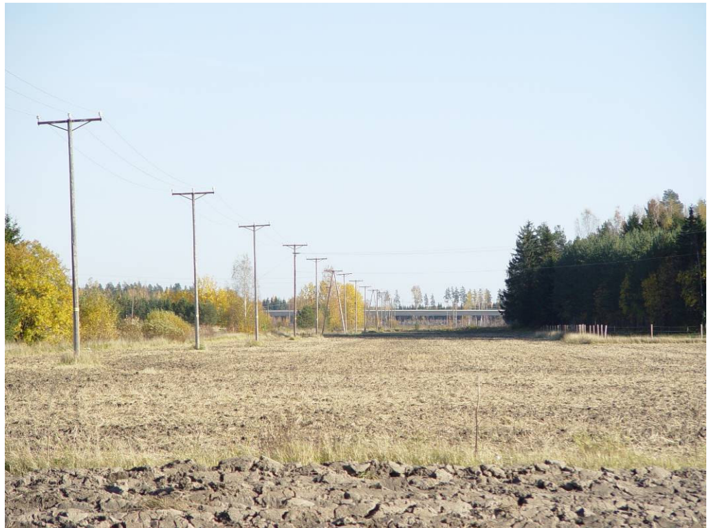
Kuva: Sähkölinit muodostavat pitkiä pylväsrivistöjä. Näkymän päättää rautatiesilta.
