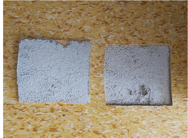
Kuva 28: Luokan L27 VOC-materiaalinäytteessä ei havaittu poikkeavia VOC-pitoisuuksia.
