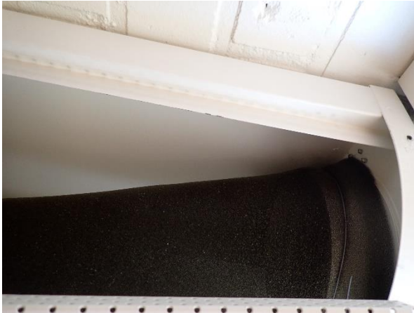
Kuva 11: luokka L27, syrjäyttävän ilmanvaihdon päätelaitteeseen lisätty jälkeen päin suodatinkangas ja kiinnitetty rautalangalla.
