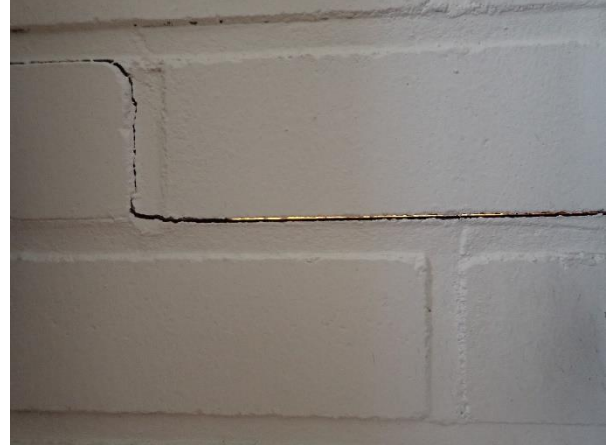
Kuva 5: Väliseinärakenteissa halkeilua.
