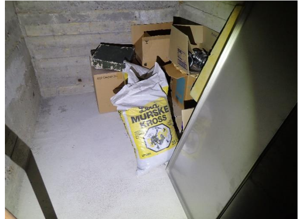
Kuva 19: Auditorion alaosan tekniikkahormissa säilytetään betonista alapohjaa vasten orgaanisia materiaaleja.
