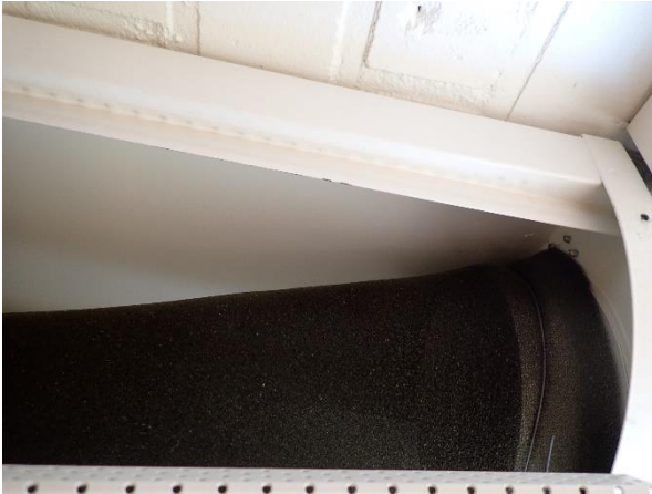
Kuva 11: luokka L27, syrjäyttävän ilmanvaihdon päätelaitteeseen lisätty jälkeen päin suodatinkangas ja kiinnitetty rautalangalla.
