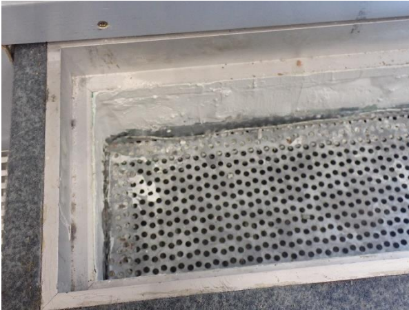
Kuva 15: Auditorion portaikon tuloilmapäätelaitteiden kehykset on tiivistetty.
