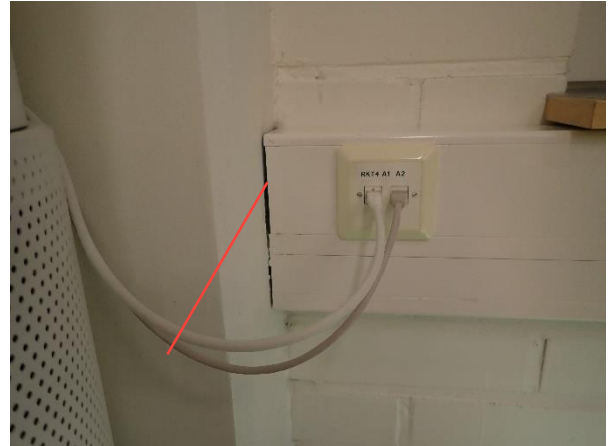
Kuva 12: L23 luokassa sähkökoteloinnissa havaittavissa mineraalivillaa.
