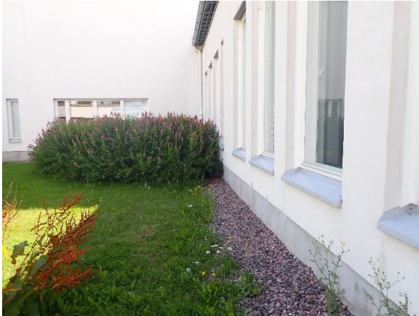
Kuva 24: Rakennuksen ulkopuolella on sorakaista rakennuksen vierustalla, mutta kasvillisuus on liian lähellä ulkoseinää.
