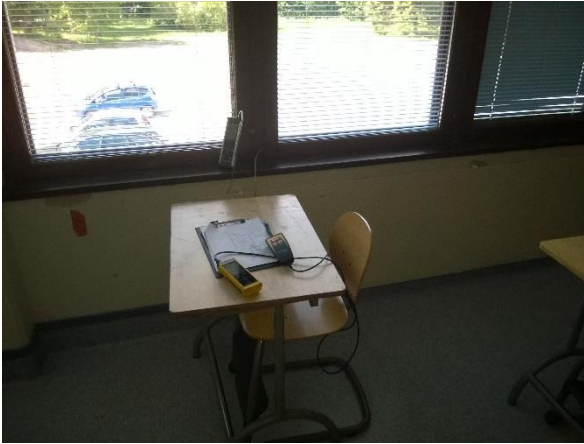
Kuva 20: Luokkatila 6. Vuotoja ei havaittu normaalissa käyttötilassa, kun tilat olivat n. +30 Pa ylipaineiset.
