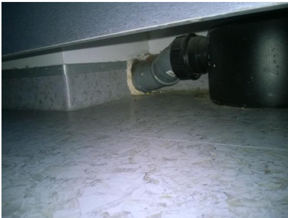
Kuva 4: Tilan 129 viemärikotelointiin johtava vesipisteen viemäri. Liitos on tiivis.
