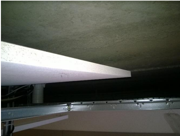
Kuva 2: Alakattolevytykset ovat pinnoitettuja akustolevyjä.
