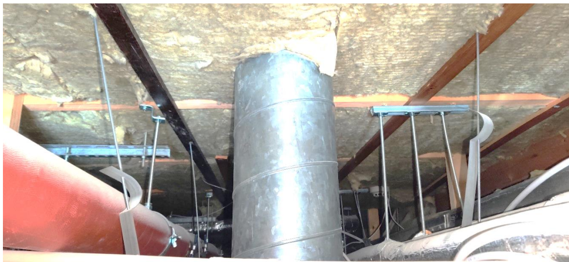
Kuva 22 Käytävän 118 IV läpivienti
