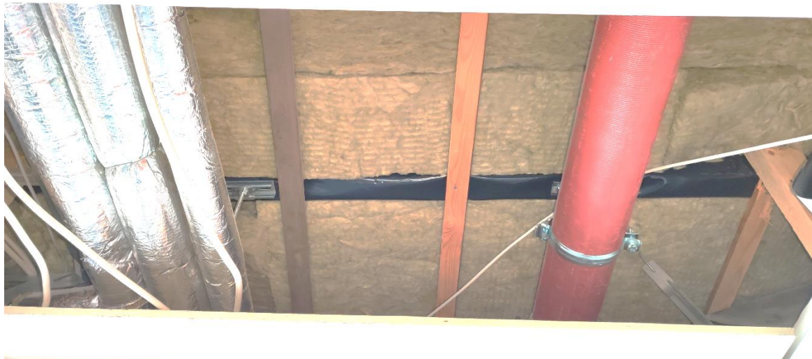
Kuva 21 käytävän 118 alakaton eristevilloja
