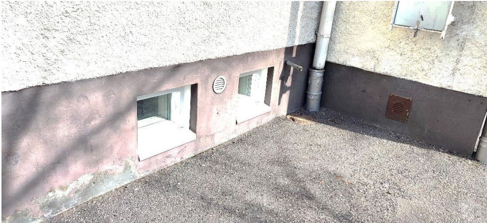
Kuva 31 Piha on asfaltoitu. Näkymä 002 edusta pihalla. Patolevyistä tai perusmuurin ulkopuolisesta kosteuseristyksistä ei ole tietoa. Sadevesisyöksyt johdetaan maan alle.
