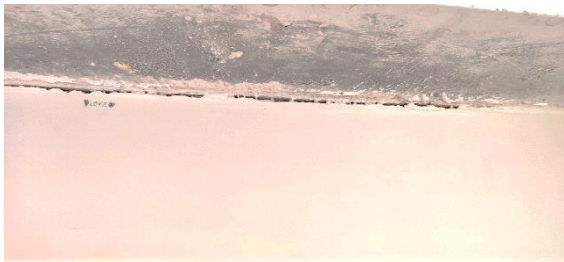
Kuva 8 Ikkunalaudan liittymissä rakoja
