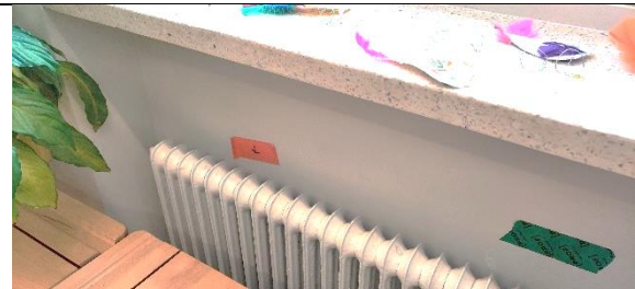
Kuva 12 Molemmat patterikannakkeet vuotavat
